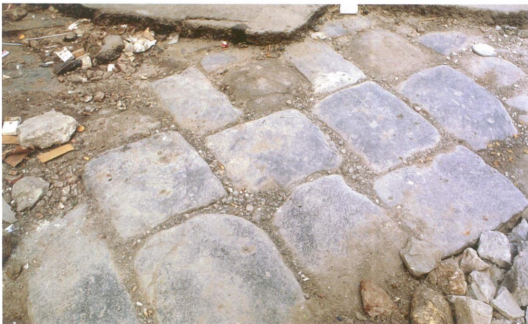
Οι αυθεντικές γρανιτόπλακες του περασμένου αιώνα κάτω από την άσφαλτο που ο Δήμος Θεσσαλονίκης ξαναχρησιμοποίησε.
