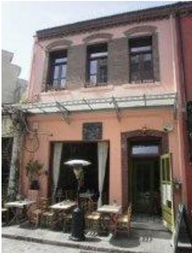
Εικόνα 3.3.1: Πρόσωση του κτηρίου.
