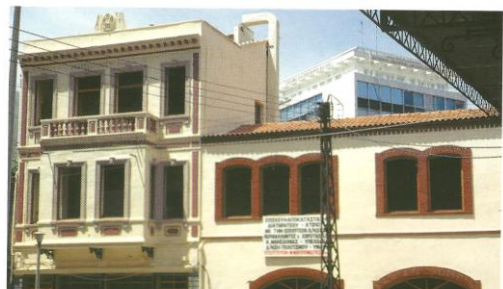
Εικόνα 1.3.9: Κτήρια της οδού Κατούνη με αριθμό 9, 9 α πριν και μετά την επέμβαση.
