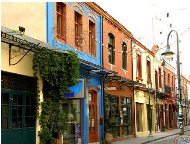
Εικόνα 4.1.1: Όψη της οδού Αιγύπτου, μετά την επέμβαση ΔΙ.ΠΕ.ΧΩ.Κ.Μ.
