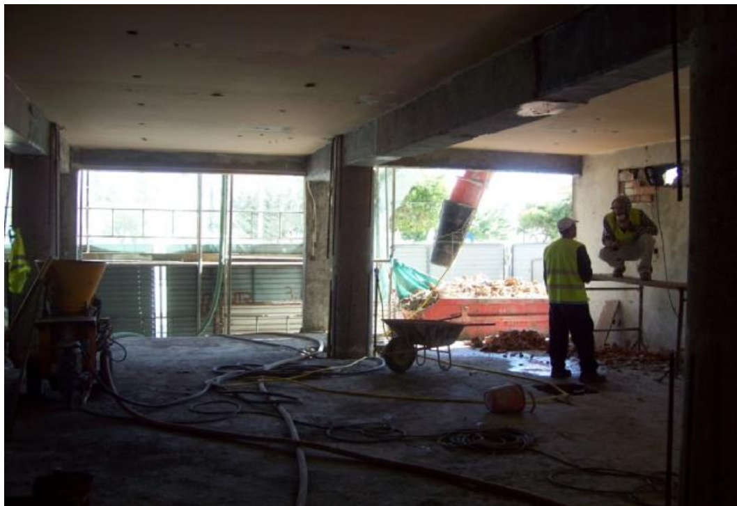
Εικόνα 7.2.10 Εξοπλισμός για εκτοξευμένο σκυρόδεμα
