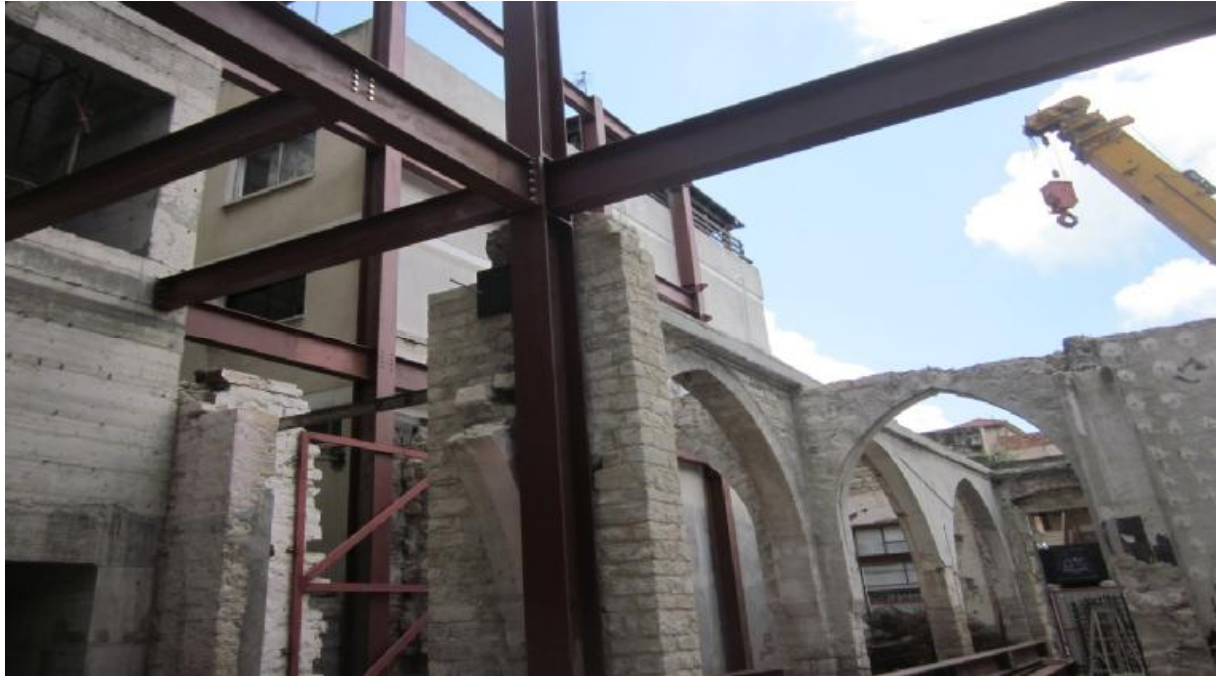
Εικόνα 7.2.13 Δέσιμο φέρουσας τοιχοποιίας με την μέθοδο των ελκυστήρων
