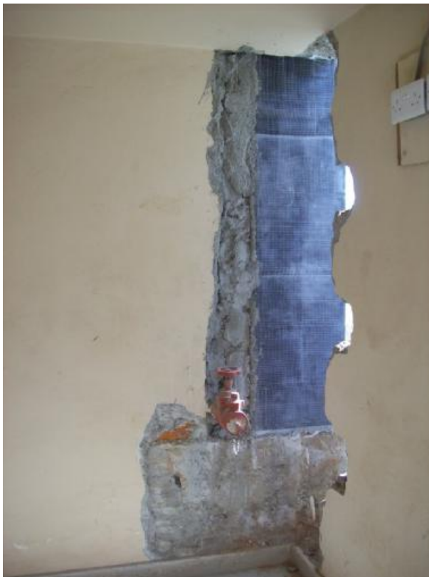
Εικόνα 7.2.6 Ενίσχυση τοιχώματος με την μέθοδο των ινοπλισμένων πολυμερή
