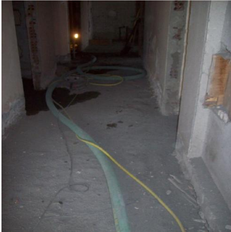
Εικόνα 7.2.9 Εξοπλισμός για εκτοξευμένο σκυρόδεμα
