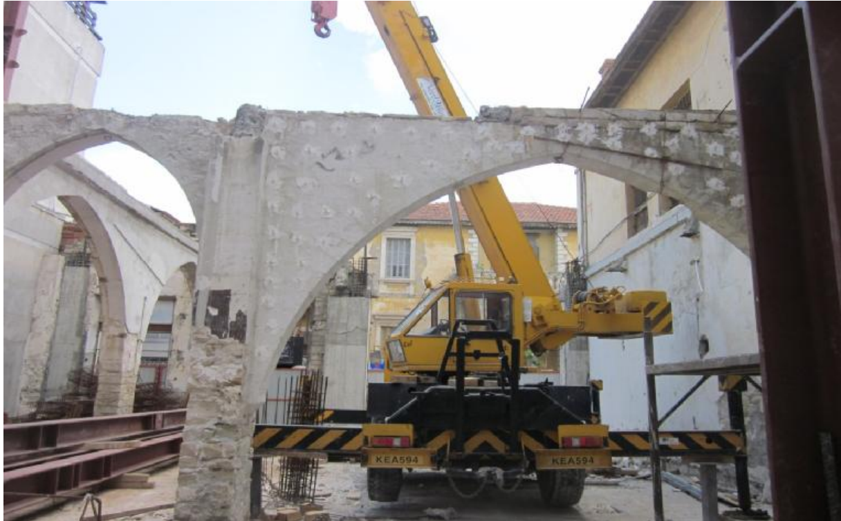
Εικόνα 7.2.11 Αποκατάσταση τοιχοποιίας με την μέθοδο των ενεμάτων
