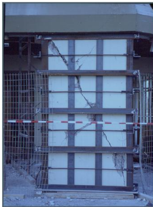
Σχήμα 5.2.11 Επέμβαση με μεταλλικό κλώβο για προσωρινή ανάληψη κατακόρυφων φορτίων
