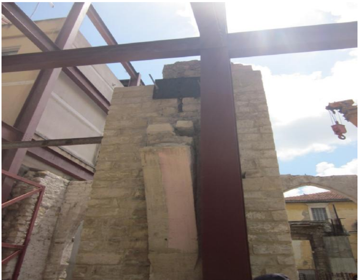
Εικόνα 7.2.14 Δέσιμο φέρουσας τοιχοποιίας με την μέθοδο των ελκυστήρων
