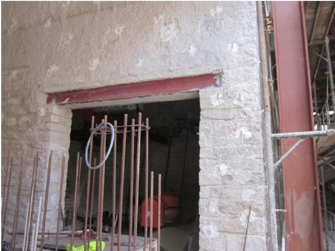
Εικόνα 7.2.12 Αποκατάσταση υπερθύρων σε φέρουσα τοιχοποιία με ενσωμάτωση μεταλλικού δοκού
