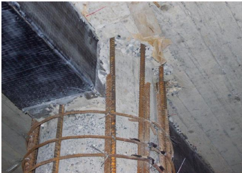
Εικόνα 7.2.2 Συνέχεια οπλισμού μανδύα στον επόμενο όροφο
