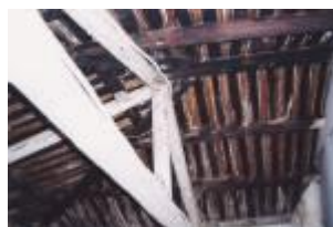
Εσωτερική άποψη στέγης με "παπά"
