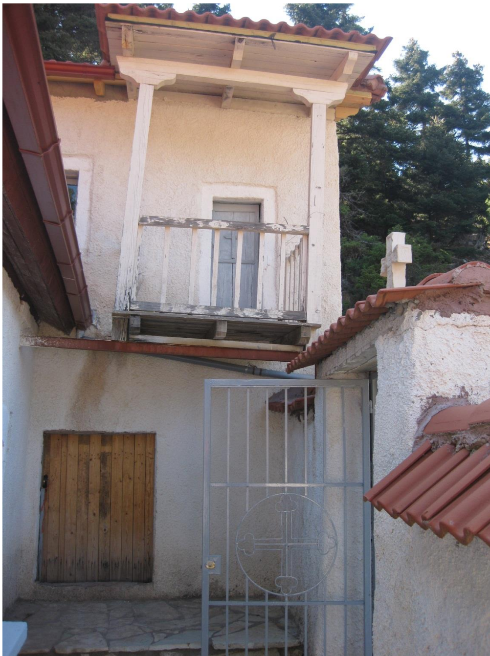
Φωτ.24: Χώρος όπου στεγάζεται η σκήτη του Παπουλάκου.
