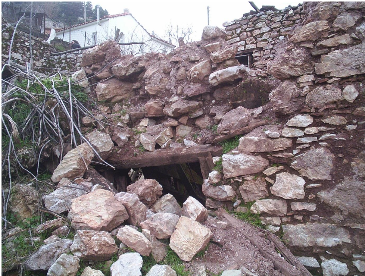
Φωτ.14: Η είσοδος στο χώρο αποθήκευσης αγαθών στο κατώι.
