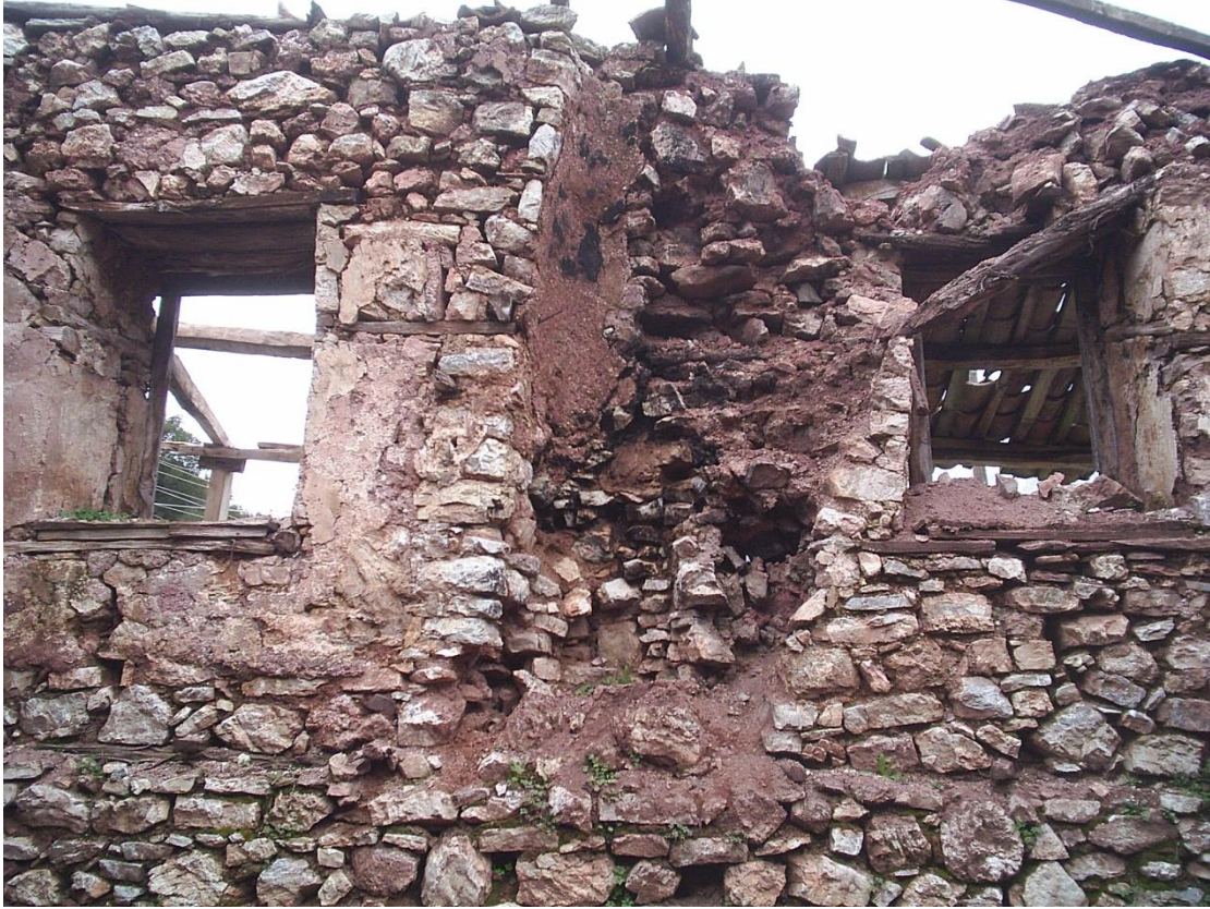
Φωτ 7: Ανοίγματα και η εστία στο κέντρο της τοιχοποιίας στο ανώι.
