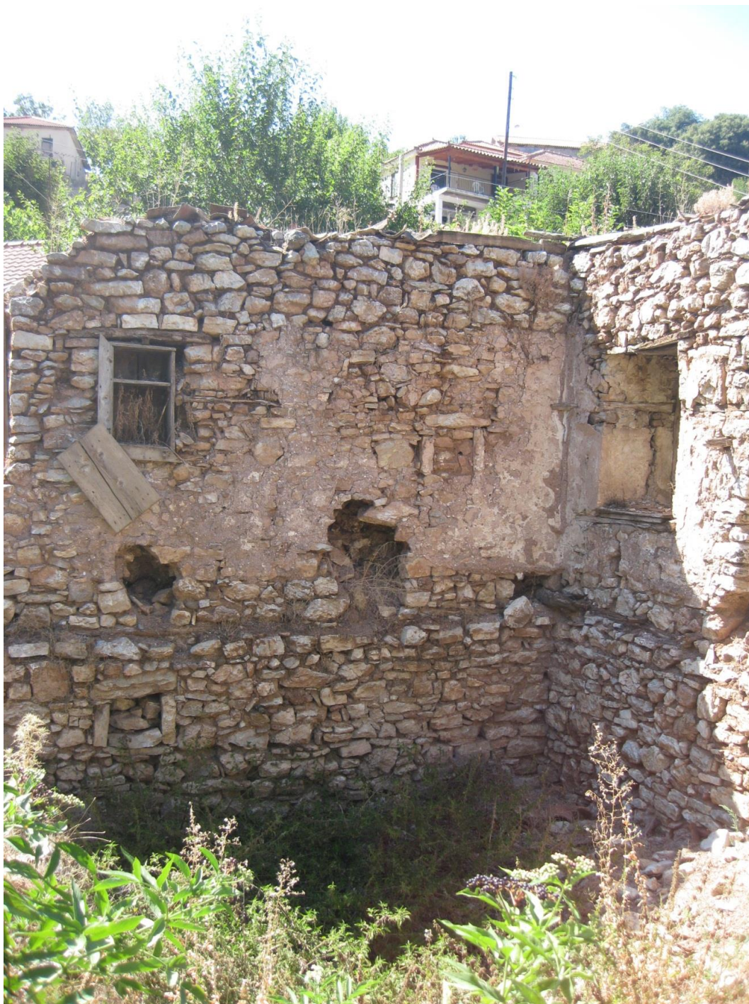
Φωτ.17: Νοτιοδυτική τοιχοποιία (ανοίγματα, ερμάριο, πέτρινα φατνώματα σε ανώι και κατώι και οι θέσεις όπου ήταν τα πάτερα του πατώματος).
