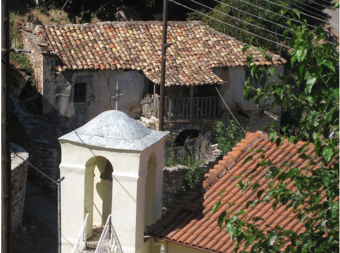
Φωτ.23: Παράδειγμα τρίριχτης στέγης οικίας που βρίσκεται στον Άρμπουνα.
