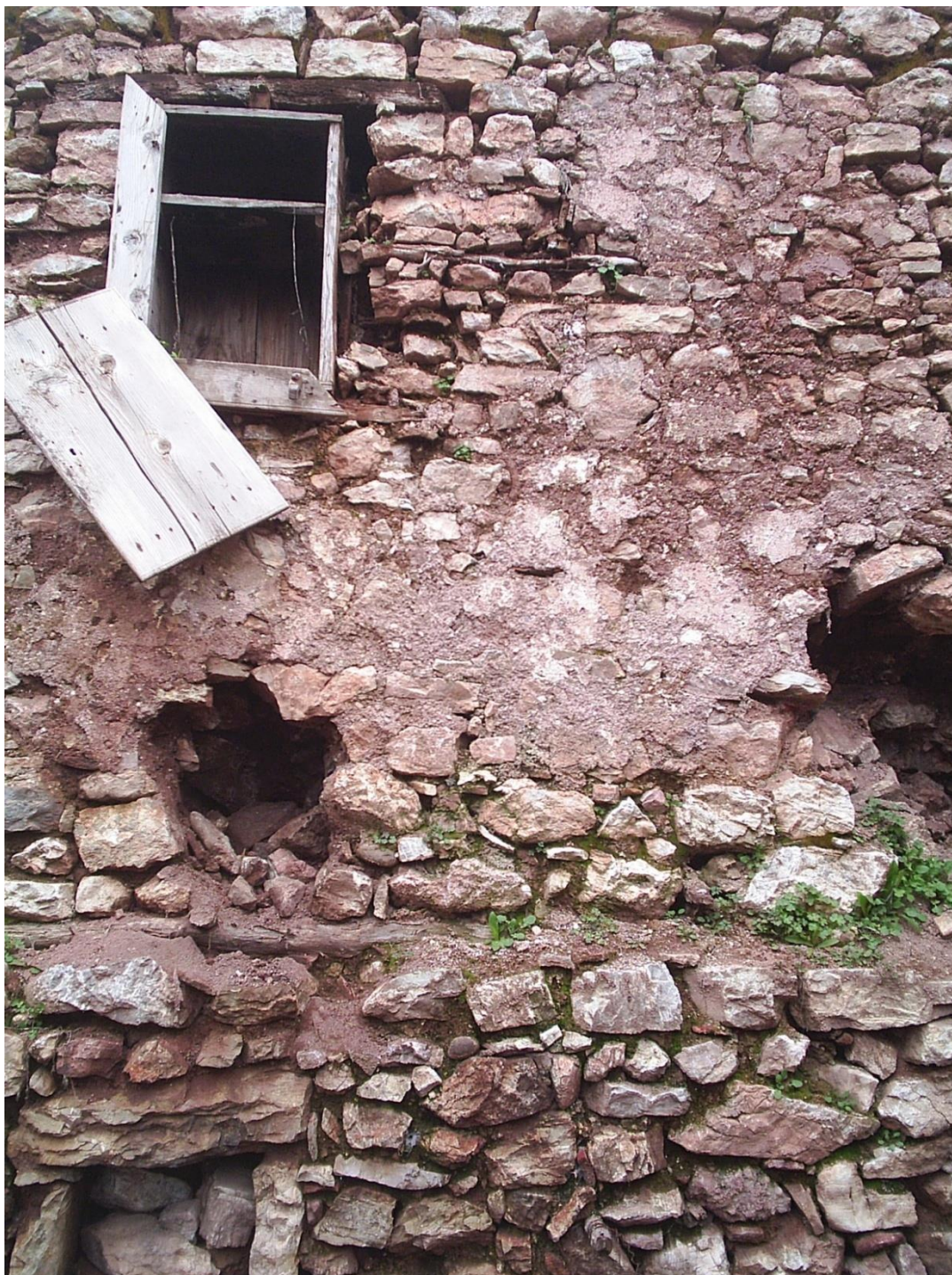
Φωτ 6: Ξύλινο ερμάριο, οι θέσεις όπου ήταν τα πάτερα του πατώματος και πέτρινο φάτνωμα στο κατώι.
