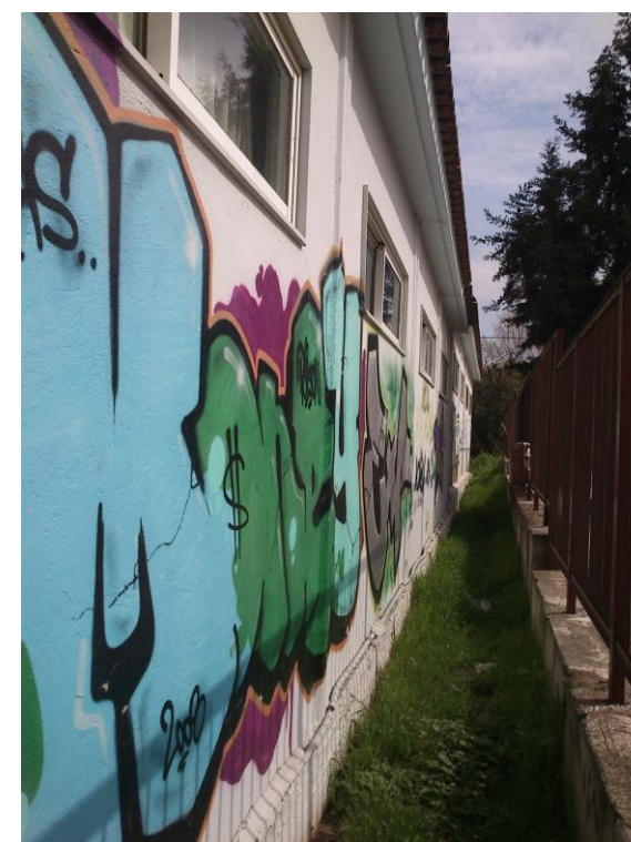
273. Νοτιοδυτική όψη κτηρίου 3
