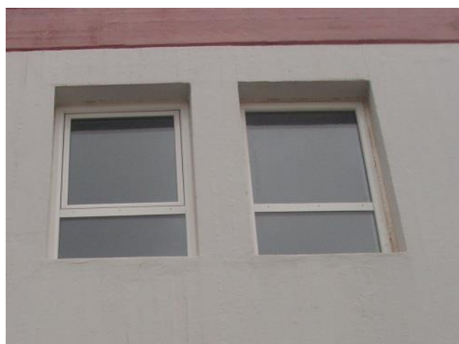
27. Εξωτερικά κουφώματα κτηρίου 1
