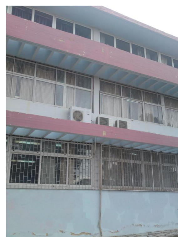
271. Νοτιοδυτική όψη κτηρίου 1
