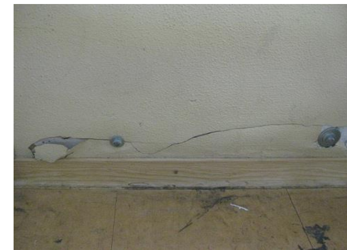
114. Αποκόλληση επιχρίσματος και στερέωση με μεταλλικές βίδες
