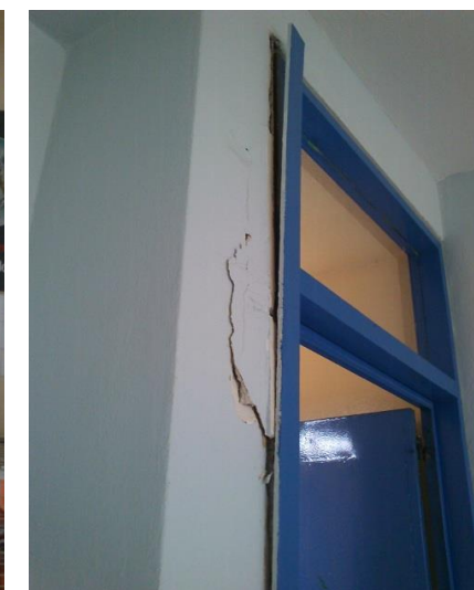
125. Αποκόλληση κουφώματος
