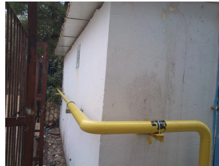
280. Βορειοανατολική όψη κτηρίου 6
