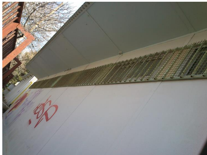
276. Βορειοανατολική όψη κτηρίου 4
