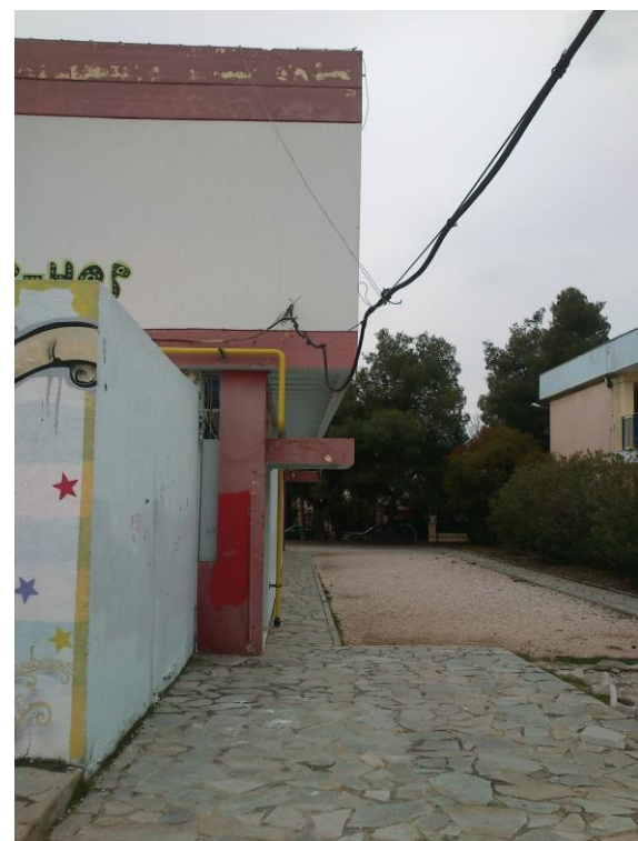
267. Νοτιοανατολική όψη κτηρίου 1
