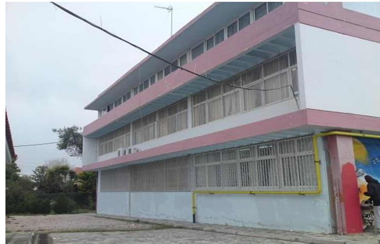
108. Νοτιοδυτική όψη κτηρίου 1
