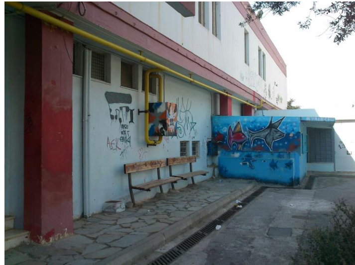
254. Νοτιοανατολική όψη κτηρίου 1
