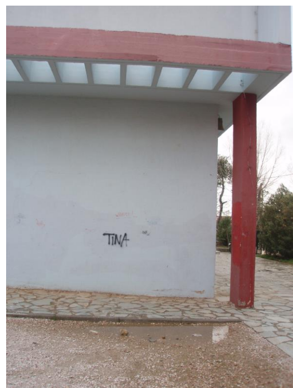
269. Βορειοανατολική όψη κτηρίου 1
