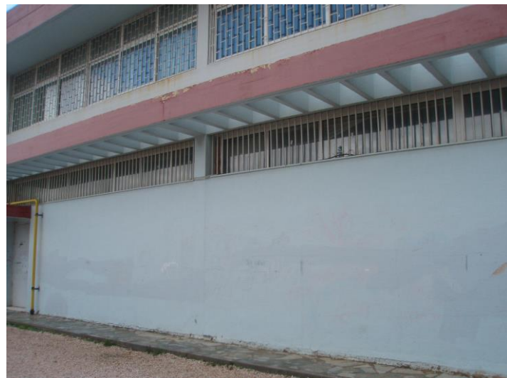
256. Βορειοανατολική όψη κτηρίου 1
