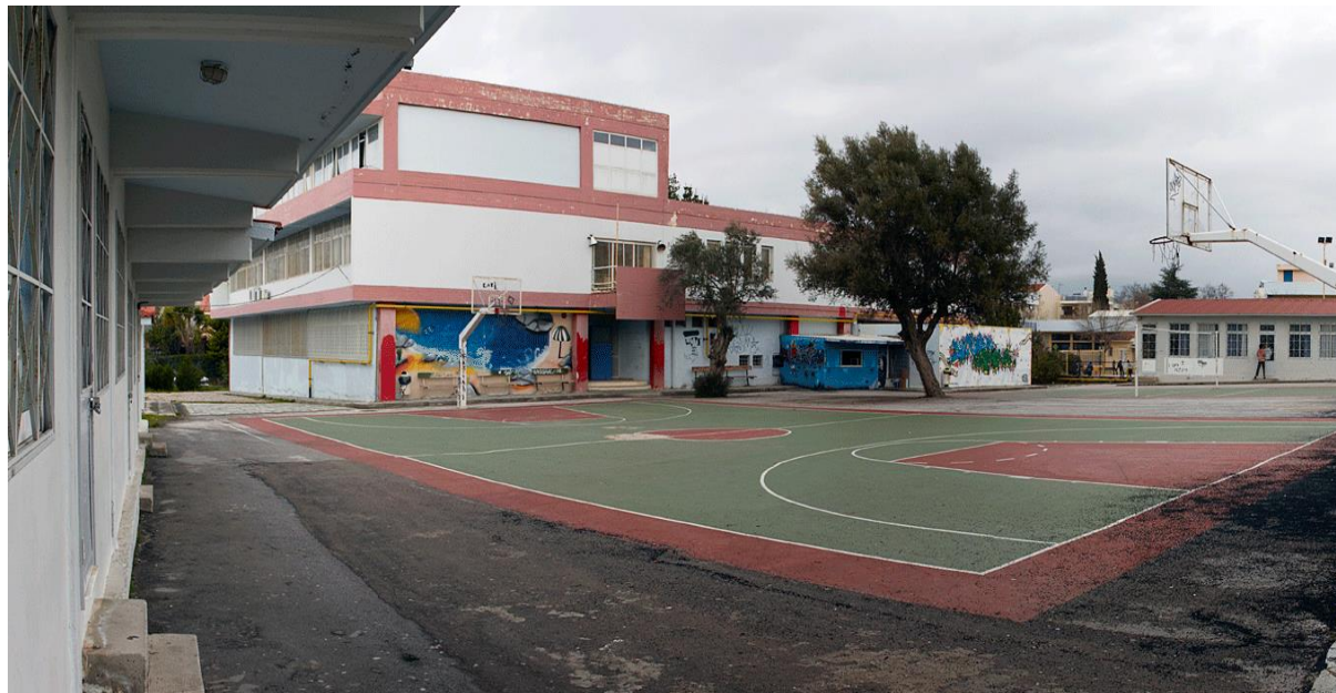
1. Νοτιοανατολική όψη κτηρίου 1
