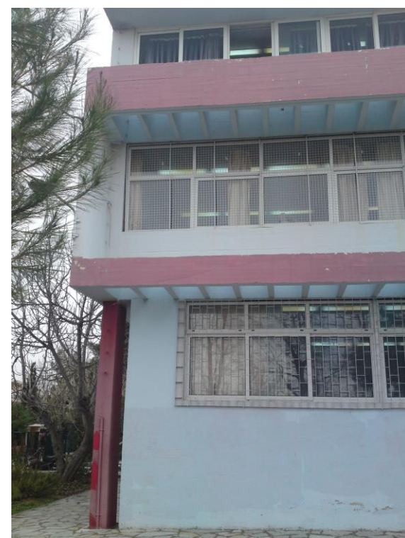
272. Νοτιοδυτική όψη κτηρίου 1
