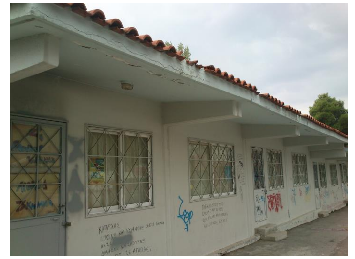
263. Βορειοανατολική όψη κτηρίου 3
