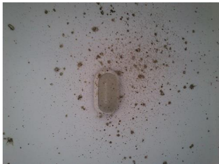
110. Μικροοργανισμοί λόγω υγρασίας κτήριο 2
