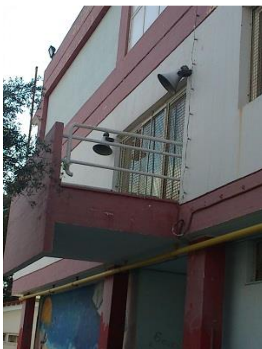
55. Λευκό μεταλλικό κιγκλίδωμα εξώστη
