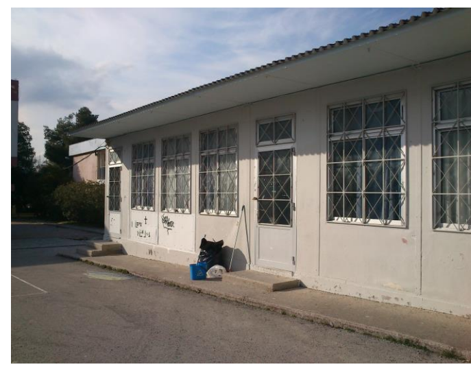
264. Νοτιοδυτική όψη κτηρίου 4
