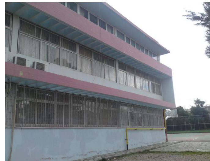
260. Νοτιοδυτική όψη κτηρίου 1
