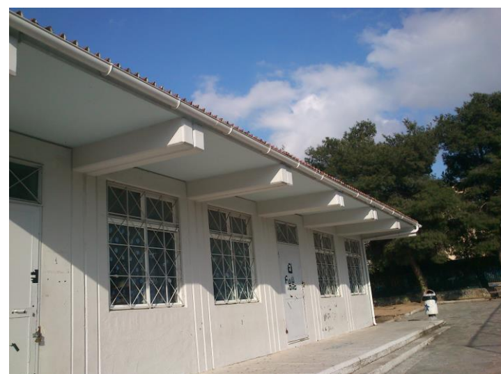
277. Νοτιοδυτική όψη κτηρίου 5
