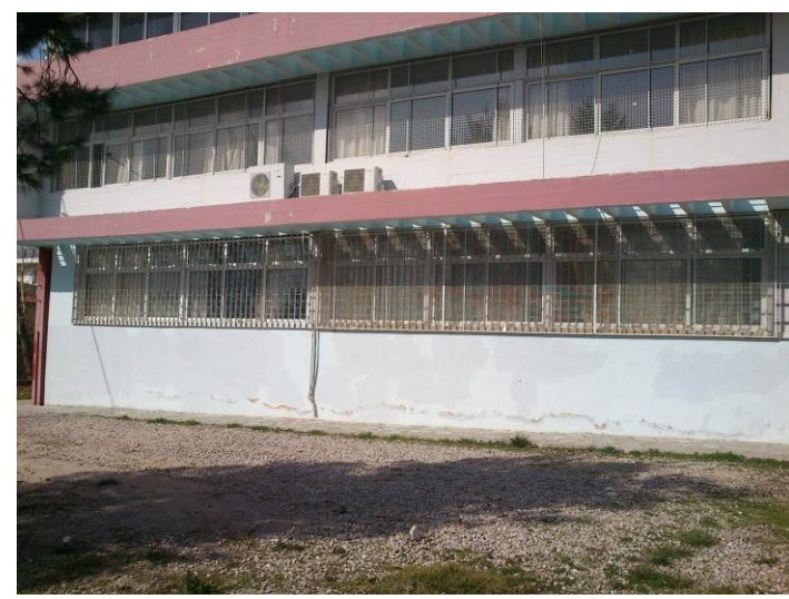
259. Νοτιοδυτική όψη κτηρίου 1
