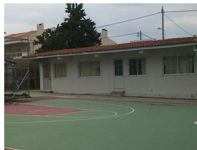
30. Κτήριο 3 βορειοανατολική όψη
