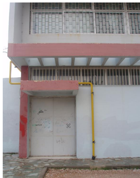
15. Βορειοανατολική όψη κτηρίου 1
