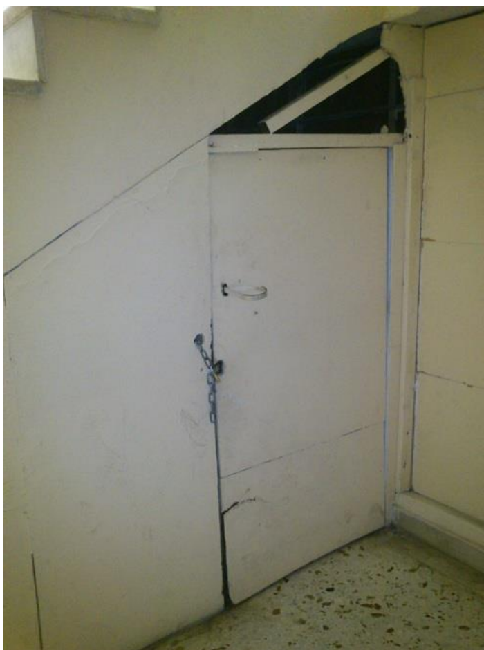
103. Τοιχοποιία και κούφωμα από γυψοσανίδα
