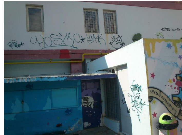
255. Νοτιοανατολική όψη κτηρίου 1
