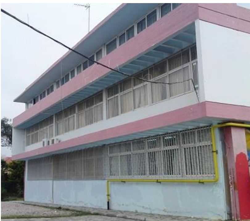
14. Νοτιοδυτική όψη κτηρίου 1
