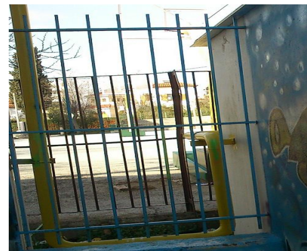
59. Μεταλλικό κιγκλίδωμα κτήριο 6
