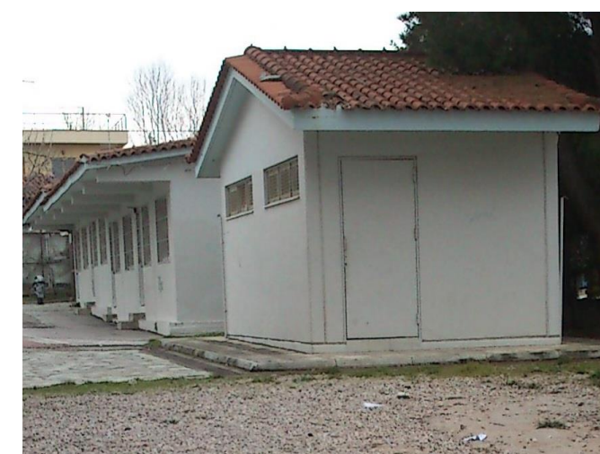
31. Κτήριο 2 νοτιοανατολική όψη
