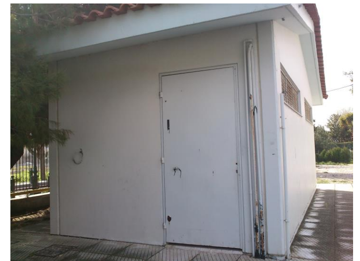
261. Νοτιοανατολική όψη κτηρίου 2
