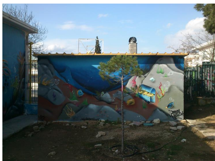
278. Βορειοανατολική όψη κτηρίου 6
