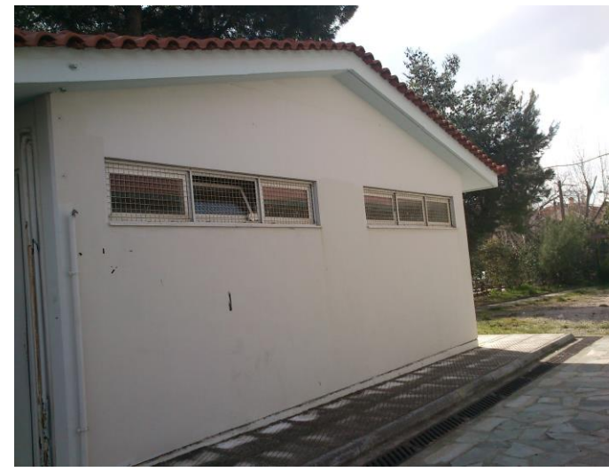
262. Βορειοανατολική όψη κτηρίου 2
