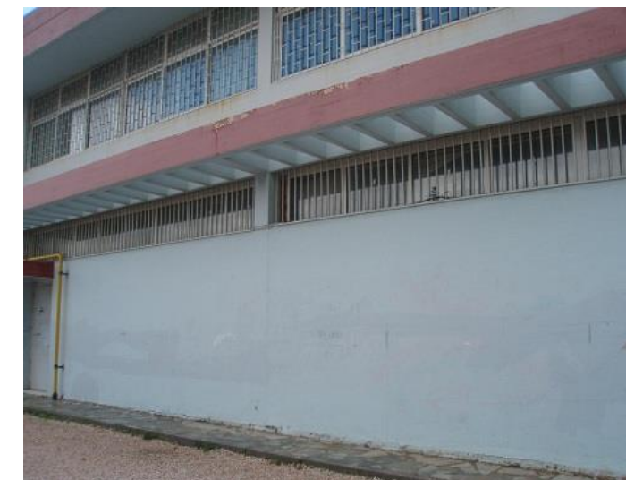
107. Βορειοανατολική όψη κτηρίου 1
