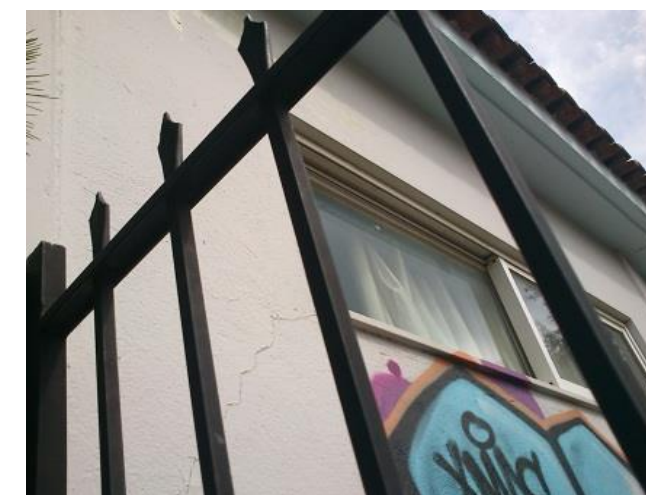
58. Μεταλλικό κιγκλίδωμα κτήριο 3
