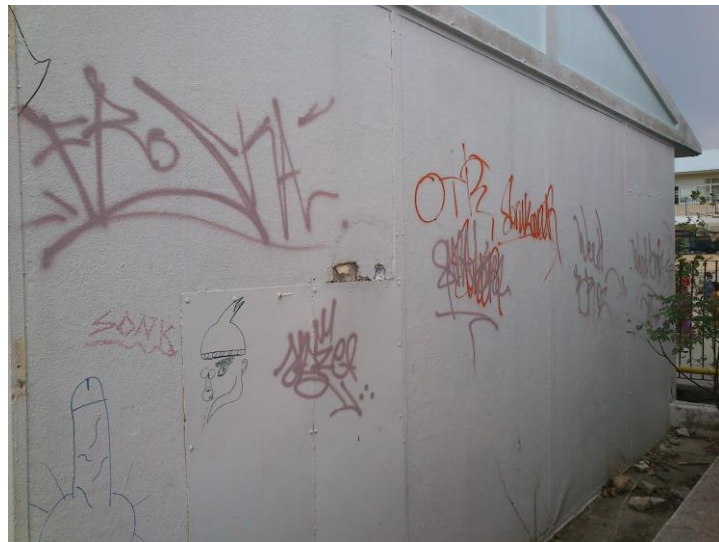
274. Νοτιοανατολική όψη κτηρίου 4
