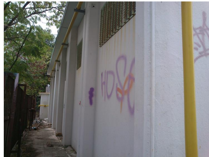
275. Βορειοανατολική όψη κτηρίου 5
