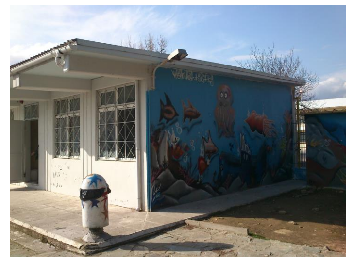
265. Νοτιοανατολική όψη κτηρίου 5
