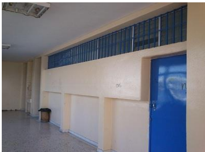
19. Διάδρομος α' ορόφου κτήριο 1
