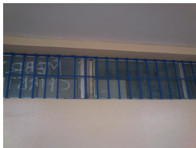
28. Εσωτερικά κουφώματα κτηρίου 1
