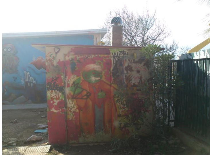
279. Νοτιοανατολική όψη κτηρίου 6
