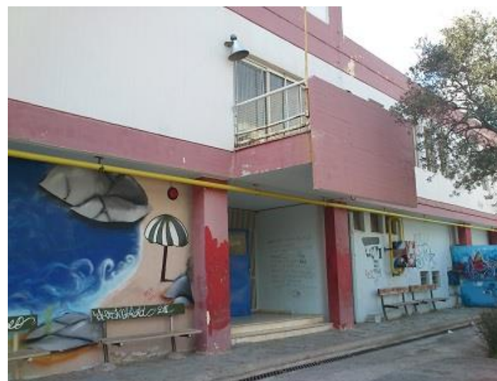
34. Νοτιοανατολική όψη κτηρίου 2
