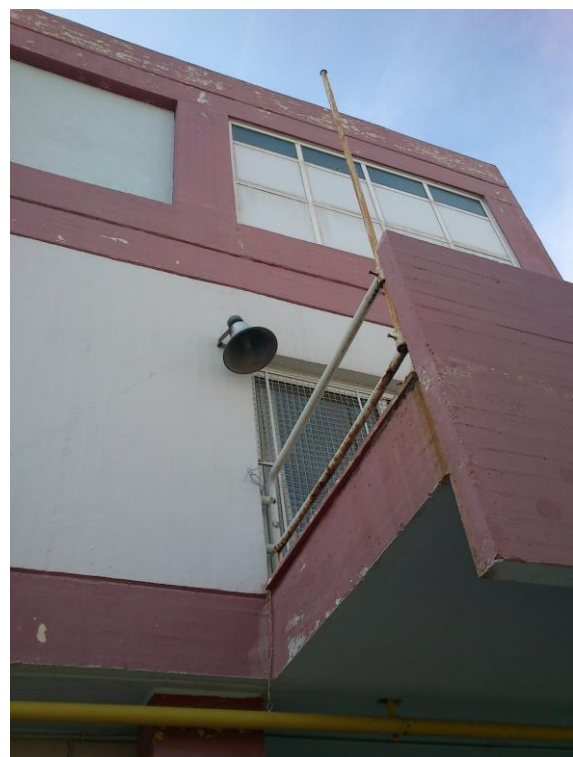
266. Νοτιοανατολική όψη κτηρίου 1
