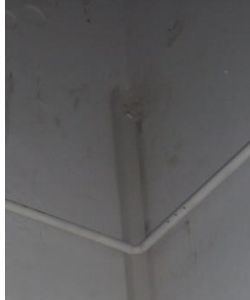
| 50.Τμήμα εξωτερικής καλωδίωσης
