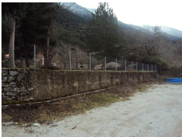
| εικ.58. Τμήμα του κεντρικού τοιχίου από οπλισμένο σκυρόδεμα και πρόχειρη περίφραξη
