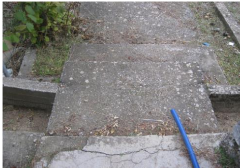
| 25.Βαθμιδωτός διάδρομος στο τμήμα που διαπερνά το αρδευτικό δίκτυο
