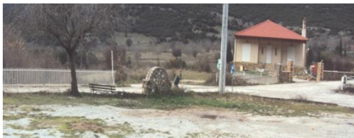
| 54. Έλλειψη του συρματοπλέγματος περιφράξης του οικοπέδου
