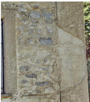
| 48. Άποψη βορειοδυτικού πλαισιωμένου ανοίγματος και τα περιμετρικά σενάζ
