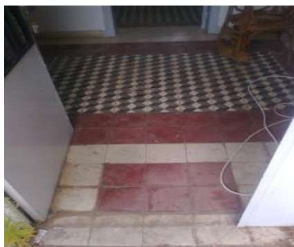
| 24. Πλακόστρωση ισογείου με γεωμετρικό ανάπτυγμα με λειασμένη επιφάνεια (εσωτερικά)
