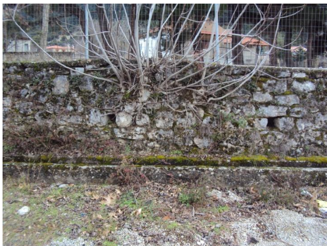
| εικ.56. Κεντρικό τοίχιο με τις σπές αποστράγγισης
