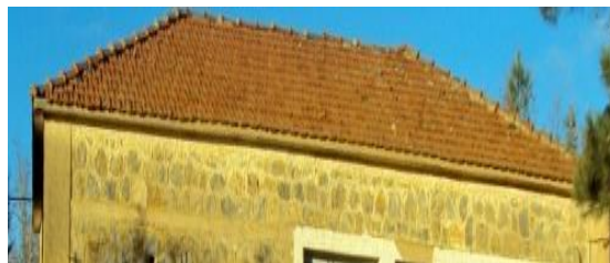
| 19.Νοτιοανατολική άποψη της τετράρριχτης στέγης
