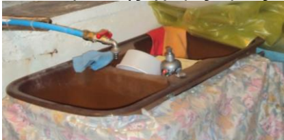
| 52. Πρόχειρο δίκτυο ύδρευσης στο εσωτερικό του υπογείου, και τοποθέτηση νεροχύτη
