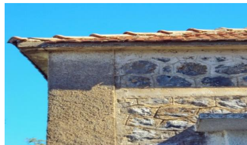
| 18.Τμήμα του περιμετρικού γείσου
