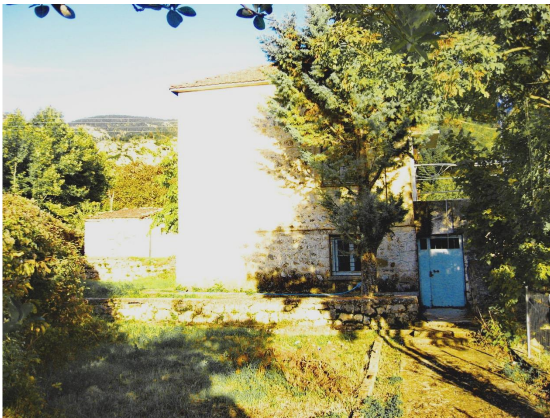
| ΝΟΤΙΟΔΥΤΙΚΗ ΑΠΟΨΗ ΤΟΥ ΚΤΗΡΙΟΥ |
