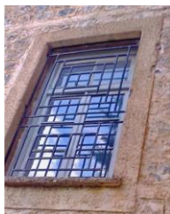
| 41.Νοτιοδυτικό παράθυρο ισογείου
