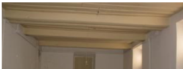
Εικόνα 45 Ξύλινα κιβώτια που περιβάλλουν τις δοκούς
