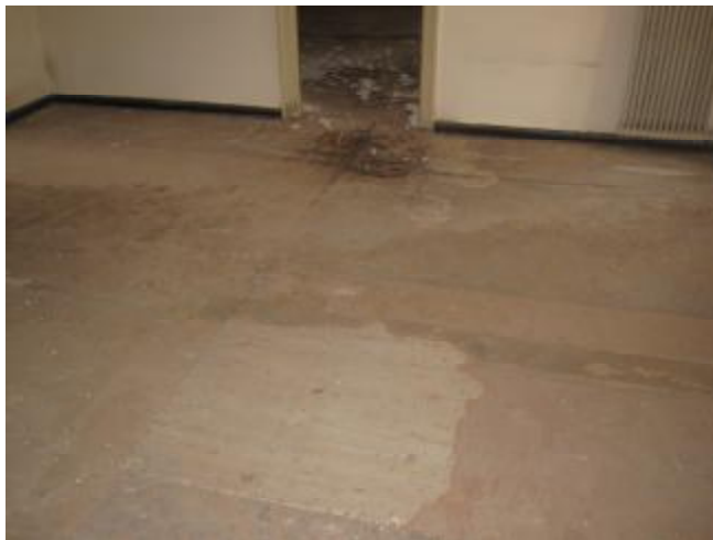
Εικόνα 53 Επικάλυψη ξύνινου δαπέδου με υλικό τύπου linoleum
