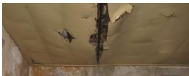
Εικόνα 46 Ψευδοροφή από hard board
