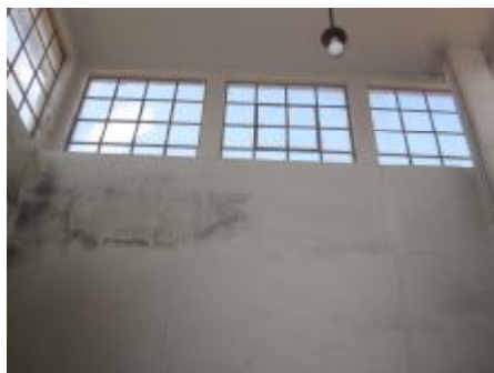
Εικόνα 58 Σίδηροι φεγγίτες
