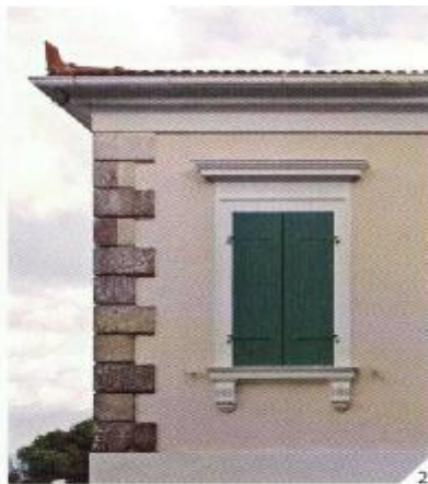
ΕΙΚ.96.α: Χαρακτηριστικές γωνίες κατοικιών που έχει χρησιμοποιηθεί λαξευμένος πορόλιθος.
