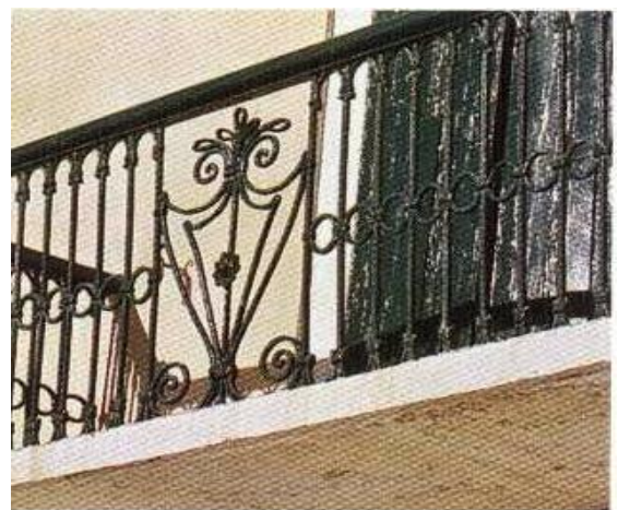
ΕΙΚ.72: Λεπτομέρεια σφυρίλατης διακόσμησης κιγκλιδώματος.
