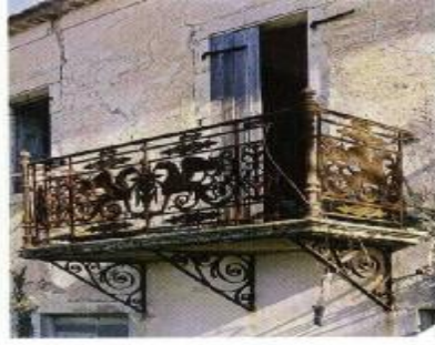
ΕΙΚ.73: Φουρούσια και χυτοσίδηρα κιγκλιδώματα.
