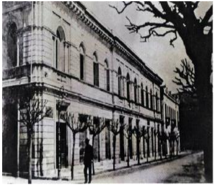
ΕΙΚ.94: Κατοικία πριν το σεισμό του 1953. Ίσως το μοναδικό κτίριο με τόσο επιμελημένη τοιχοποιία από λαξευμένη πέτρα.
