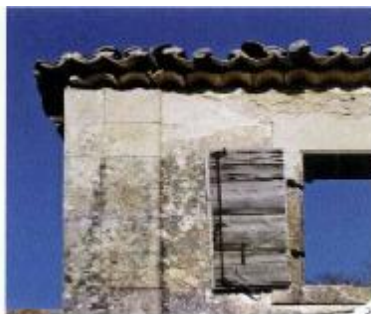
ΕΙΚ.53: Γείσα από πέτρα και κεραμίδια.
