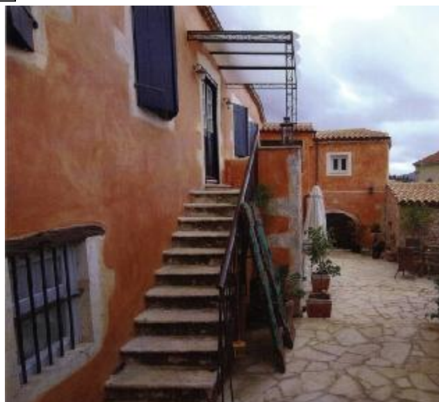
ΕΙΚ.68: Πέτρινες σκάλες με σκαλοπάτια «μπιζουτάδα».
