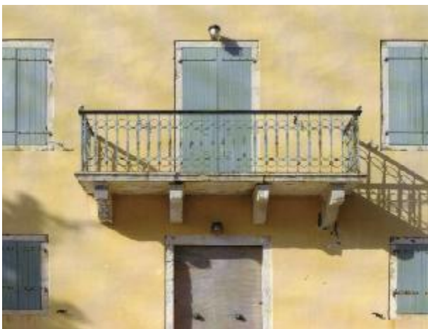
ΕΙΚ.71: Χαρακτηριστικό πέτρινο μπαλκόνι με σφυρίλατοκιγκλιδώμα και πέτρινα φουρούσια, 1870.
