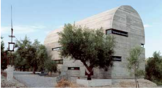
Εικόνα 75: Καμαροσκέπαστη κατασκευή από οπλισμένο σκυρόδεμα
