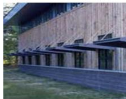
Εικόνα 188: Ράφια φωτισμού
