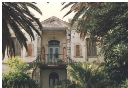
Εικόνα 226: Το κτίριο όταν ήταν εγκαταλελειμμένο
