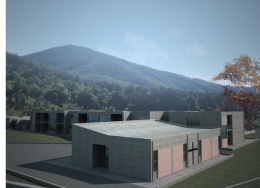
Εικόνα 76: Κεκλιμένη στέγη από οπλισμένο σκυρόδεμα
