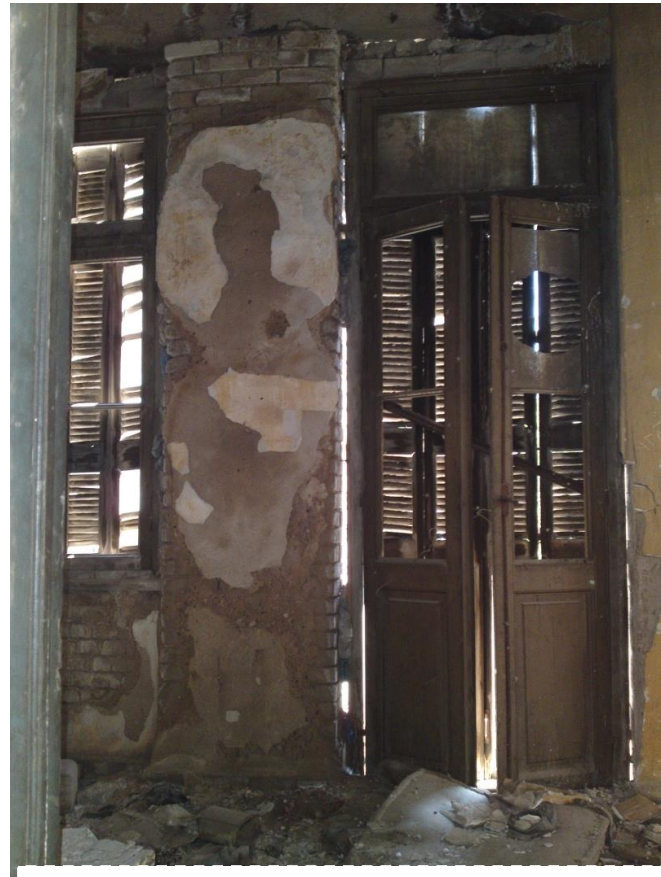
Ξύλινες πόρτες και παράθυρα με κατεστραμμένα πατζούρια και σπασμένους υαλοπίνακες.
