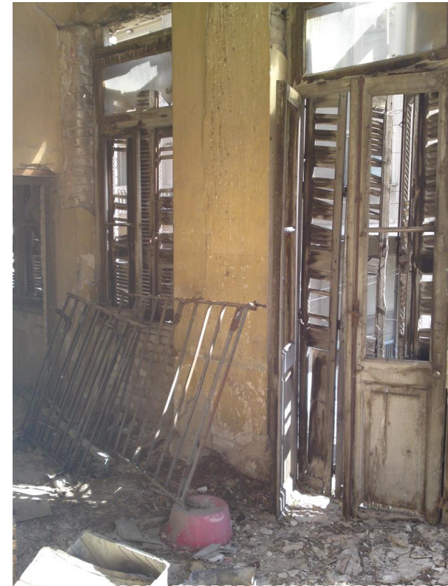
Ξύλινες πόρτες και παράθυρα με κατεστραμμένα πατζούρια και σπασμένους υαλοπίνακες.
