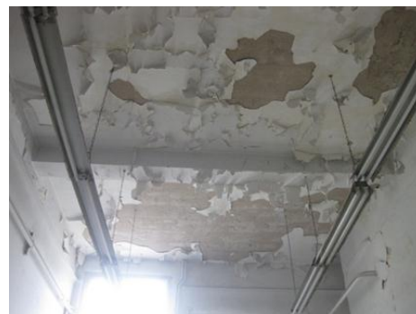
Εικόνα 71 κατάρρευση οροφοκονιάματος
