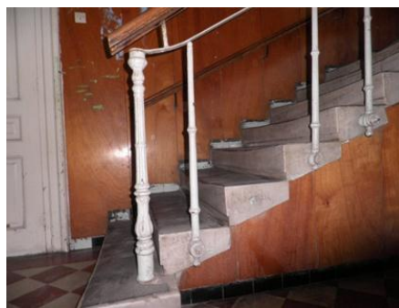
Εικόνα 75 οξειδωση κιγκλιδώματος
