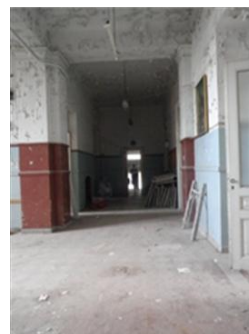
Εικόνα 20 διάδρομος α' ορόφου
