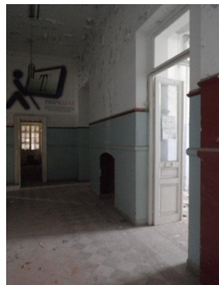
Εικόνα 30 διάδρομος α' ορόφου
