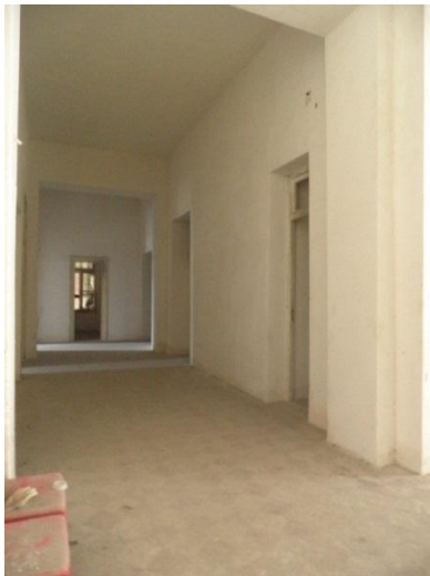
Εικόνα 31 διάδρομος β' ορόφου
