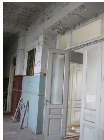
Εικόνα 84 κούφωμα που πρόκειται να αφαιρεθεί και να συμπληρωθεί στη νέα αίθουσα εκδηλώσεων
