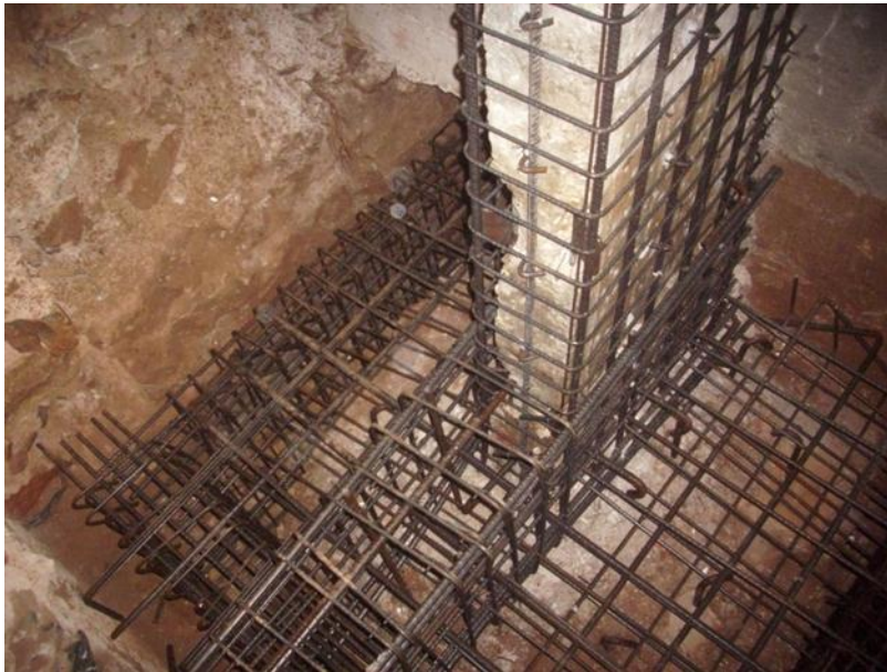
Εικόνα 85 ενίσχυση θεμελίωσης
