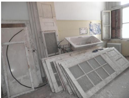
Εικόνα 83 κουφώματα που έχουν αφαιρεθεί
