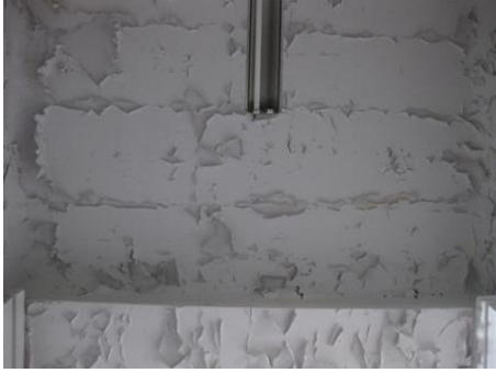
Εικόνα 72 αποφλοίωση χρώματος
