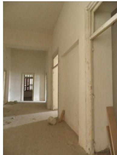
Εικόνα 32 διάδρομος β' ορόφου
