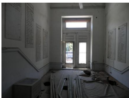
Εικόνα 23 χώρος 113- κεντρική είσοδος
