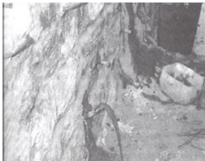
Εικόνα 88 εισαγωγή υδραυλικού ενέματος
