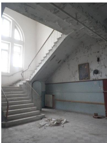
Εικόνα 10 κεντρικό κλιμακοστάσιο α' ορόφου
