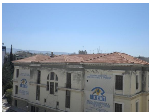
Εικόνα 62 άποψη στέγης από την βόρεια πλευρά
