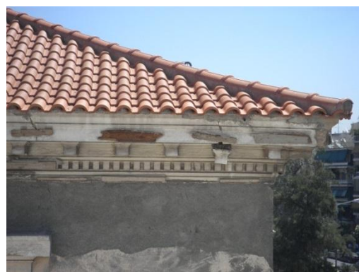
Εικόνα 63 νέο σενάζ κάτω από το επίπεδο της στέγης
