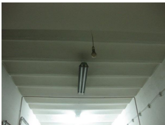
Εικόνα 57 σύστημα carpen με τοξωτή διάταξη οπτόπλινθων
