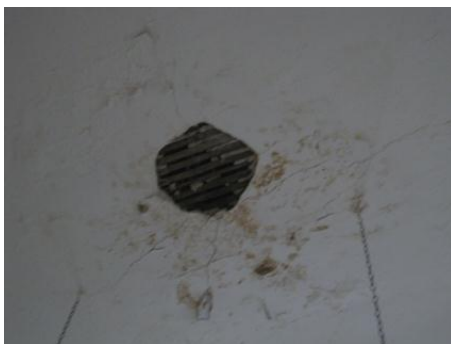
Εικόνα 70 εμφάνιση ψευδοροφής με μπαγδατόπηχες
