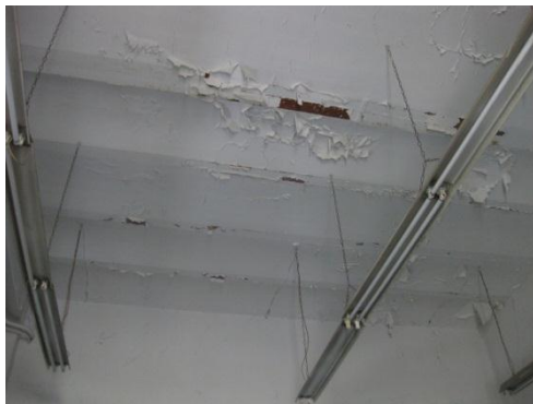
Εικόνα 51 οροφή με σύστημα carpen
