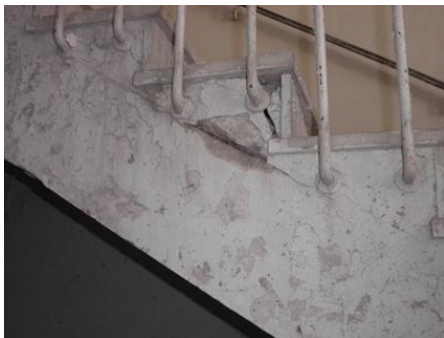
Εικόνα 74 κατάρρευση επιχρίσματος
