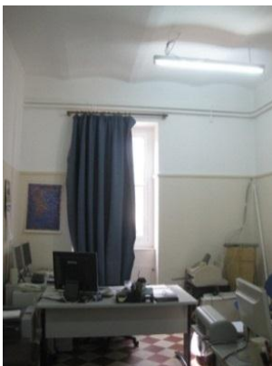
Εικόνα 15 δυτικός τοίχος χώρου 003α
