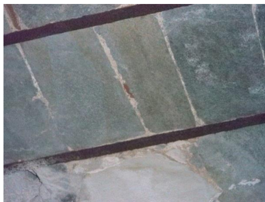
Εικόνα 58 σύστημα carpen με πλήρωση από μαλτεζόπλακες
