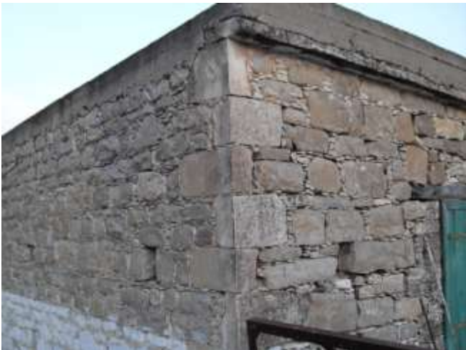
Πίσω πλευρά (Βόρεια)
