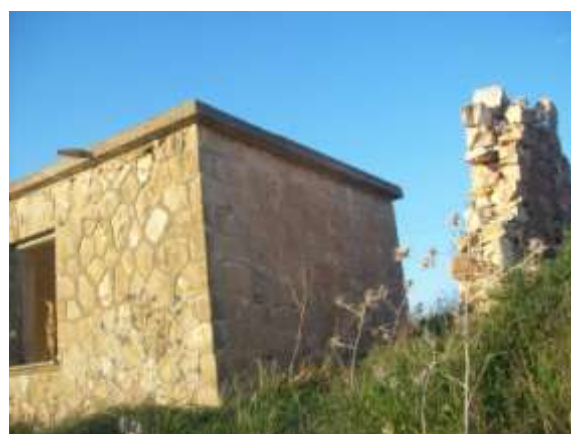
Πλάγια πλευρά (Ανατολικά)
