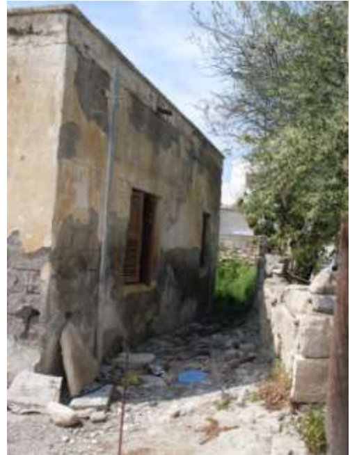
Πλάγια (βόρεια πλευρά)
