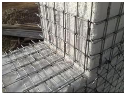
Εικόνες 10: φέρων οργανισμός από οπλισμένο σκυρόδεμα
