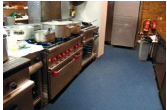
Εικόνα 12: βιομηχανικό δάπεδο σε επαγγελματική κουζίνα
