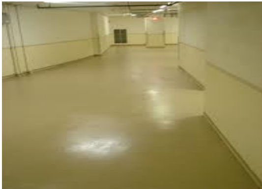
Εικόνα 11: βιομηχανικό δάπεδο σε νοσοκομείο
