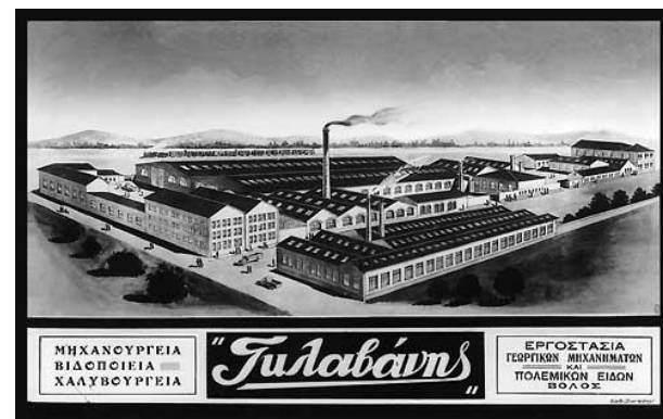
εργοστάσιο-μηχανουργείο “Κλαβάνη” Βόλος 1896.
