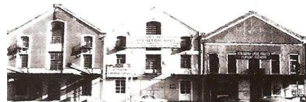
τριλογία των βιομηχανικών κτηρίων-σταφιδαποθηκών Καραμανόλη-Μπάρου
