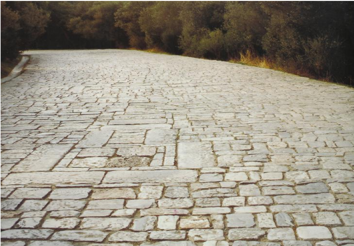
Εικόνα 57. Λεπτομέρεια της πλακόστρωσης.
