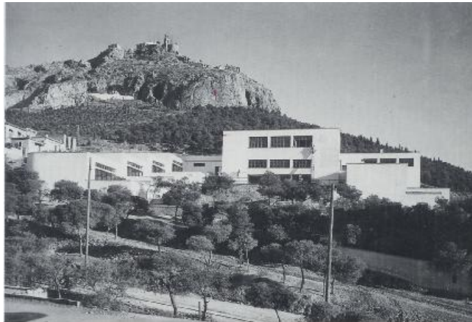
Εικόνα 5. Δημοτικό σχολείο Λυκαβυτού, 1932.
