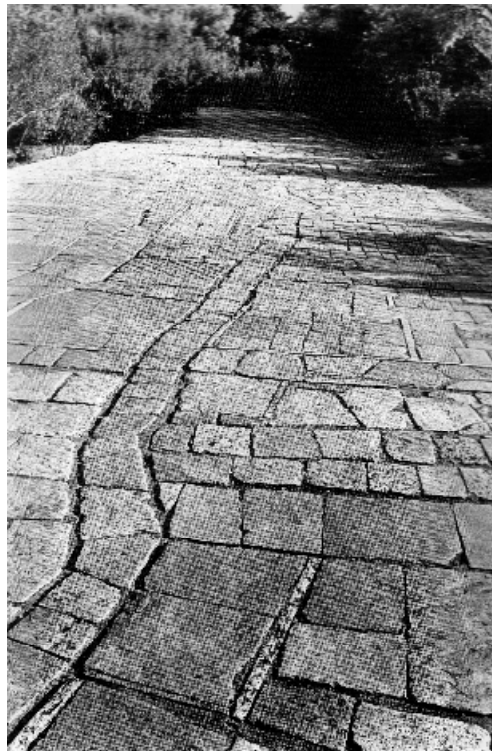
Εικόνα 46. Λεπτομέρεια της πλακόστρωσης.
