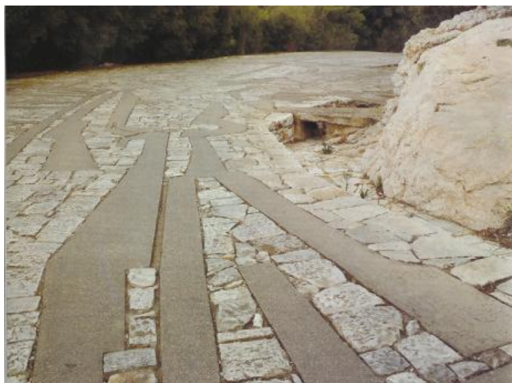
Εικόνα 58. Λεπτομέρεια της πλακόστρωσης.
