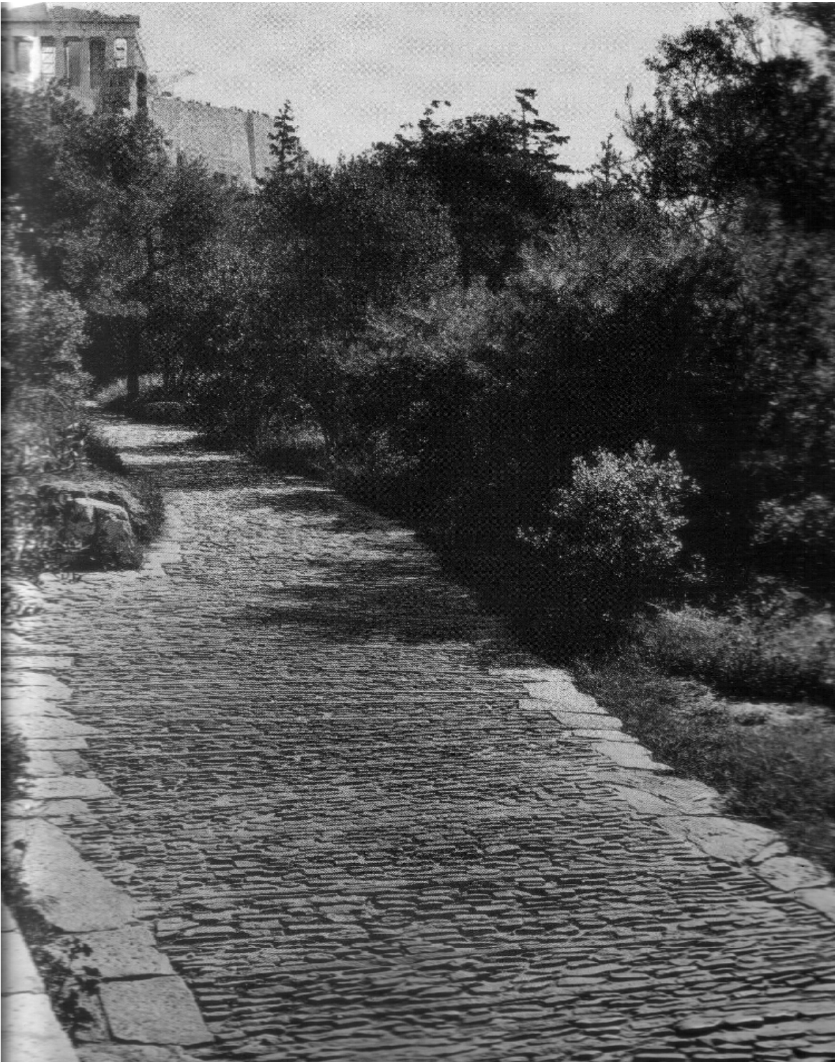
Εικόνα 54. Λεπτομέρεια της πλακόστρωσης.
