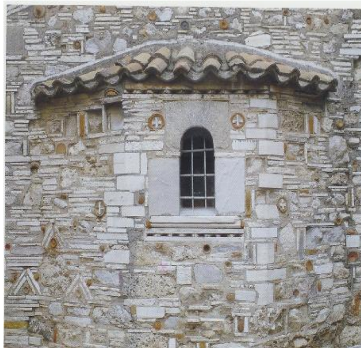
Εικόνα 71. Λεπτομέρεια του εξωτερικού τοίχου.
