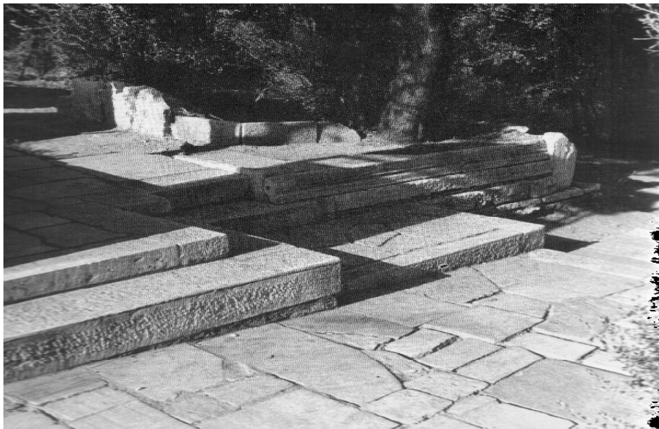
Εικόνα 52. Λεπτομέρεια της πλακόστρωσης.
