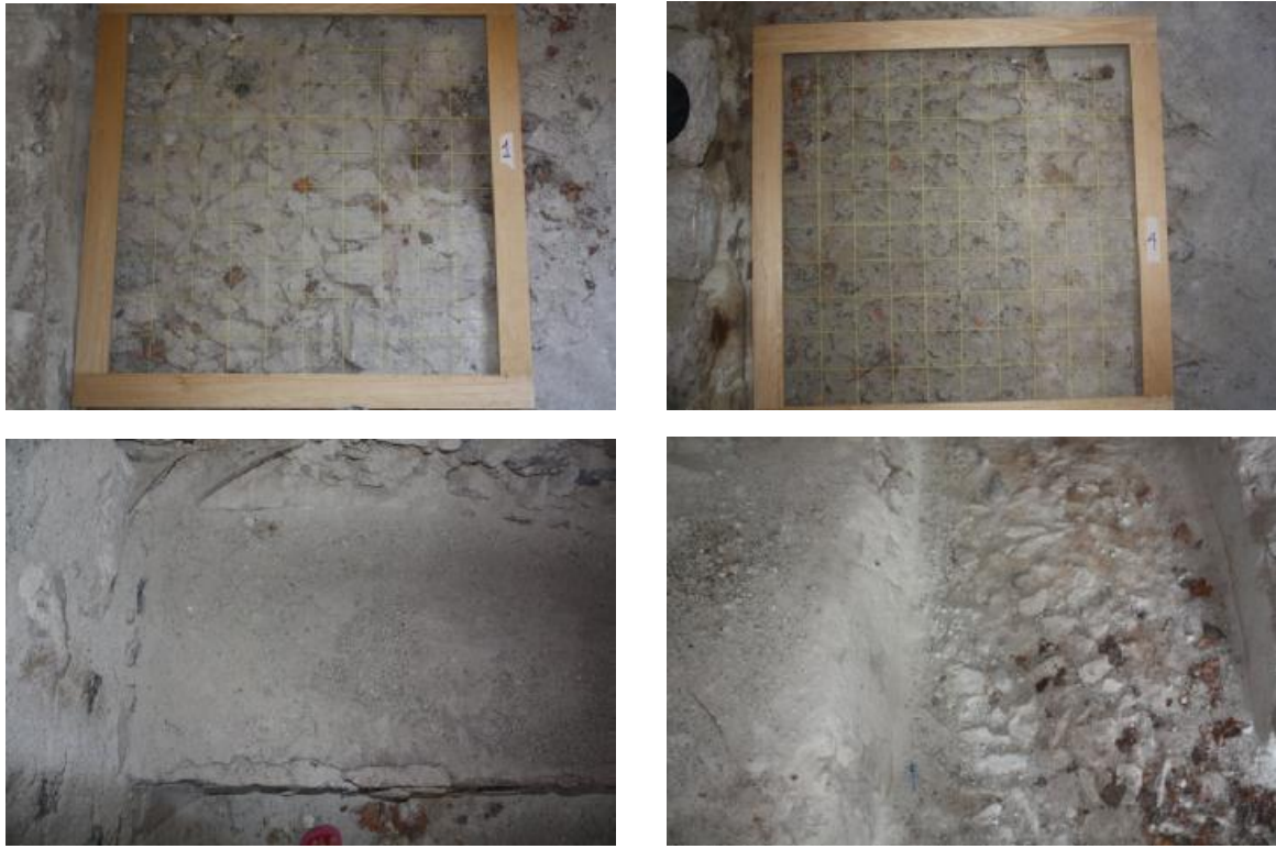
Εικόνα 26-29. Μέθοδος αποτύπωσης παθολογίας.
