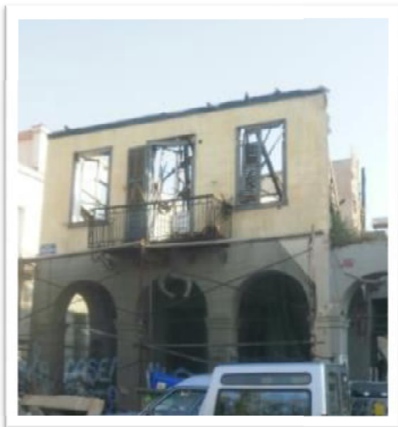
Εικόνα 2. Όψη του υπό μελέτη κτιρίου επί της οδού Γερμανού
