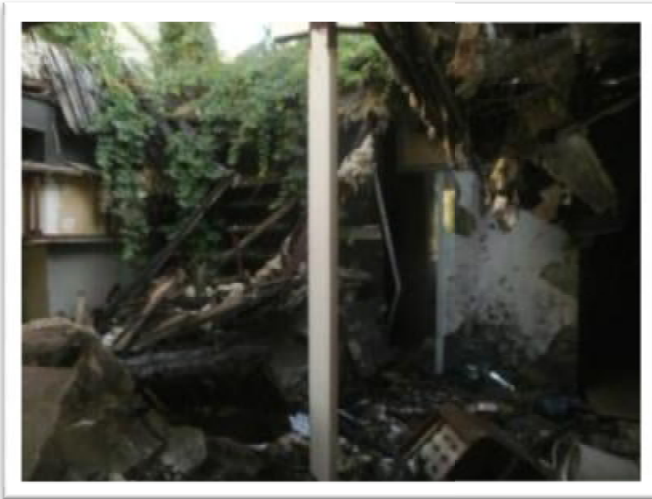
Εικόνα 6. Το ισόγειο του υπό μελέτη κτιρίου
