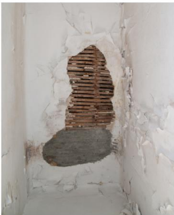
φωτ.165. Οροφή w.c. ορόφου
