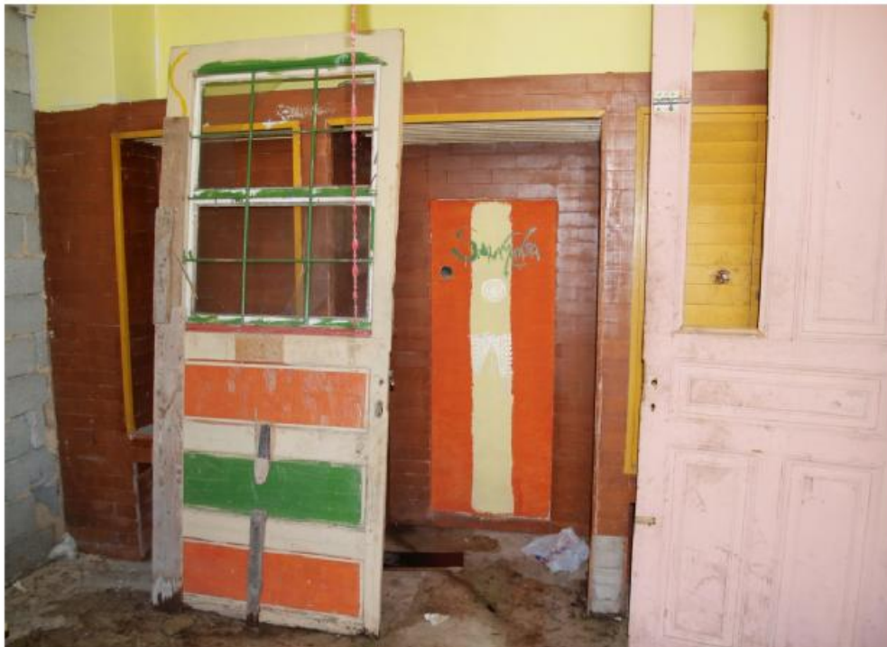
φωτ.59. Φατνώματα στον νότιο τοίχο της κουζίνας
