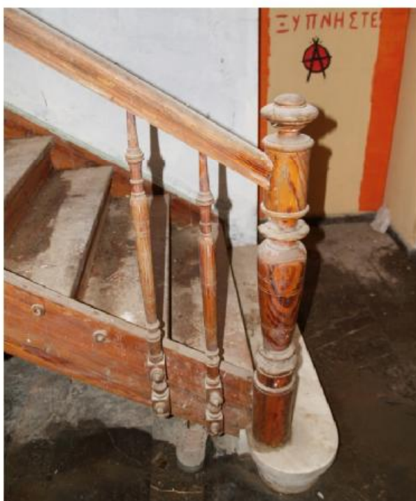
φωτ.43. Ξύλινη σκάλα
