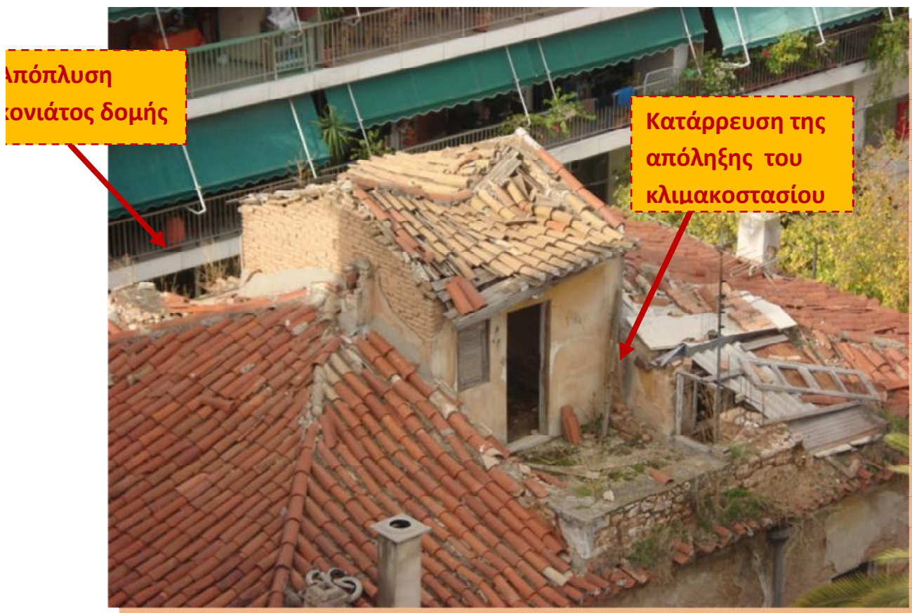
εικόνα 12: Νοτιοανατολική άποψη της στέγης.
