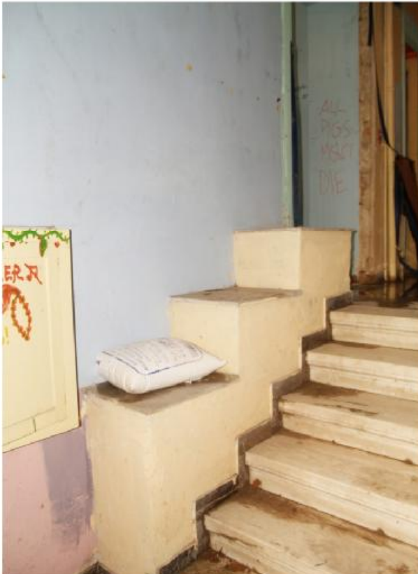
φωτ.39. Περβάζι δίπλα στη σκάλα
