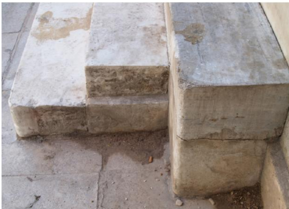
φωτ.33. Μαρμάρινη σκάλα στην είσοδο του κτιρίου
