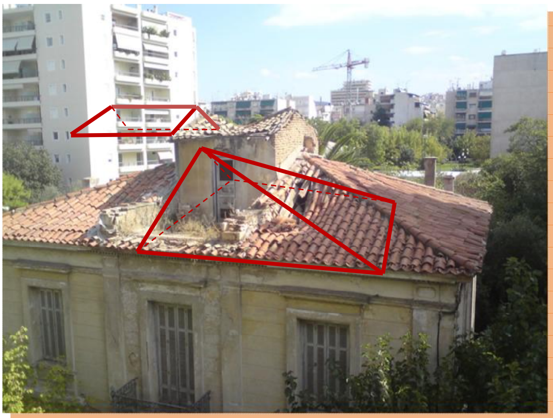
εικόνα 13: Νοτιοδυτική άποψη στέγης.
