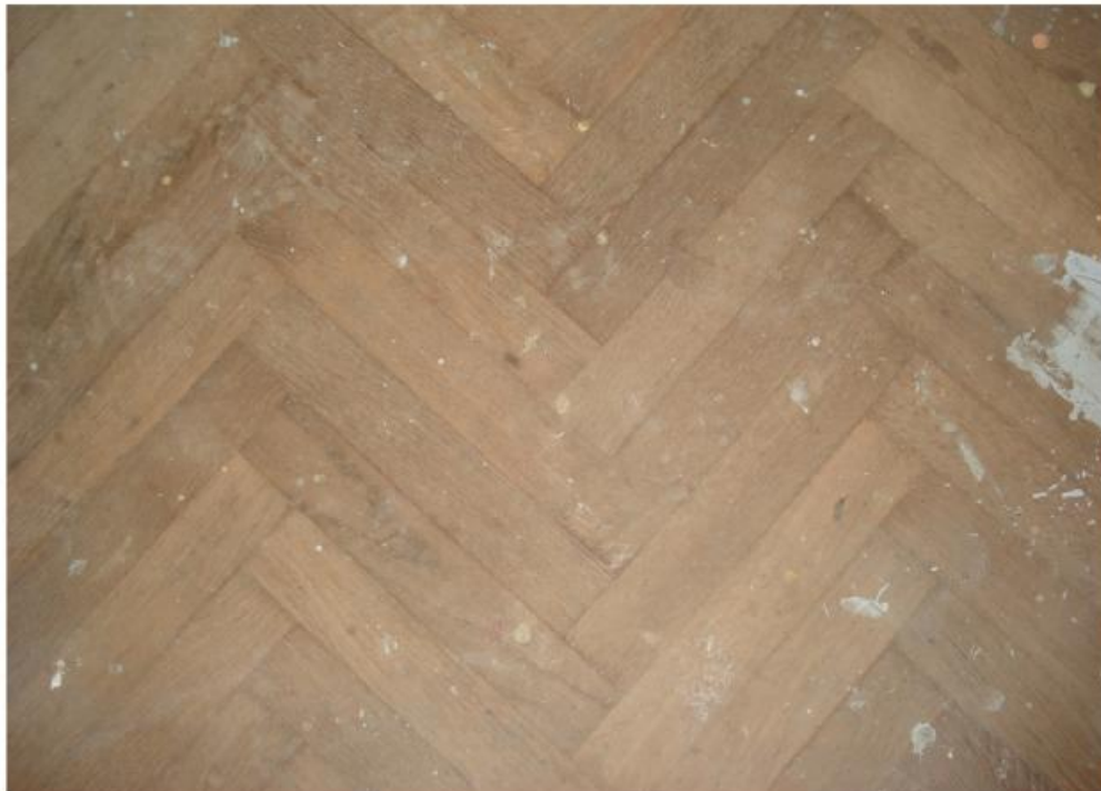
φωτ.82. Δάπεδο χώρου 1.4.
