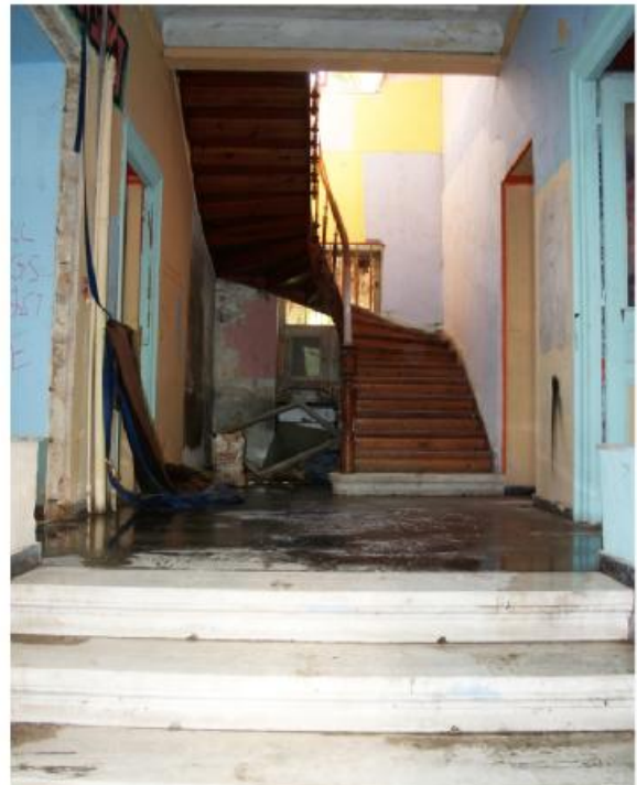
φωτ.37. Άποψη του χολ του ισόγειου
