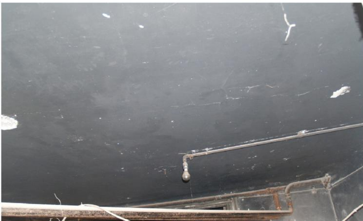
φωτ.203. Οροφή υπογείου
