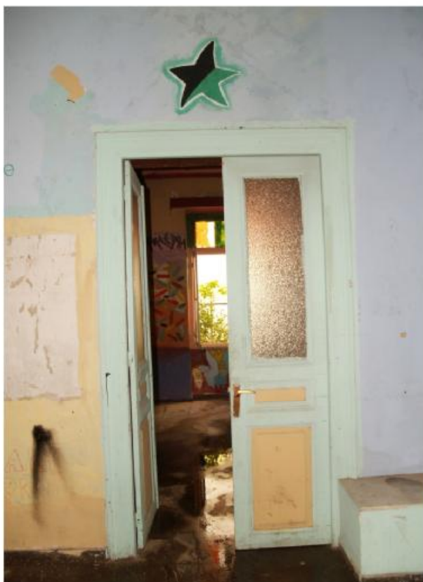
φωτ.41. Δίφυλλη πόρτα στο ισόγειο
