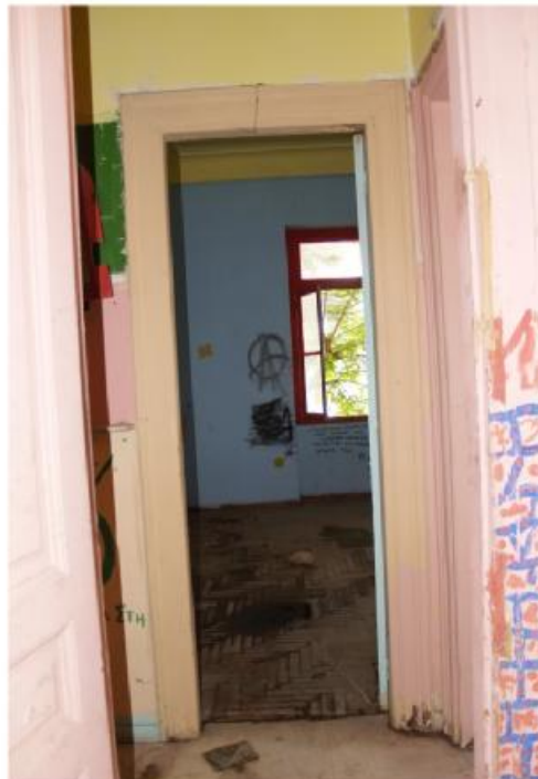
φωτ.62. Πόρτα δωματίου .....
