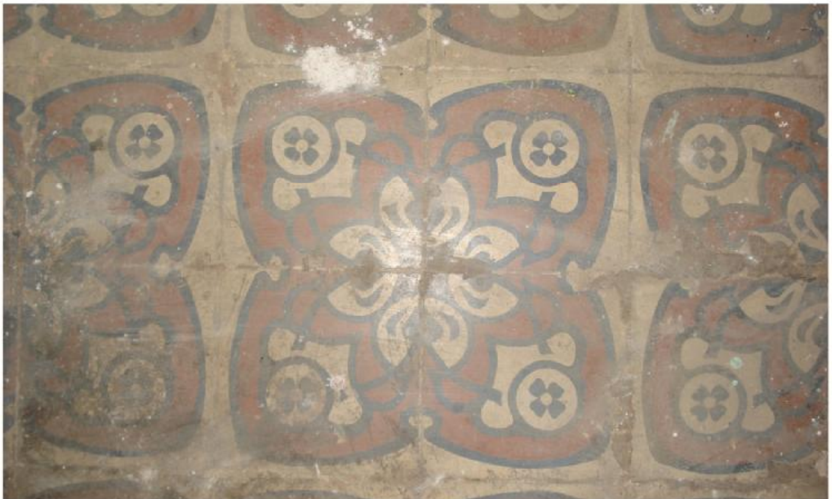
φωτ.143. Δάπεδο χώρου 2.9.
