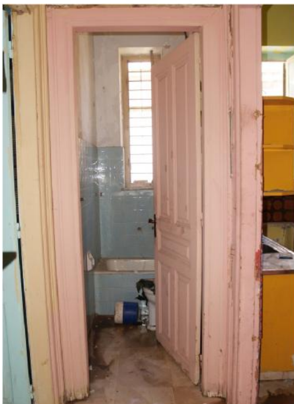
φωτ.54. W.C. ισογείου
