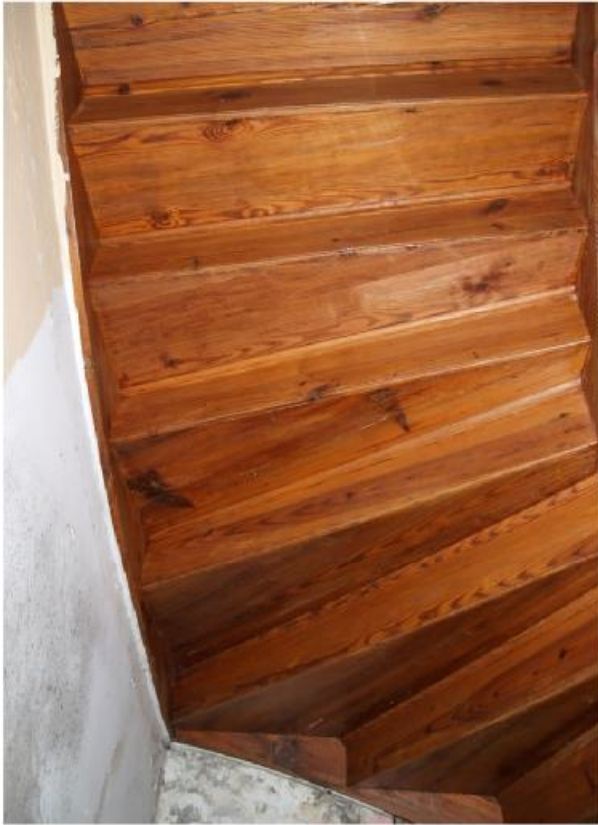
φωτ.45. Άποψη ξύλινης σκάλας από την κάτω πλευρά
