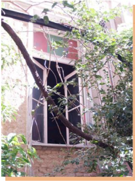
εικόνα 3: Άποψη παραθύρου A.1.3 που παρουσιάζει απόπλυση κονιάματος δομής.
