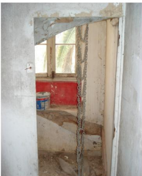
φωτ.175. Άνοιγμα Α.2.12.
