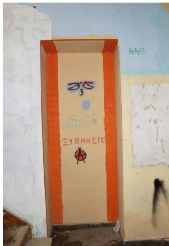
φωτ.42. Κλειστό άνοιγμα στο ισόγειο
