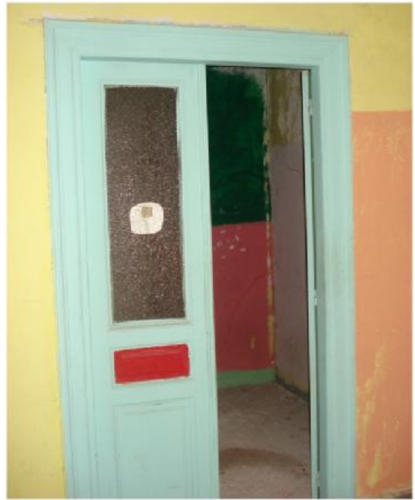
φωτ.149. Άνοιγμα Α.2.18.
