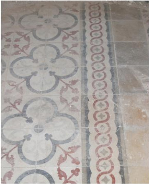
φωτ.161. Δάπεδο χώρου 2.5.
