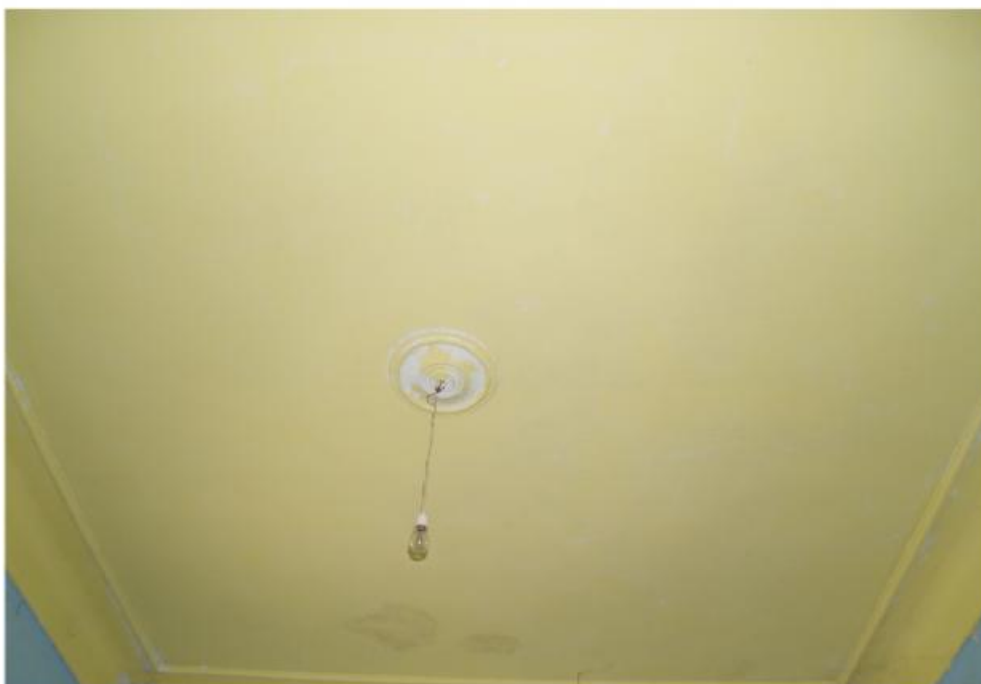
φωτ.52. Οροφή δωματίου .....
