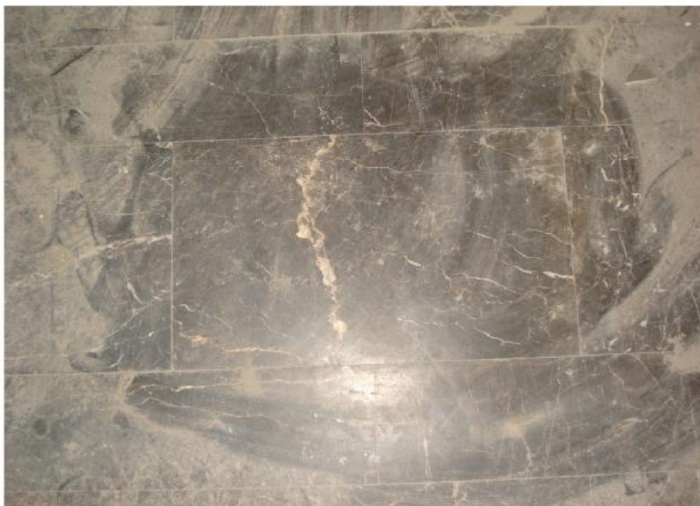
φωτ.84. Δάπεδο χώρου 1.6.
