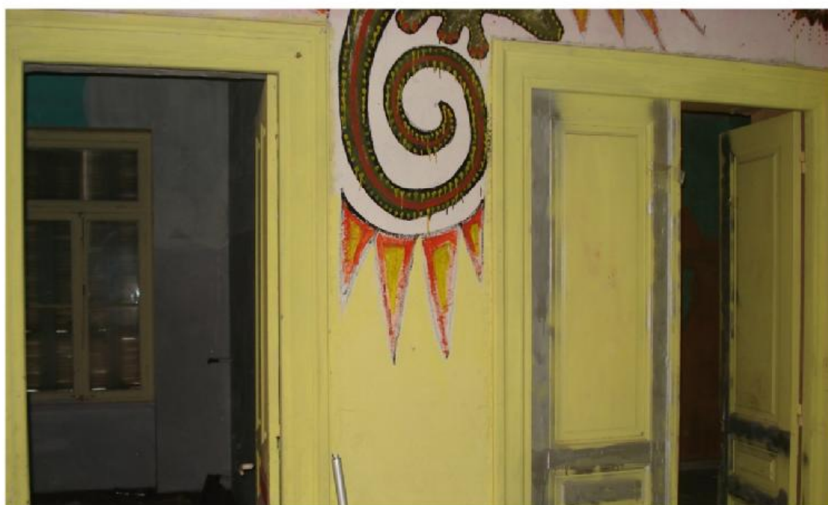
φωτ.187. Ανοίγματα χώρων 2.8. και 2.9.
