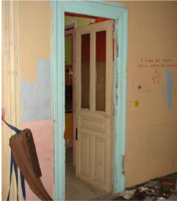
φωτ.91. Άνοιγμα Α.1.15.
