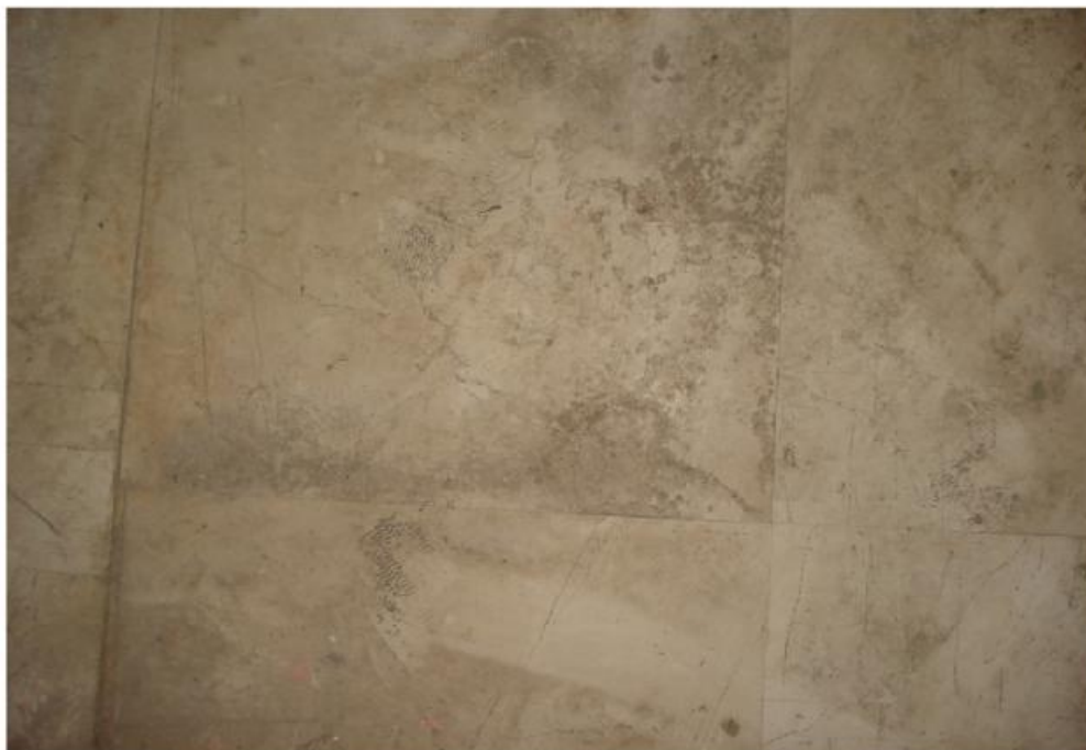
φωτ.83. Δάπεδο χώρου 1.1.
