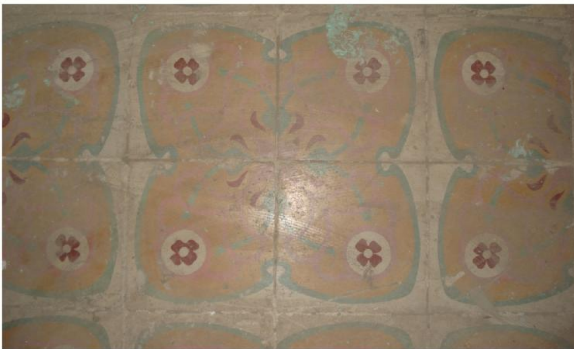
φωτ.130. Δάπεδο χώρου 2.8.
