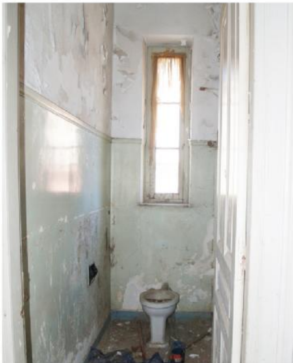
φωτ.163. w.c. ορόφου
