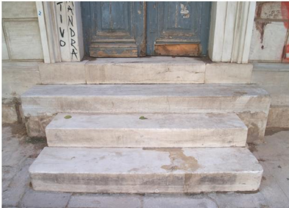
φωτ.3. Μαρμάρινη σκάλα στην είσοδο του κτιρίου
