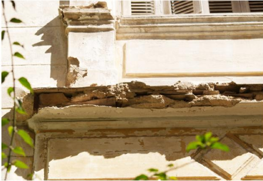
φωτ.18. Αποκόλληση τμημάτων του διακόσμου
