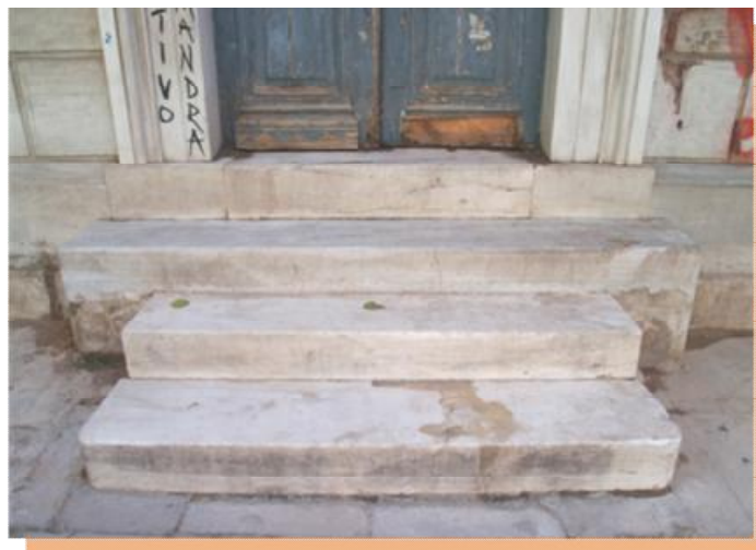
εικόνα 15: Άποψη της εξωτερικής σκάλας Σ.1.
