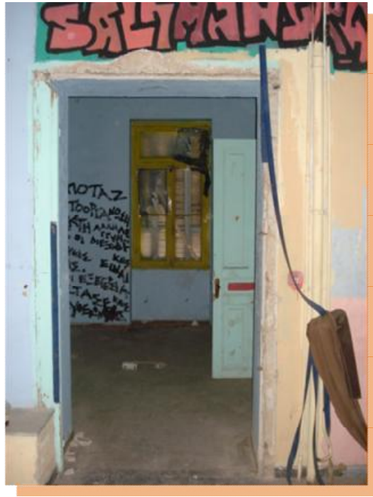
εικόνα 4: Άποψη πόρτας A.1.16
