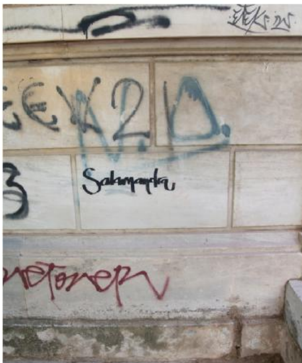
φωτ.13. Αναδυόμενη υγρασία από τα νερά της βροχής
