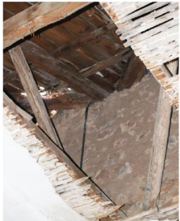
φωτ.155. Πέτσωμα στέγης
