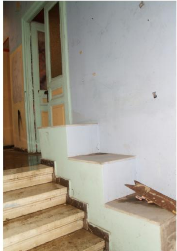
φωτ.40. Περβάζι δίπλα στη σκάλα
