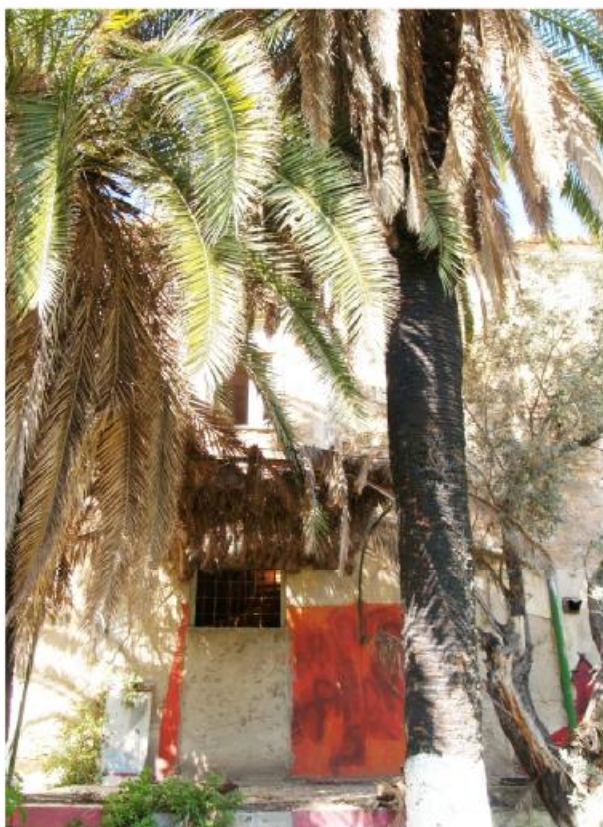
φωτ.28. Άποψη ανατολικής όψης
