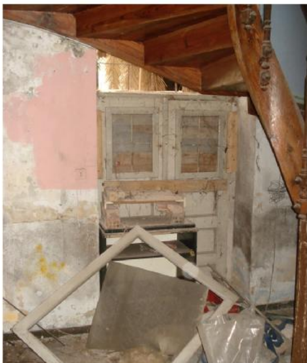
φωτ.78. Άνοιγμα Α.1.6.
