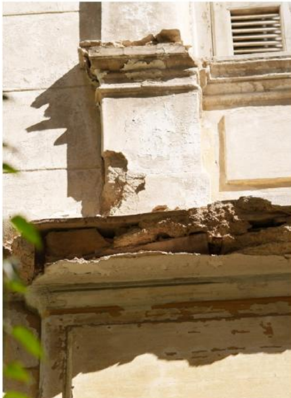
φωτ.19. Αποκόλληση τμημάτων του διακόσμου
