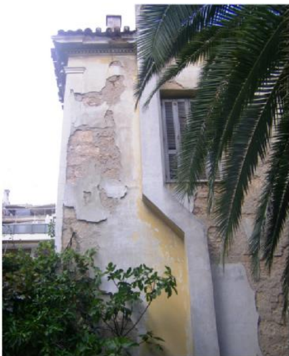
φωτ.113. Νότιο τμήμα πίσω όψης
