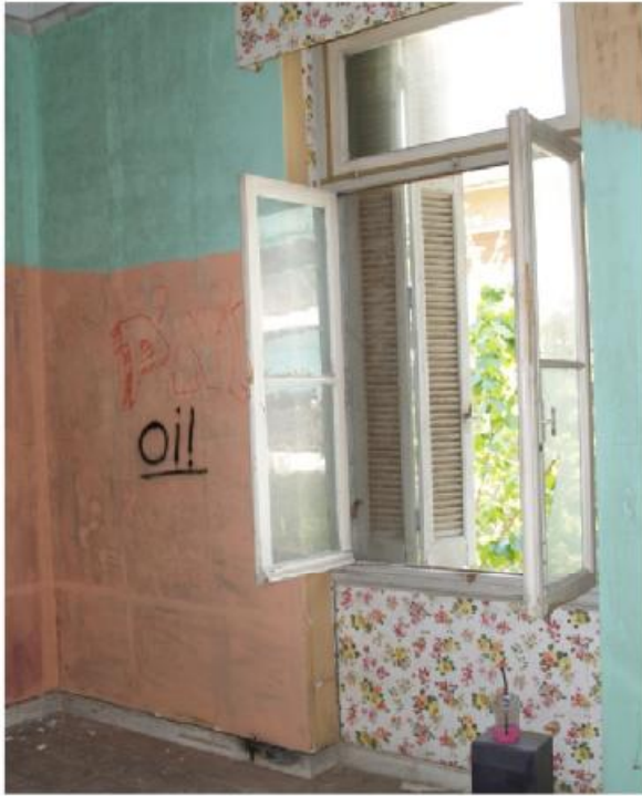
φωτ.138. Άνοιγμα Α.2.6.
