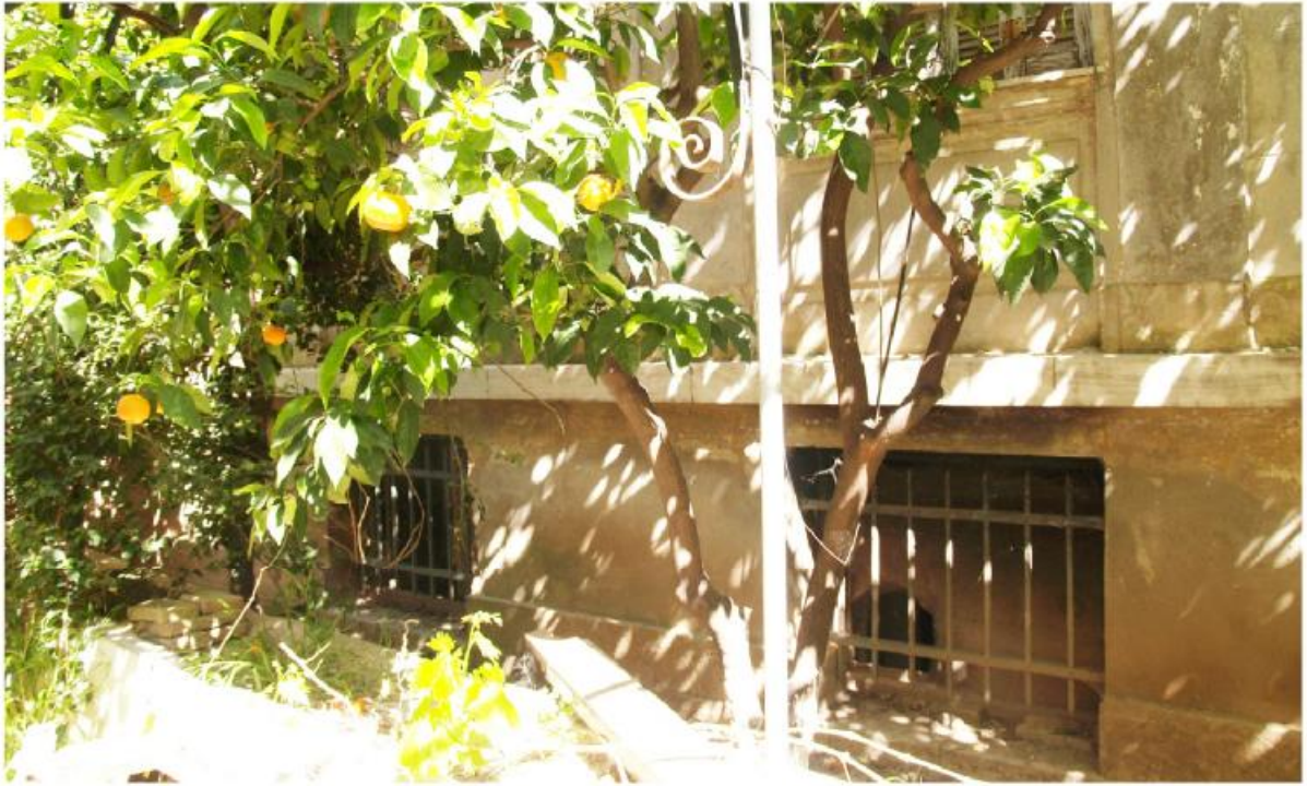
φωτ.196 Παράθυρα υπογείου
