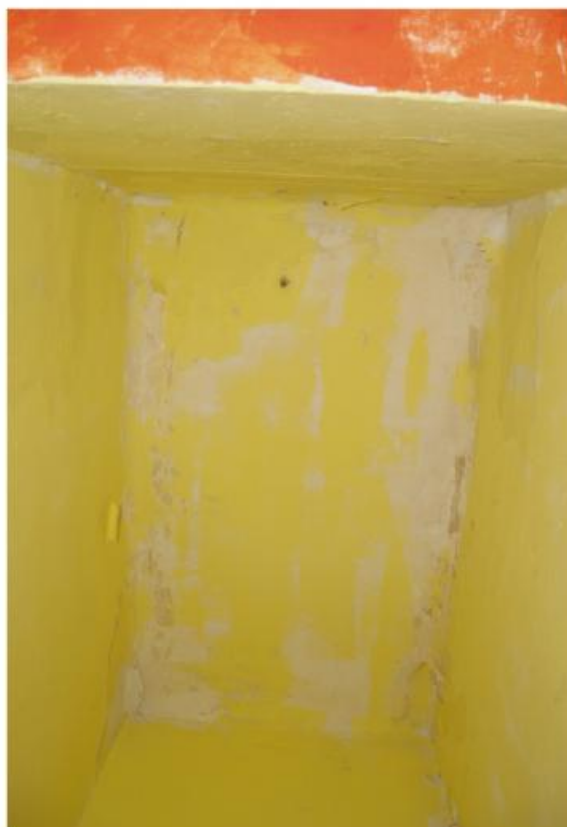
φωτ.55. Οροφή χολ
