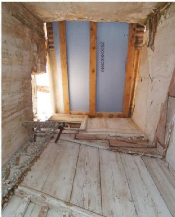
φωτ.180. Κάλυψη οροφής χώρου 2.2. με σανίδες
