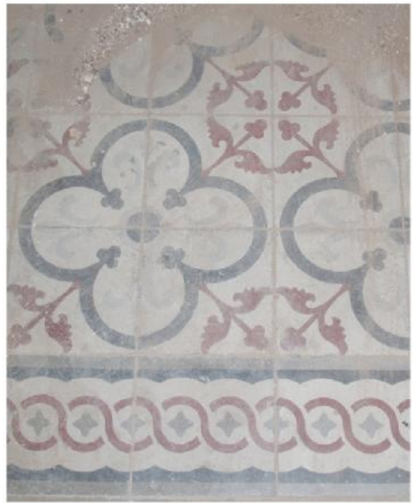
φωτ.162. Δάπεδο χώρου 2.5.
