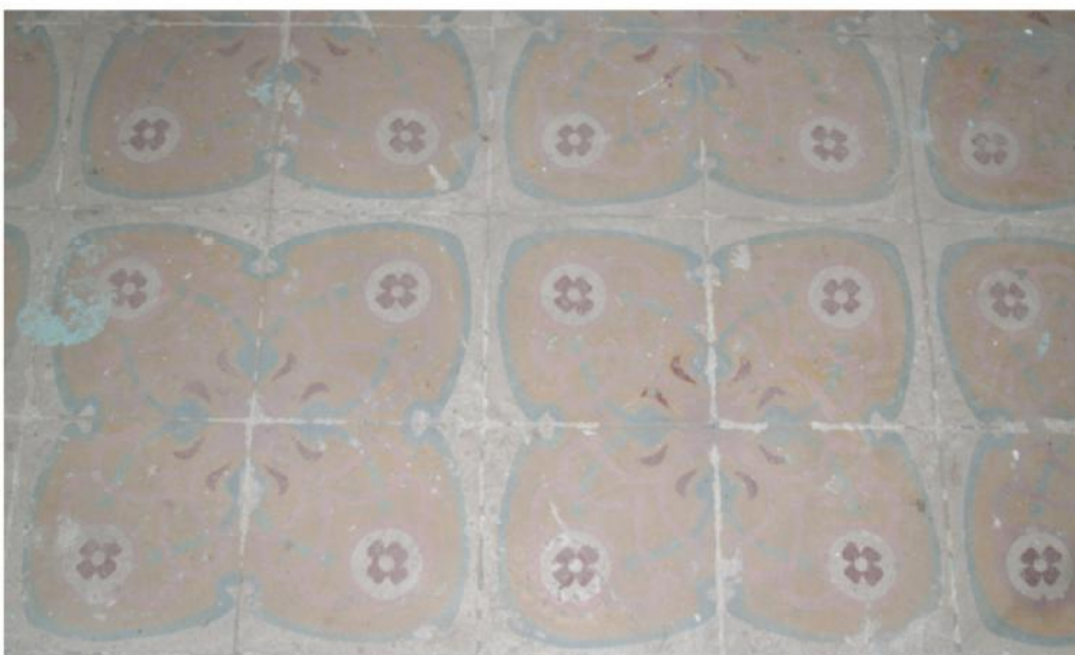
φωτ.131. Δάπεδο χώρου 2.8
