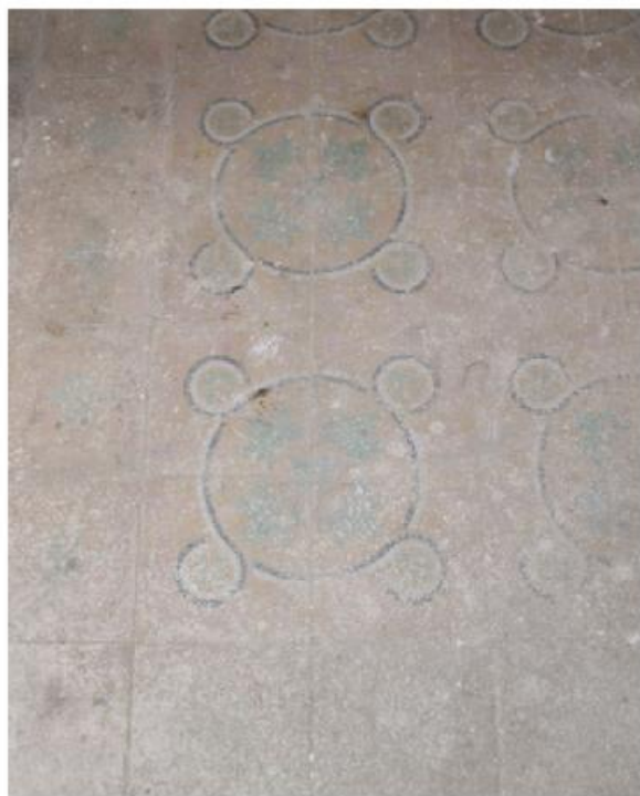
φωτ.194. Δάπεδο χώρου 2.6.
