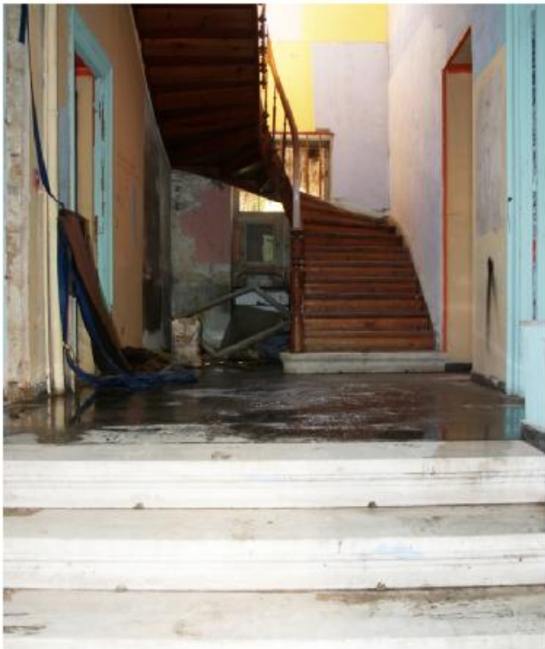
φωτ.36. Άποψη του χολ του ισόγειου
