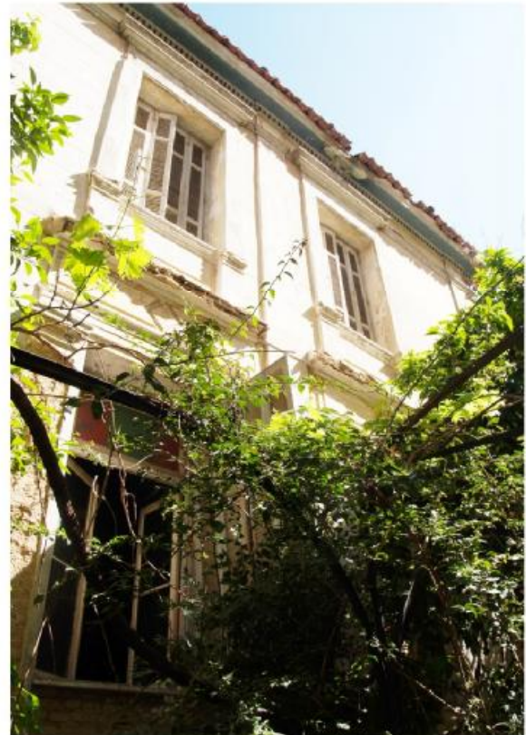
φωτ.20. Άποψη νότιας όψης
