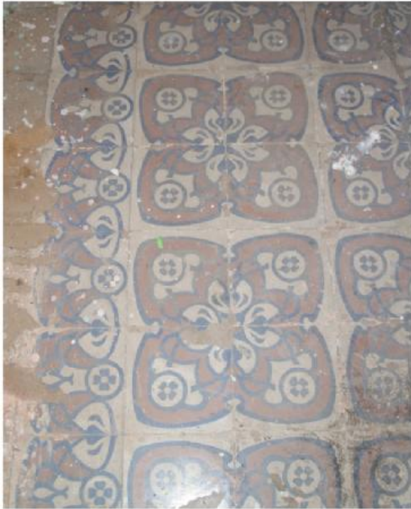
φωτ.144. Δάπεδο χώρου 2.9.
