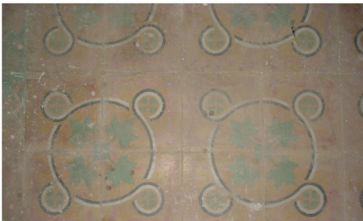
φωτ.195. Δάπεδο χώρου 2.6.
