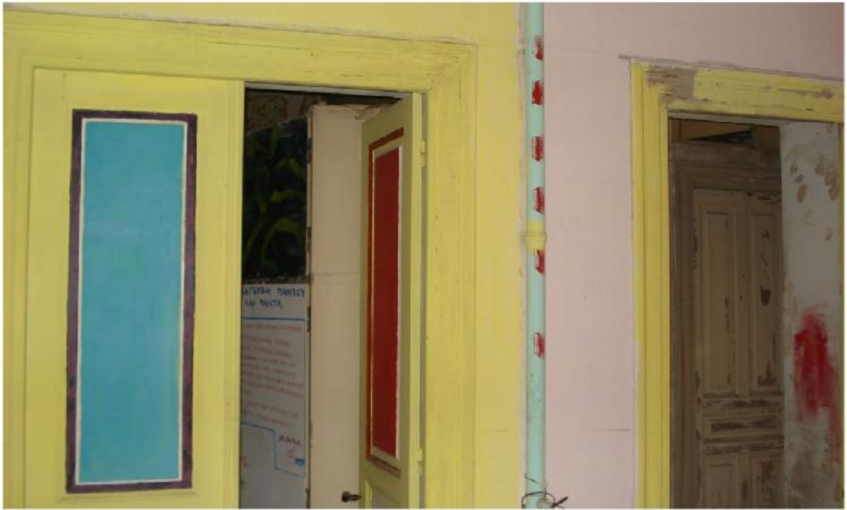
φωτ.188. Ανοίγματα χώρων 2.5. και 2.3.
