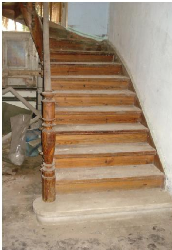
φωτ.77. Ξύλινη εσωτερική σκάλα
