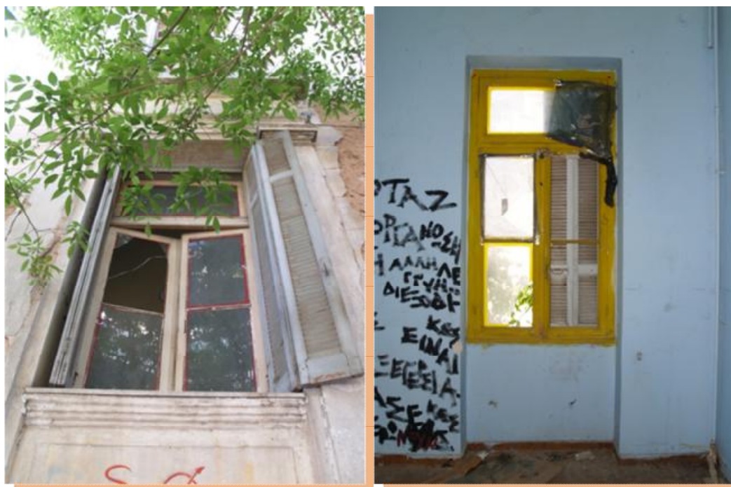
εικόνα 22: Παράθυρο ισογείου (εξωτερικά)
