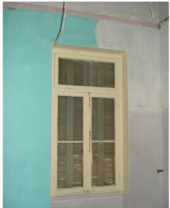
φωτ.123. Άνοιγμα Α.2.9.
