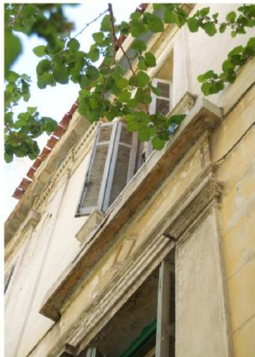
φωτ.17. Διάκοσμος ανοιγμάτων πρόσοψης
