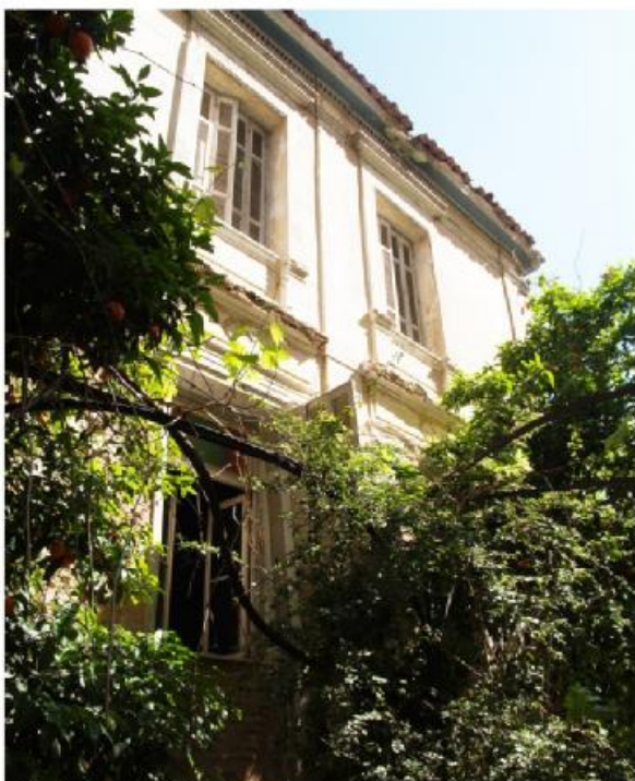
φωτ.100. Άποψη νότιας όψης
