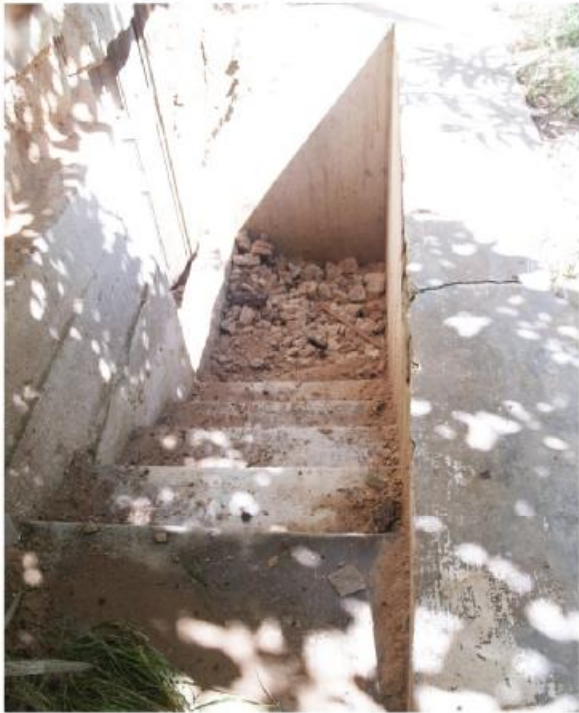
φωτ.199. Σκάλα υπογείου
