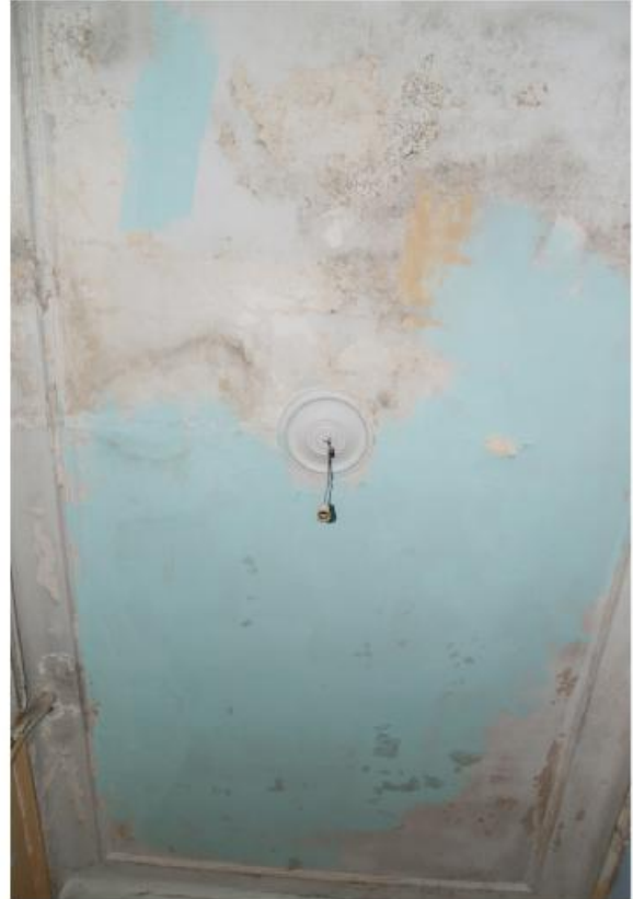
φωτ.35. Οροφή του κεντρικού χολ στο ισόγειο
