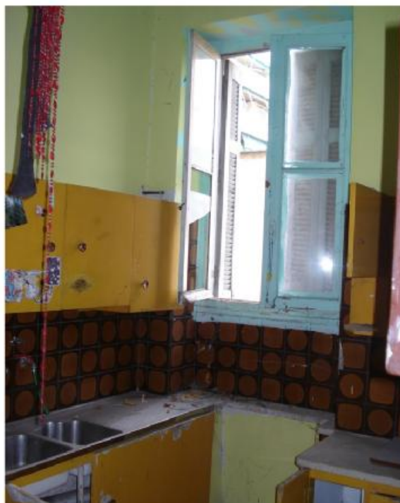
φωτ.79. Άνοιγμα Α.1.8.
