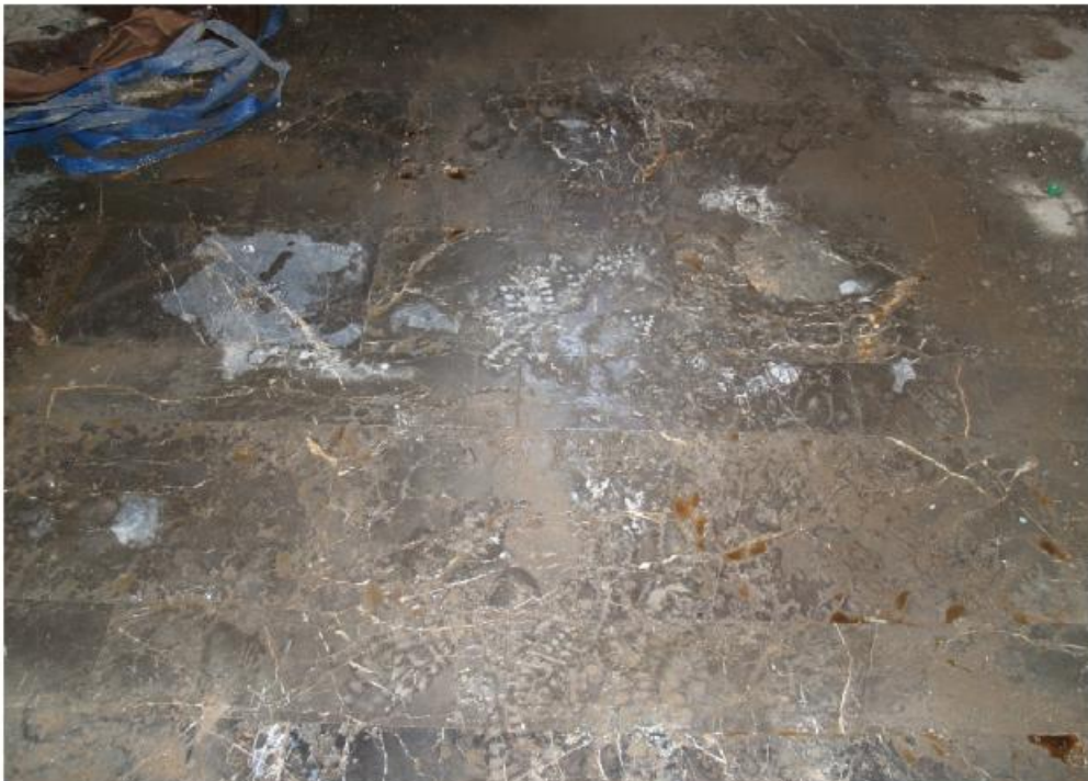
φωτ.64. Δάπεδο του χολ του ισόγειου
