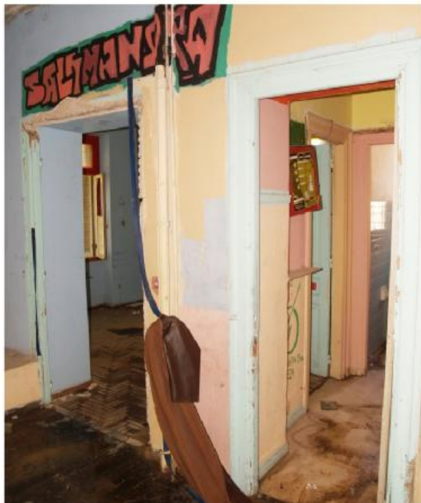
φωτ.47. Εσωτερικά ανοίγματα ισογείου
