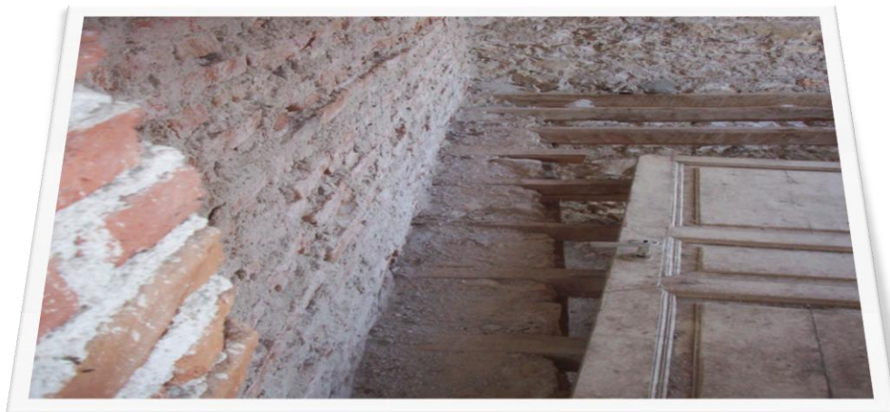
Εικ.9 Πακτωμένοι δοκοί στην φέρουσα τοιχοποιία
