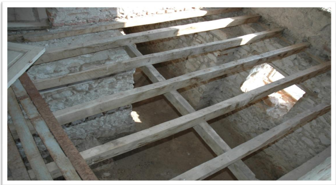
Εικ.5 Περιμετρικοί τοίχοι υπογείου κτισμένοι από αργολιθοδομή
