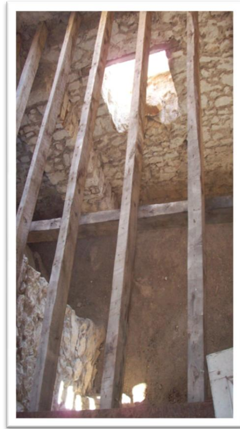
Εικ.7,8 Υφιστάμενη κατάσταση δοκών Β' στάθμης
