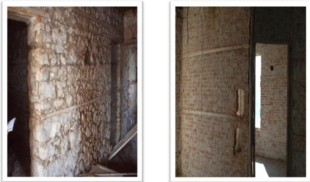
Εικ.10,11 Απογυμνωμένοι τοίχοι στις Β,Γ στάθμες αντίστοιχα
