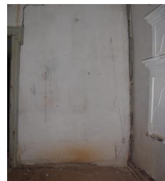
Εικόνα 9: Αποκόλληση- καμπύλη τοίχων
