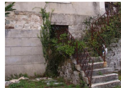
Εικόνα 42: Οξείδωση σιδεριάς
