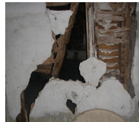
Εικόνα 11: Κατάρρευση τοιχοποιίας
