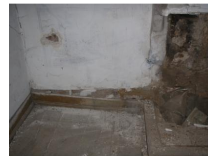
Εικόνα 25: Μετατόπιση σοβατεπί
