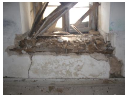
Εικόνα 36: Αποδιοργάνωση κονιάματος
