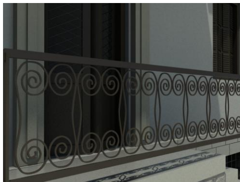
Εικόνα 2: Κιγκλιδώματα εξωτερικού κλιμακοστασίου
