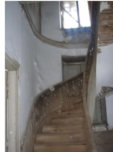
Εικόνα 56: Αποδιοργάνωση επιχρίσματος
