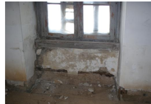
Εικόνα 15: Κατάρρευση επιχρίσματος
