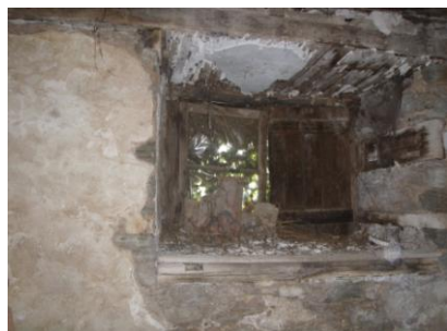
Εικόνα 40: Αποσάθρωση κουφωμάτων
