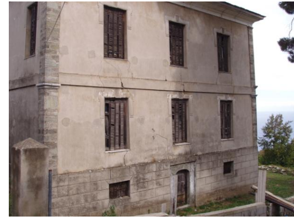
Εικόνα 3: Ανιούσα υγρασία
