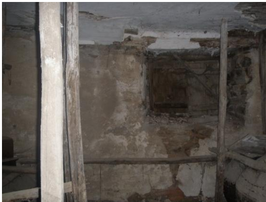
Εικόνα 4: Απόπλυση αρμολογήματος στα ανοίγματα
