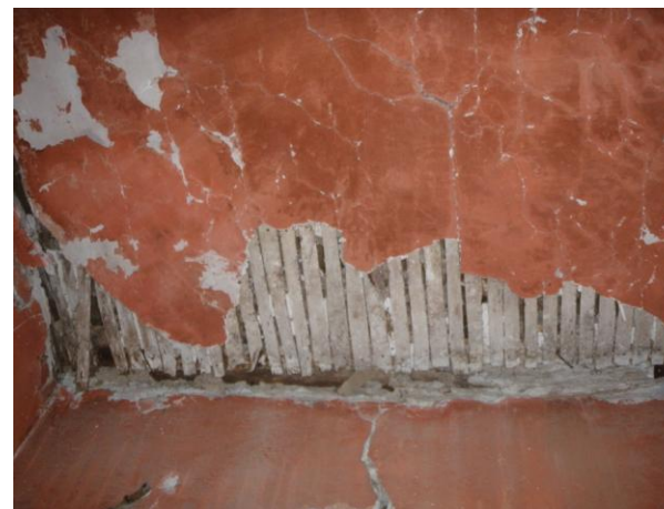
Εικόνα 46: Κατάρρευση επιχρίσματος
