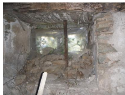
Εικόνα 34: Αποδιοργάνωση κονιάματος
