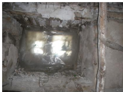
Εικόνα 41: Διάβρωση κουφωμάτων
