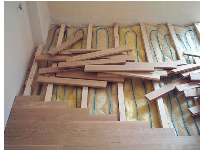
Εικόνα 7: Δάπεδο υπό κατασκευή
