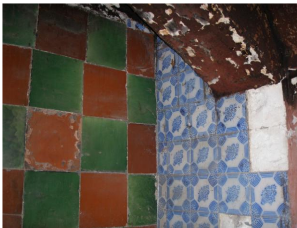
Εικόνα 45: Αποκόλληση πλακιδίων
