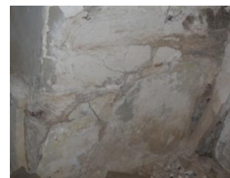
Εικόνα 8: Ανιούσα υγρασία
