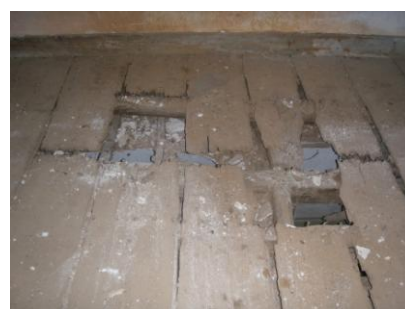
Εικόνα 31: Διάβρωση ξύλινων σανίδων
