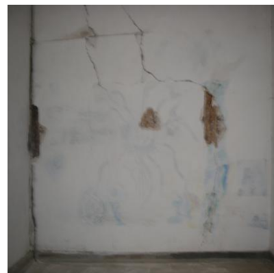
Εικόνα 10: Διάτρητες ρωγμές
