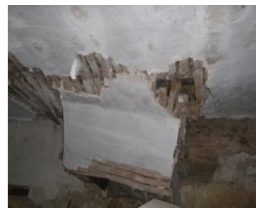
Εικόνα 22: Κατάρρευση οροφής
