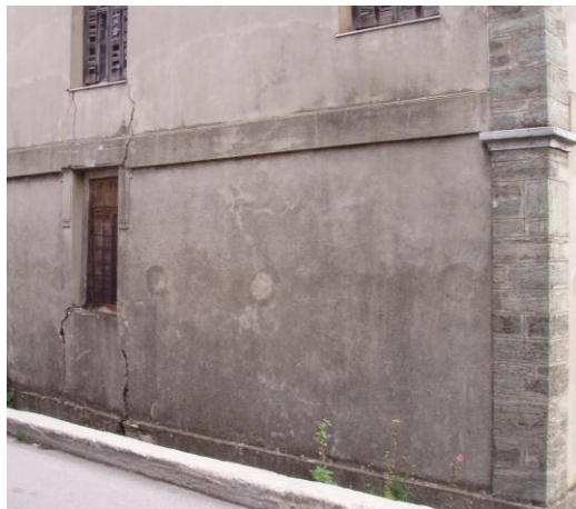
Εικόνα 47: Αλλοίωση επιχρίσματος
