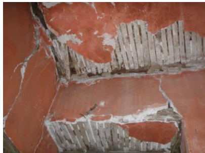
Εικόνα 29: Αποδιοργάνωση κονιάματος
