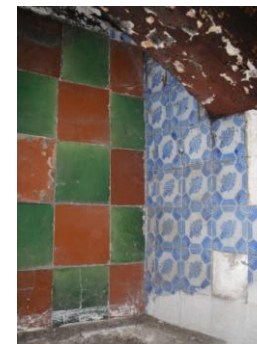
Εικόνα 51: Αποκόλληση πλακιδίων
