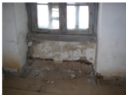
Εικόνα 30: Απομάκρυνση σοβατεπί
