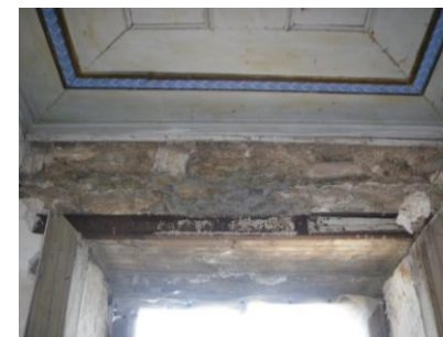
Εικόνα 37: Κατάρρευση επιχρίσματος
