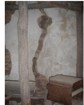
Εικόνα 2: Διαμπερής ρωγμή
