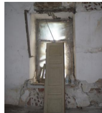
Εικόνα 7: Κατάρρευση επιχρίσματος
