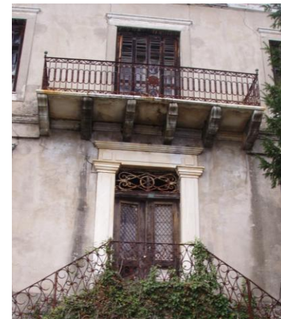
Εικόνα 49: Αλλοίωση επιχρίσματος
