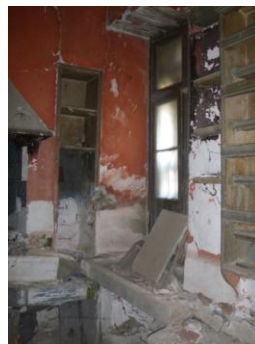
Εικόνα 50: Διάβρωση ερμαρίων
