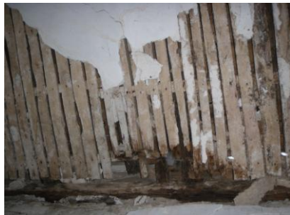
Εικόνα 28: Κατάρρευση επιχρίσματος
