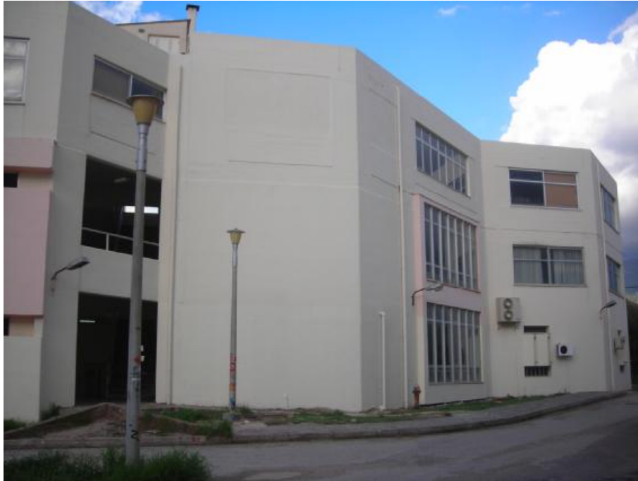
Εικόνα 3.7. Νότια πλευρά του κτιρίου
