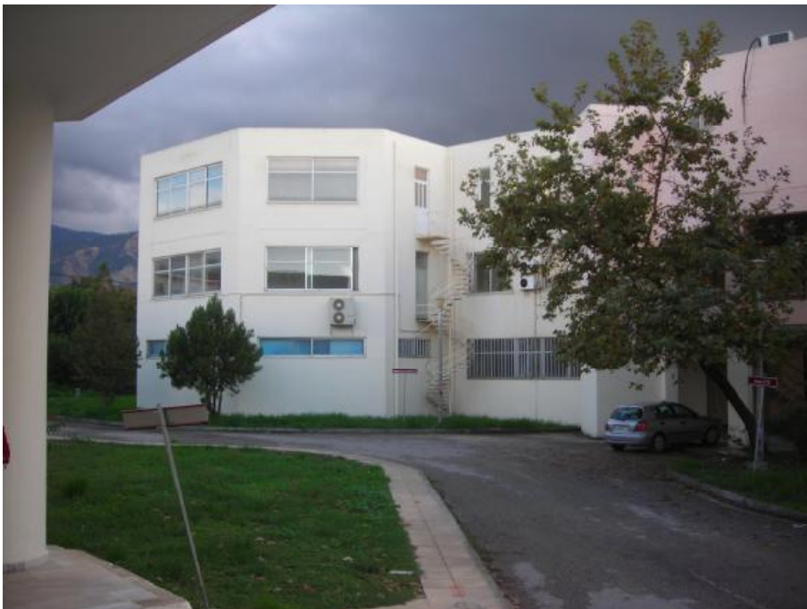
Εικόνα 3.9. Νότια πλευρά του κτιρίου
