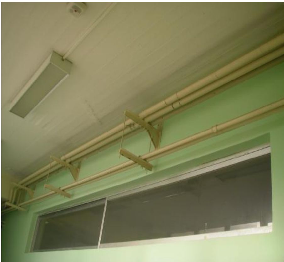
Εικόνα 3.43. Εσωτερικός χώρος του κτιρίου – φεγγίτες
