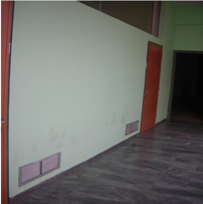
Εικόνα 3.23. Εσωτερικός χώρος του κτιρίου – διάδρομος
