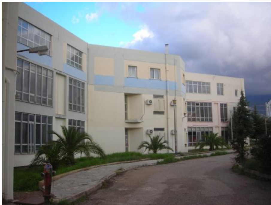
Εικόνα 3.8. Νότια πλευρά του κτιρίου
