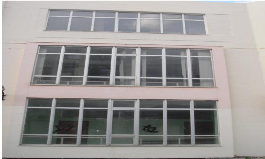
Εικόνα 3.40. Νότια πλευρά του κτιρίου – ανοίγματα ,εξωτερικά του κτιρίου
