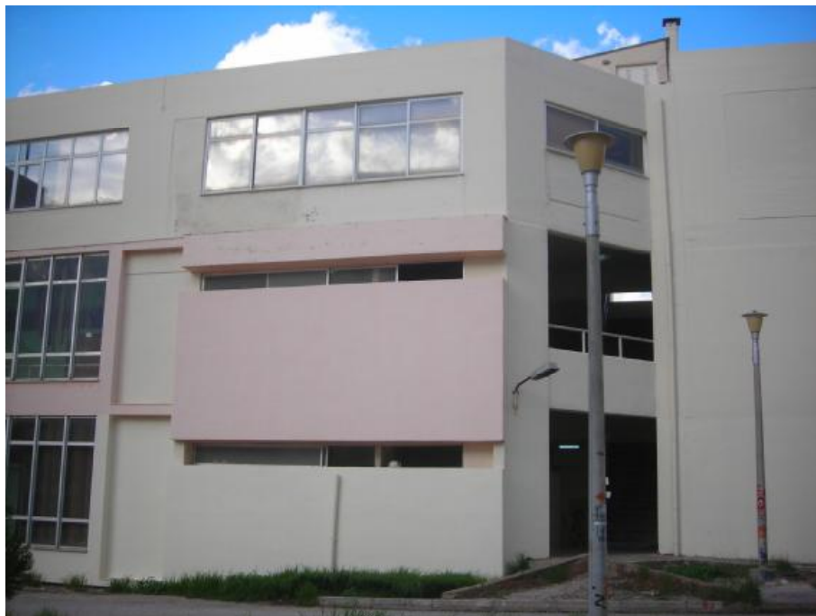
Εικόνα 3.6. Νότια πλευρά του κτιρίου
