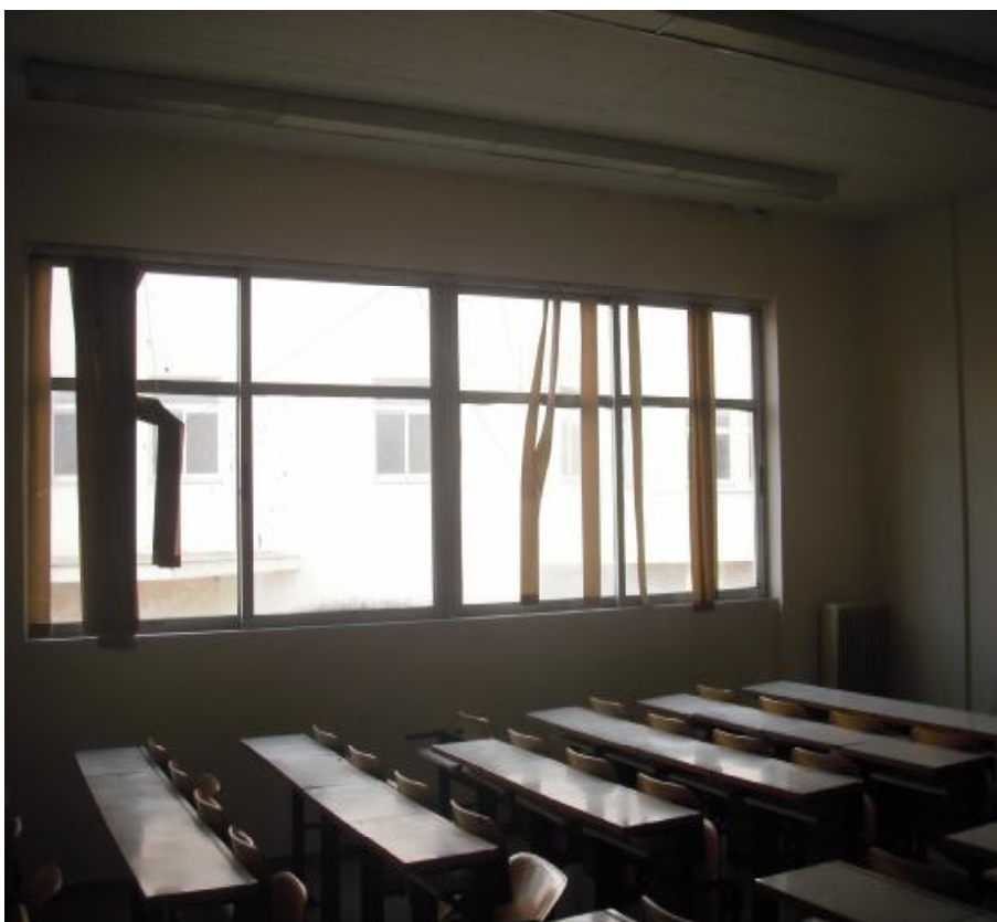
Εικόνα 3.32. Εσωτερικός χώρος του κτιρίου
