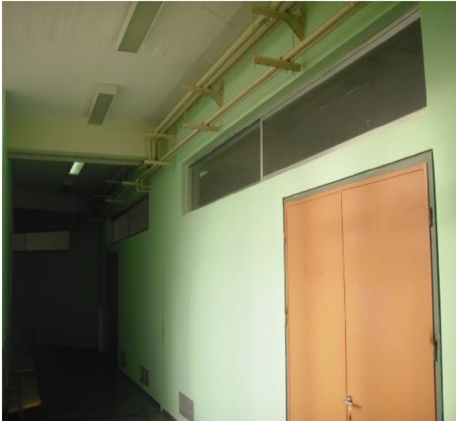
Εικόνα 3.42. Εσωτερικός χώρος του κτιρίου – διάδρομος
