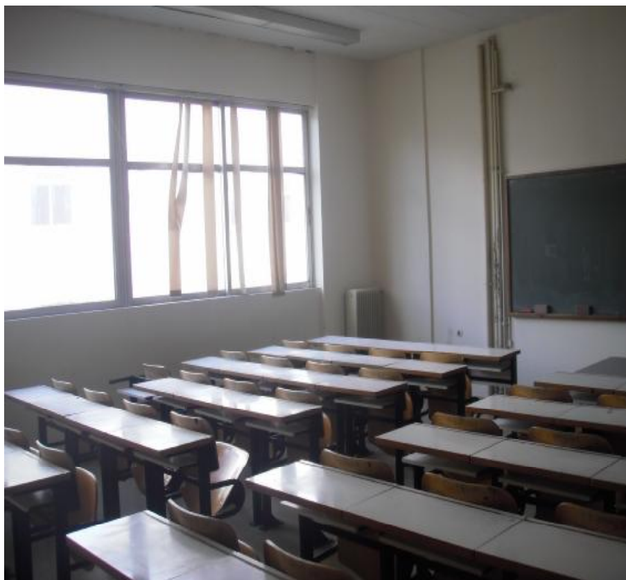
Εικόνα 3.33. Εσωτερικός χώρος του κτιρίου
