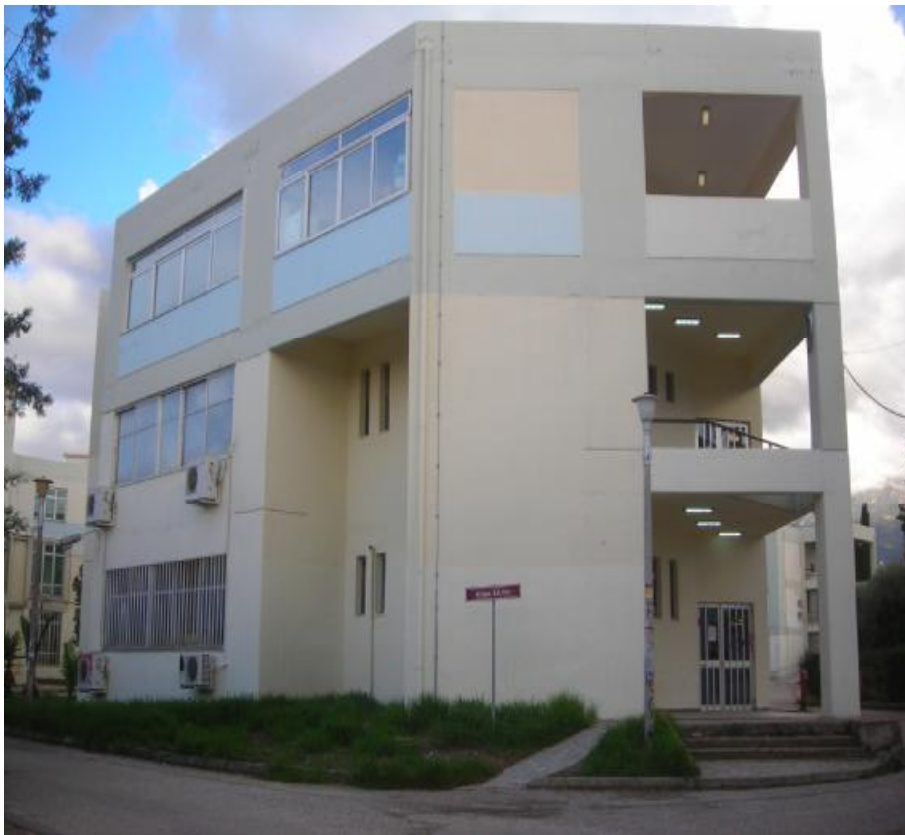
Εικόνα 3.22. Δυτική πλευρά του κτιρίου
