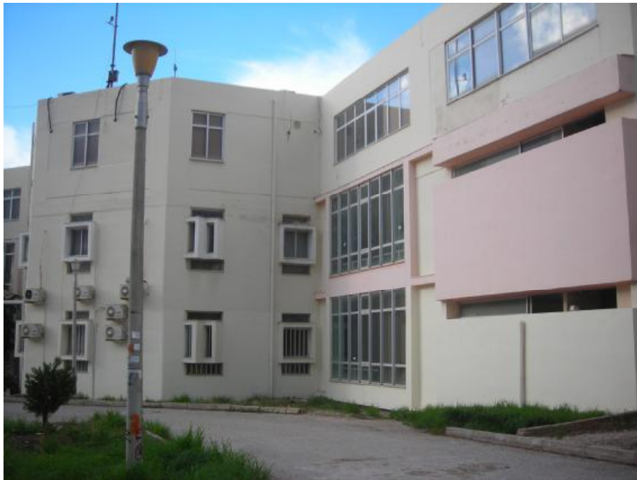
Εικόνα 3.5. Νότια πλευρά του κτιρίου
