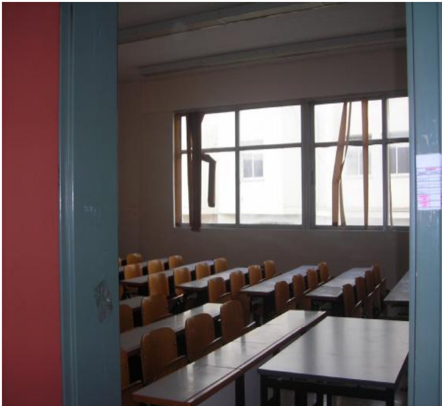
Εικόνα 3.28. Εσωτερικός χώρος του κτιρίου
