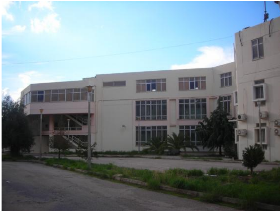
Εικόνα 3.4. Νότια πλευρά του κτιρίου
