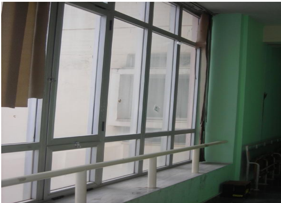
Εικόνα 3.41. Εσωτερικός χώρος του κτιρίου – ανοίγματα,εσωτερικά του κτιρίου
