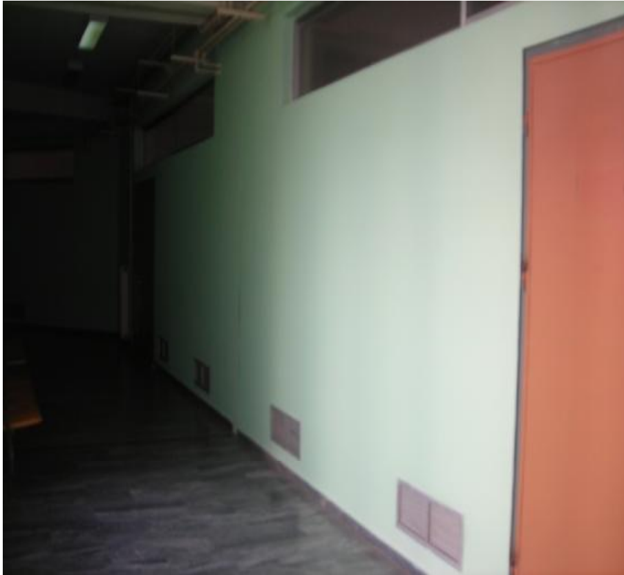
Εικόνα 3.29. Εσωτερικός χώρος του κτιρίου
