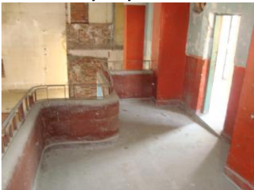
Εικ.11 Εμφανές σκυρόδεμα στο πάτωμα του εσωτερικού εξώστη της σκηνής
