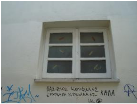
Εικ.28 Κούφωμα στην νοτιοδυτική όψη.
