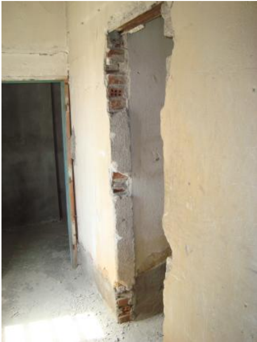
Εικ.7 Εσωτερική τοιχοποιία.
