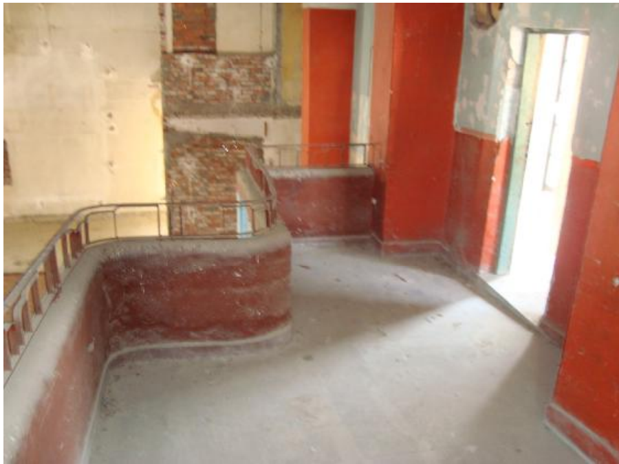
Εικ.32 Κιγκλιδώματα εσωτερικού εξώστη.
