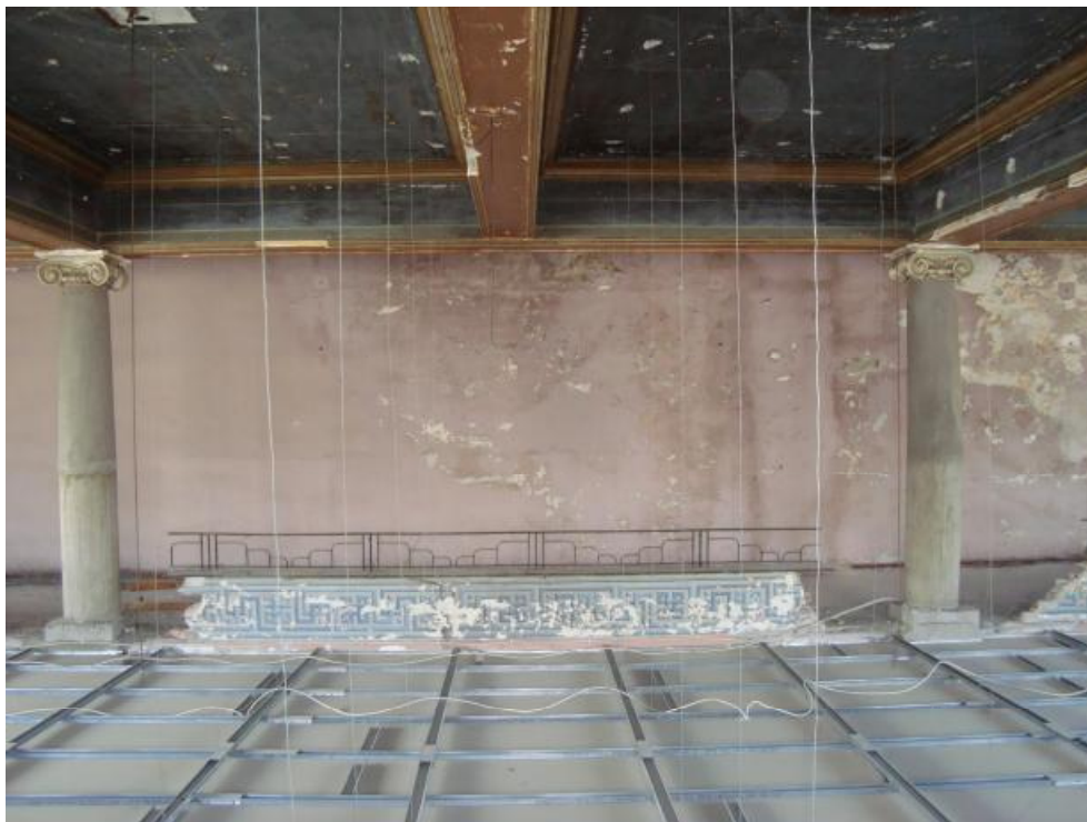
Εικ.33 Κιγκλιδώματα εσωτερικού εξώστη.
