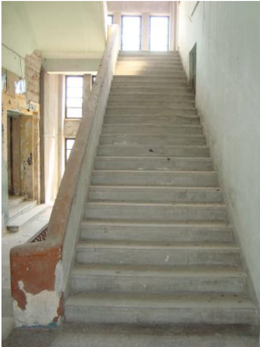
Εικ.15 Εσωτερική σκάλα.
