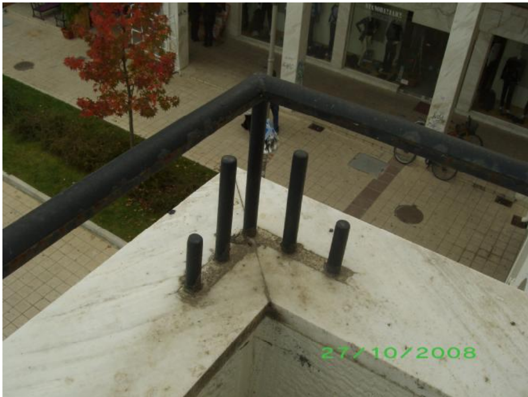
Εικ.31 Κιγκλιδώματα εξωτερικού εξώστη.
