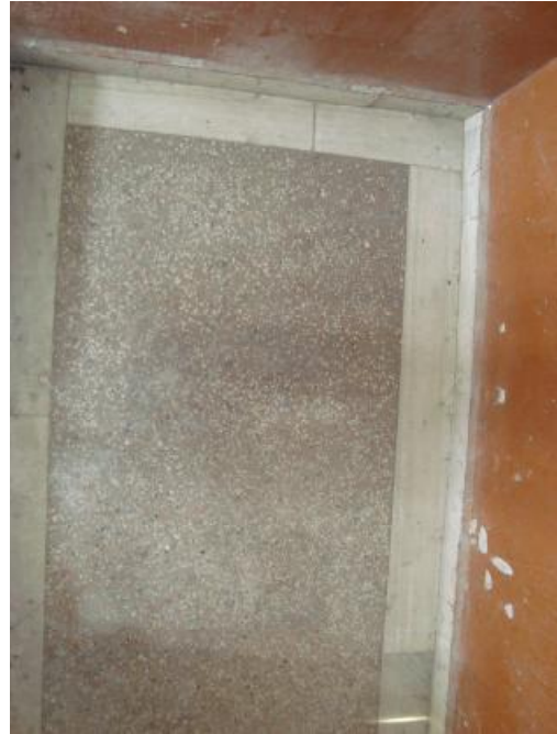
Εικ.14 Πλατύσκαλο κλιμακοστασίου.
