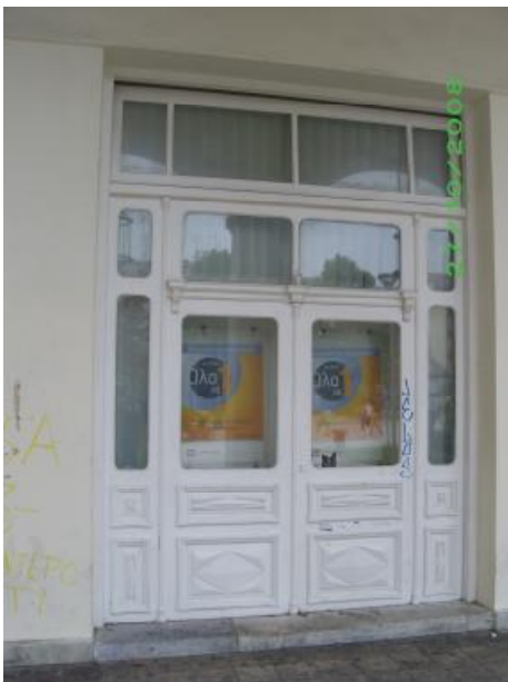
Εικ.29 Εξωτερικό κούφωμα εξώθυρας.
