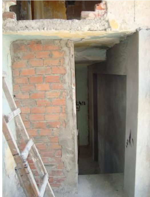
Εικ.8 Εσωτερική και εξωτερική τοιχοποιία
