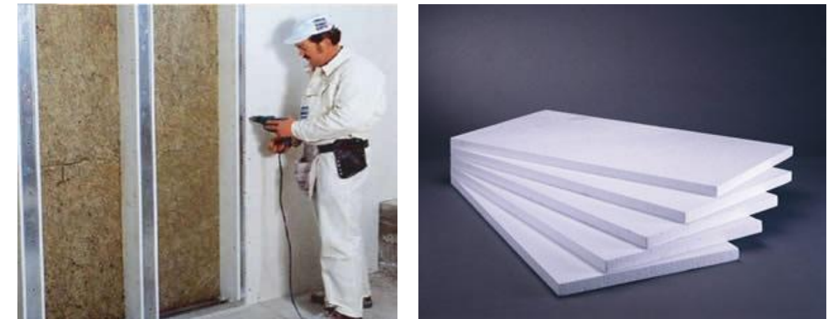
Εικόνα 199. Αριστερά φαίνεται η διαδικασία τοποθέτησης πλακών πετροβάμβακα, ενώ αριστερά οι πλάκες διογκωμένης πολυστερίνης.
