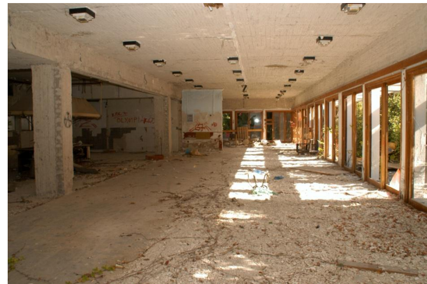
Εικόνα 125. Άποψη των συνεχόμενων ανοιγμάτων στην νοτιοδυτική όψη.
