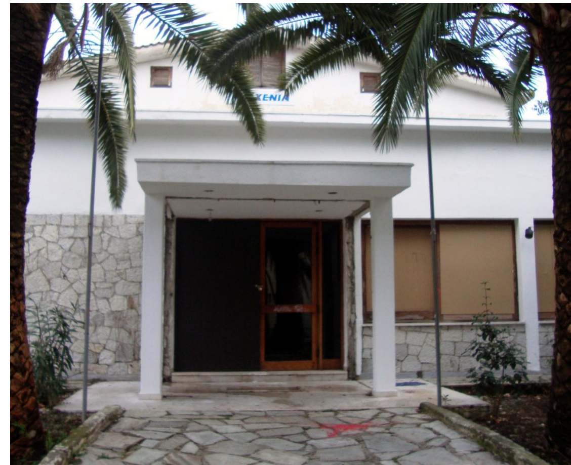
Εικόνα 89. Η προεξοχή, του κλειστού στεγάστρου, της κεντρικής εισόδου στο κτίριο 2.
