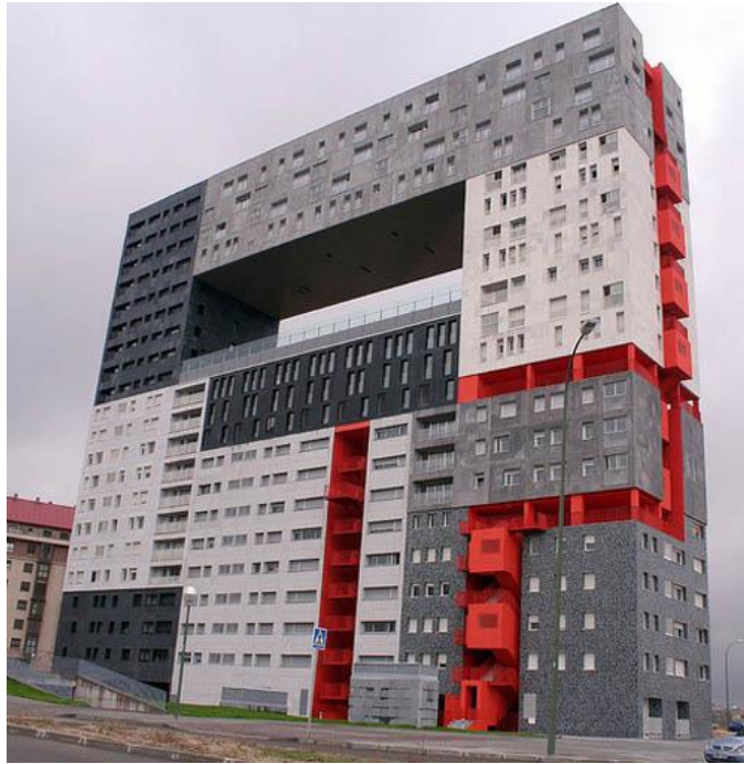
Εικόνα 138. Πολυκατοικία στην Μαδρίτη.
