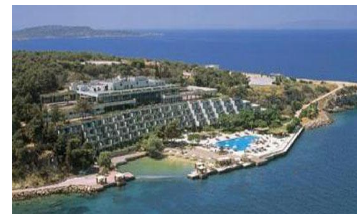
Εικόνα 13. Το συγκρότημα "Αστήρ Παλλάς" στη Βουλιαγμένη, των Π. Βασιλειάδη, Κ.Δεκαβάλλα και Α. Γεωργιάδη, 1958-60
