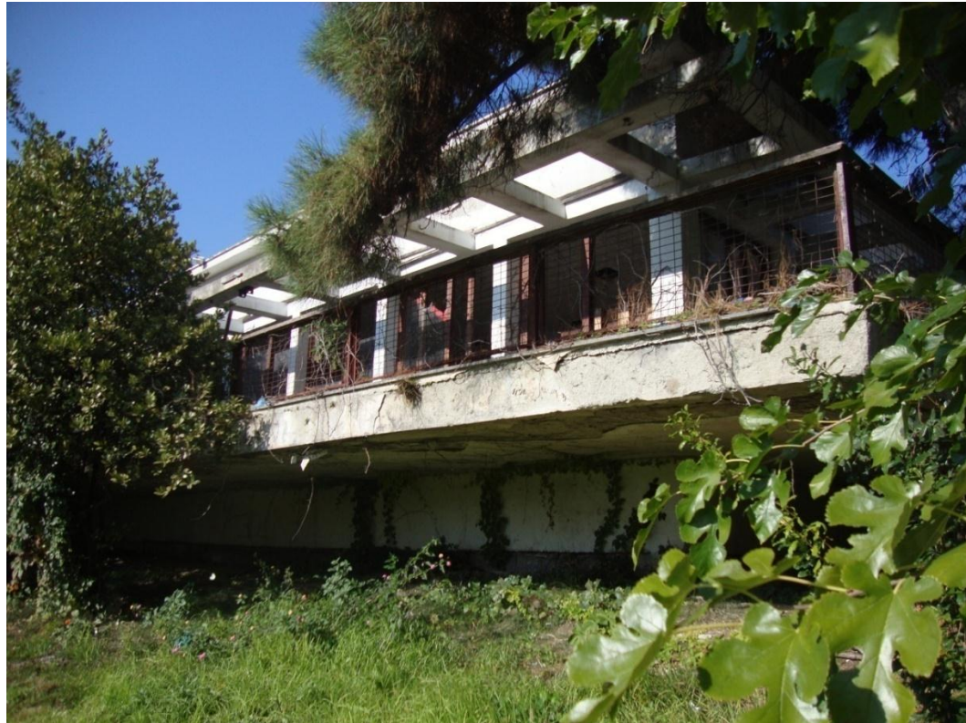
Εικόνα 93. Νοτιοδυτική όψη του κτιρίου 3.
