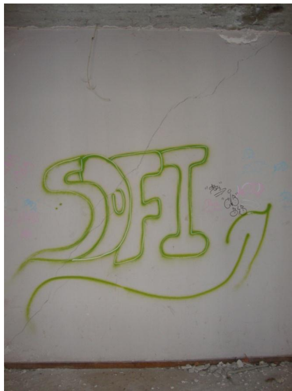
Εικόνα 132. Έντονη ρηγματώση σε τοιχοποιία πλήρωσης του κτιρίου 3.
