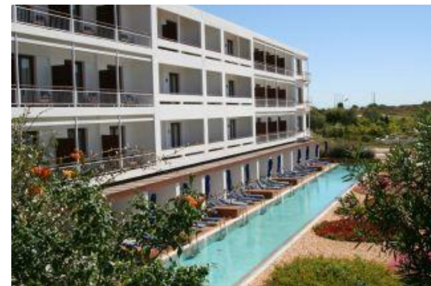
Εικόνα 44. Άποψη την όψης του κτιρίου που έχει θέα σε διαμορφωμένο περιβάλλοντα χώρο.
