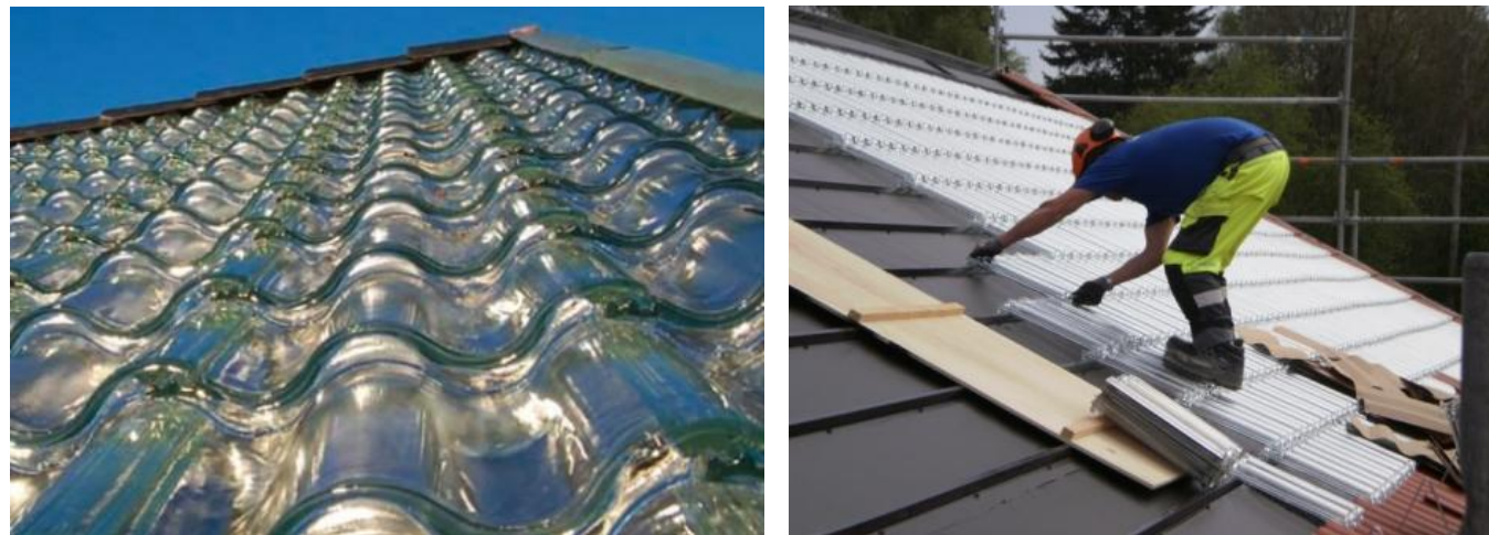
Εικόνα 202. Αριστερά βλέπουμε την όψη της στέγης με τα γυάλινα κεραμίδια και δεξιά τον τρόπο τοποθέτησης τους.
