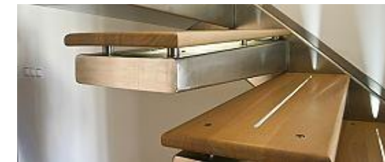
Εικόνα 204. Τύπος εσωτερικής κλίμακας κτιρίου 1.
