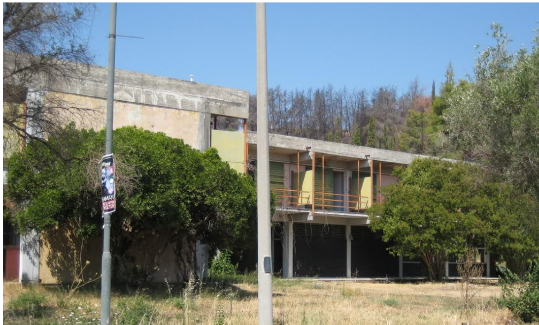
Εικόνα 45. Η σημερινή κατάσταση του Ξενία Ολυμπίας Ζεύς.
