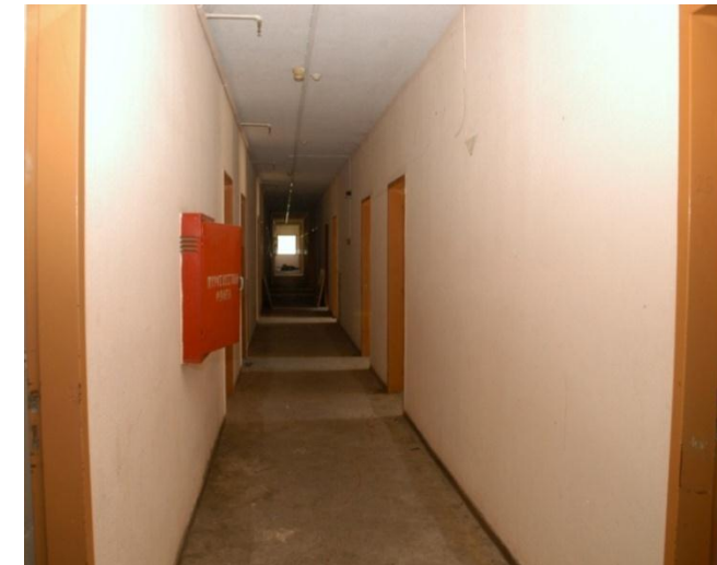
Εικόνα 103. Κεντρικός διάδρομος κτιρίου 1.
