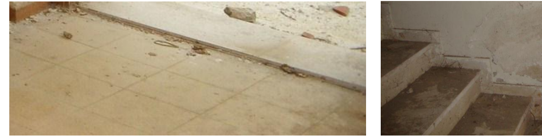
Εικόνα 98,99. Αριστερά φαίνονται τα κεραμικά πλακίδια των δωματίων και δεξιά οι μαρμαρόπλακες που καλύπτουν τις σκάλες.
