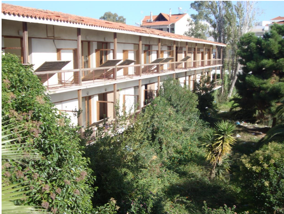
Εικόνα 74. Φωτογραφία κατάστασης διατήρησης του Ξενία Ναυπάκτου.
