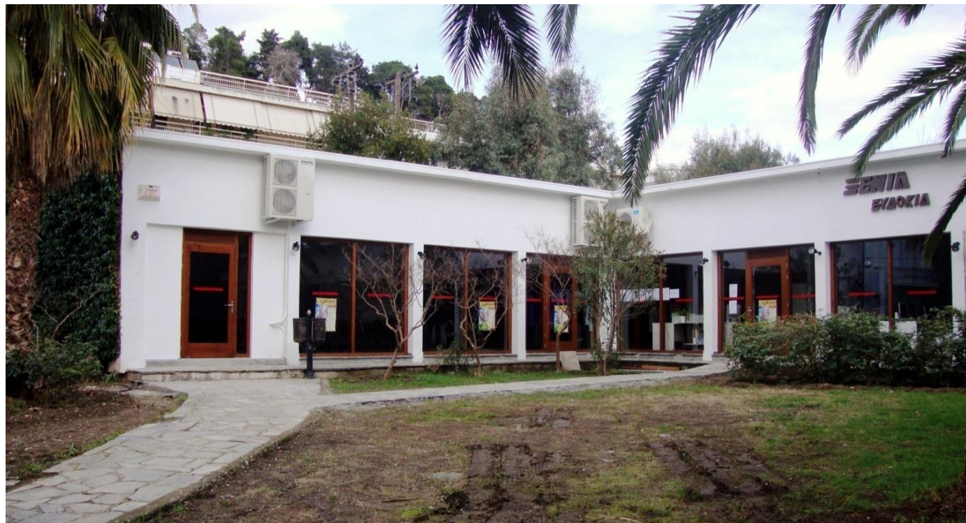
Εικόνα 88. Άποψη του κτιρίου σχήματος Γ.
