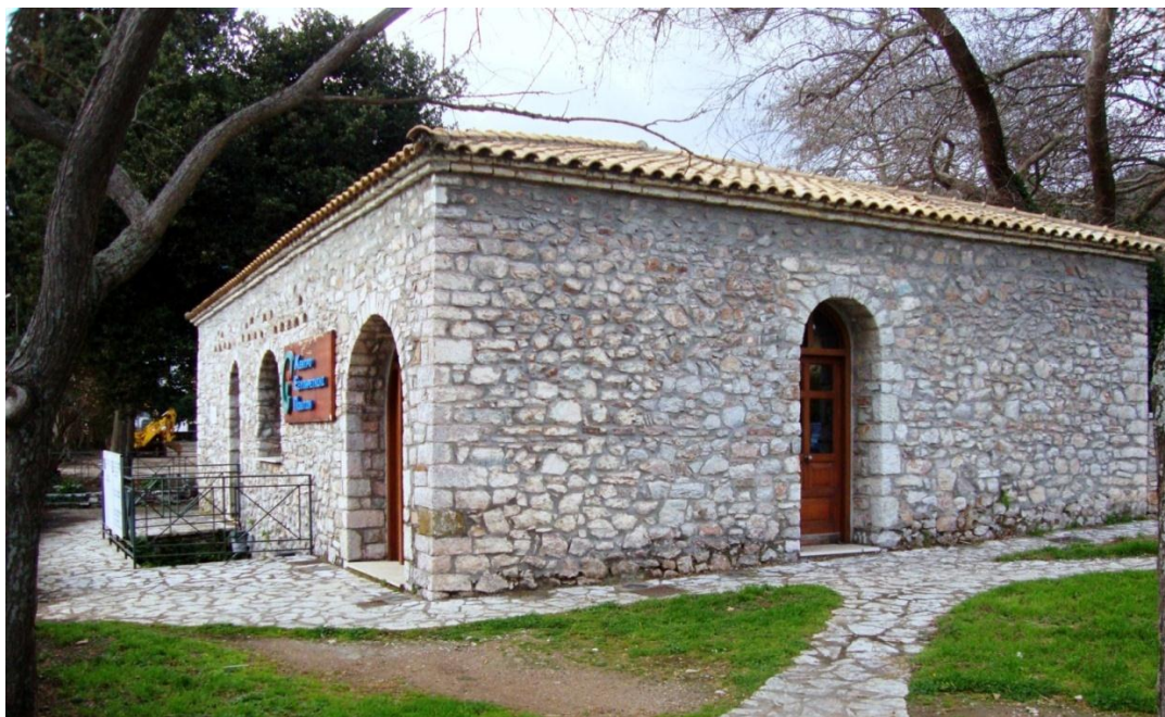
Εικόνα 94. Άποψη του κτιρίου του ΚΕΠ.
