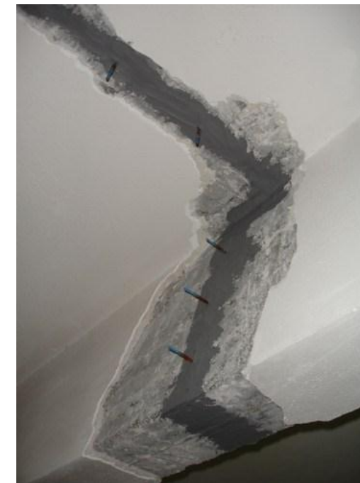
Εικόνα 197. Μέθοδος Ρητινένεσης τριχοειδούς ρηγματώσεως.
