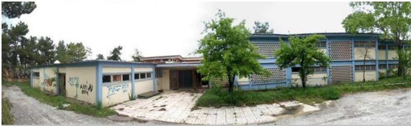
Εικόνα 64. Άποψη της εξωτερικής μορφής του ξενοδοχείου.
