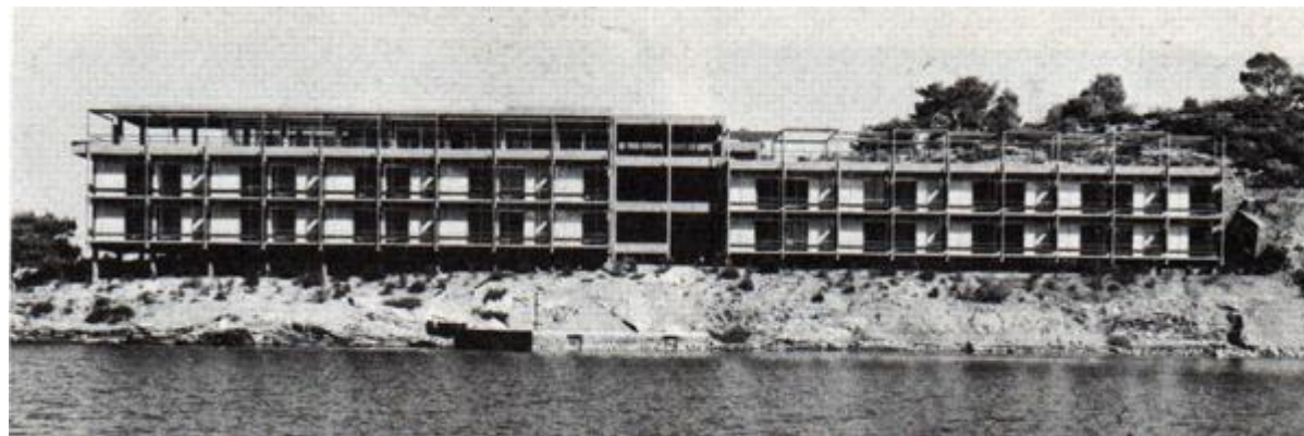
Εικόνα 60. Άποψη όψης του παλαιού Ξενία του Πόρου.
