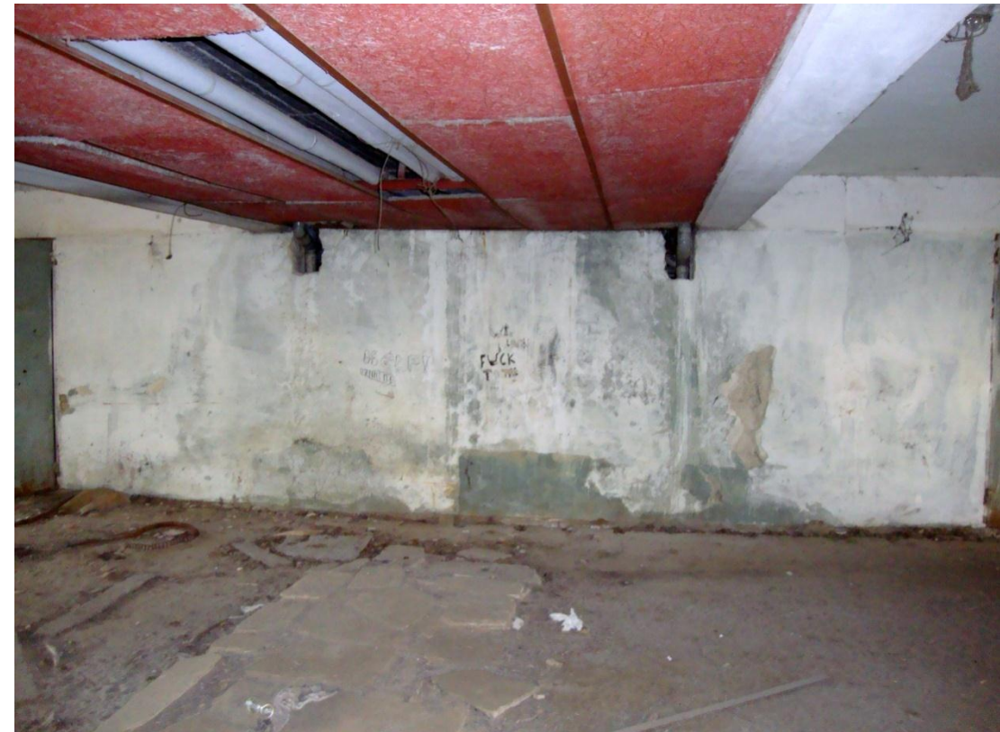
Εικόνα 100. Η ψευδοροφή στο επίπεδο της πιλοτής.
