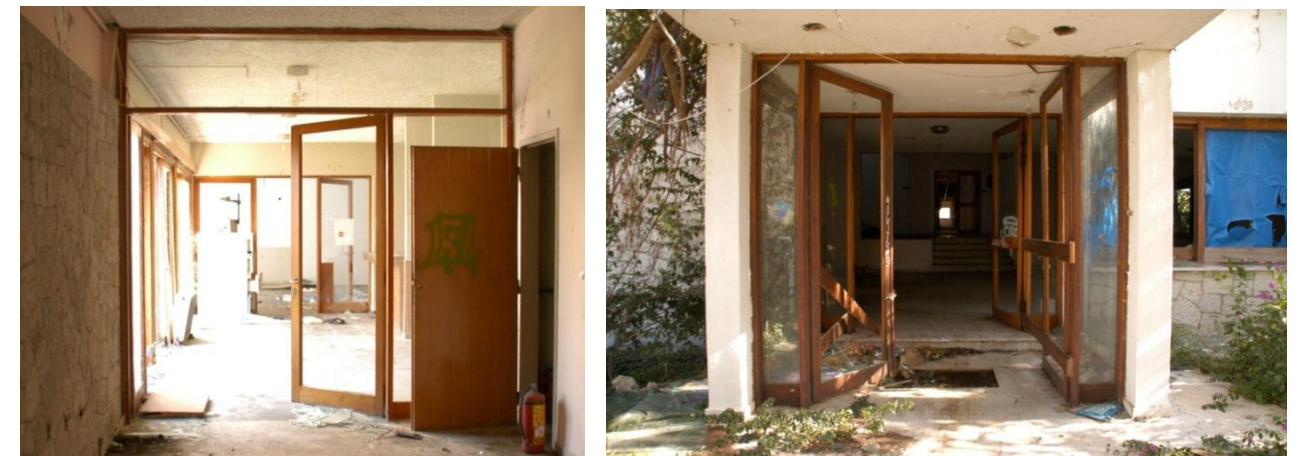
Εικόνα 113,114. Αριστερά βλέπουμε ένα εσωτερικό διαχωριστικό άνοιγμα με ξύλινα ανοιγόμενα κουφώματα και υαλοπίνακα ενώ δεξιά βλέπουμε τα κουφώματα της κεντρικής εισόδου.
