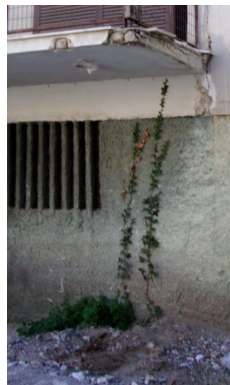
Εικόνα 106. Σαγρέ επίχρισμα επικάλυψης υπογείου κτιρίου 1.
