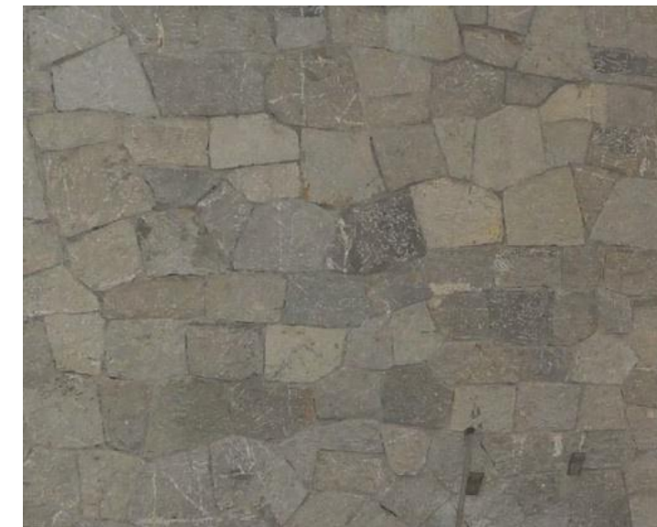
Εικόνα 110. Αργολιθοδομή με ημιλαξευτούς λίθους και κονίαμα
