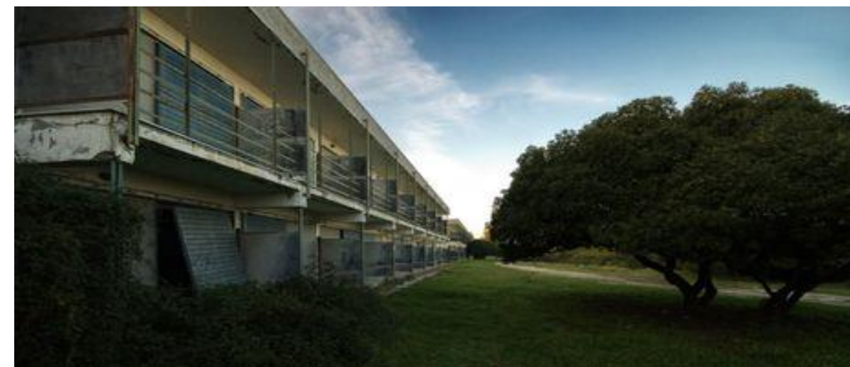
Εικόνα 53. Η σημερινή κατάσταση του ξενοδοχείου.
