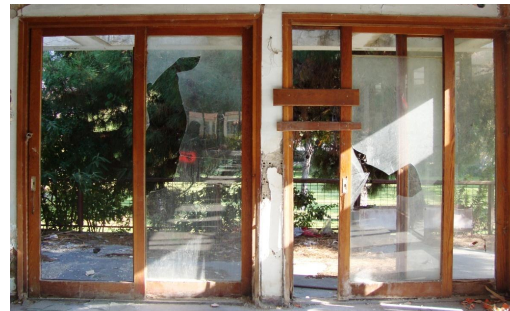
Εικόνα 133. Εξωτερικά κουφώματα κτιρίου 3.
