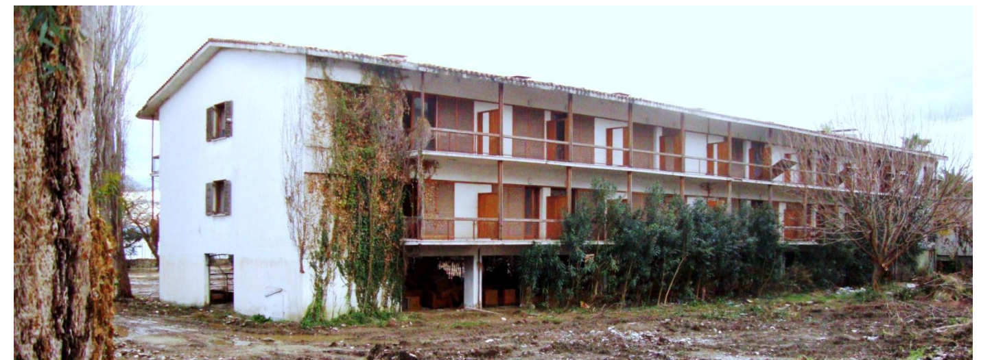
Εικόνα 90. Άποψη του κτιρίου 1, Βορινή όψη.
