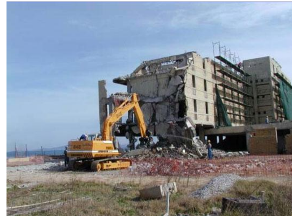
Εικόνα 52. Φωτογραφία από την στιγμή της κατεδάφισης.
