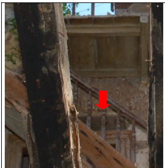
(εικ.33) Κενό μεταξύ κασώματος και πρεκιού στο άνοιγμα του τμήματος της προσθήκης
