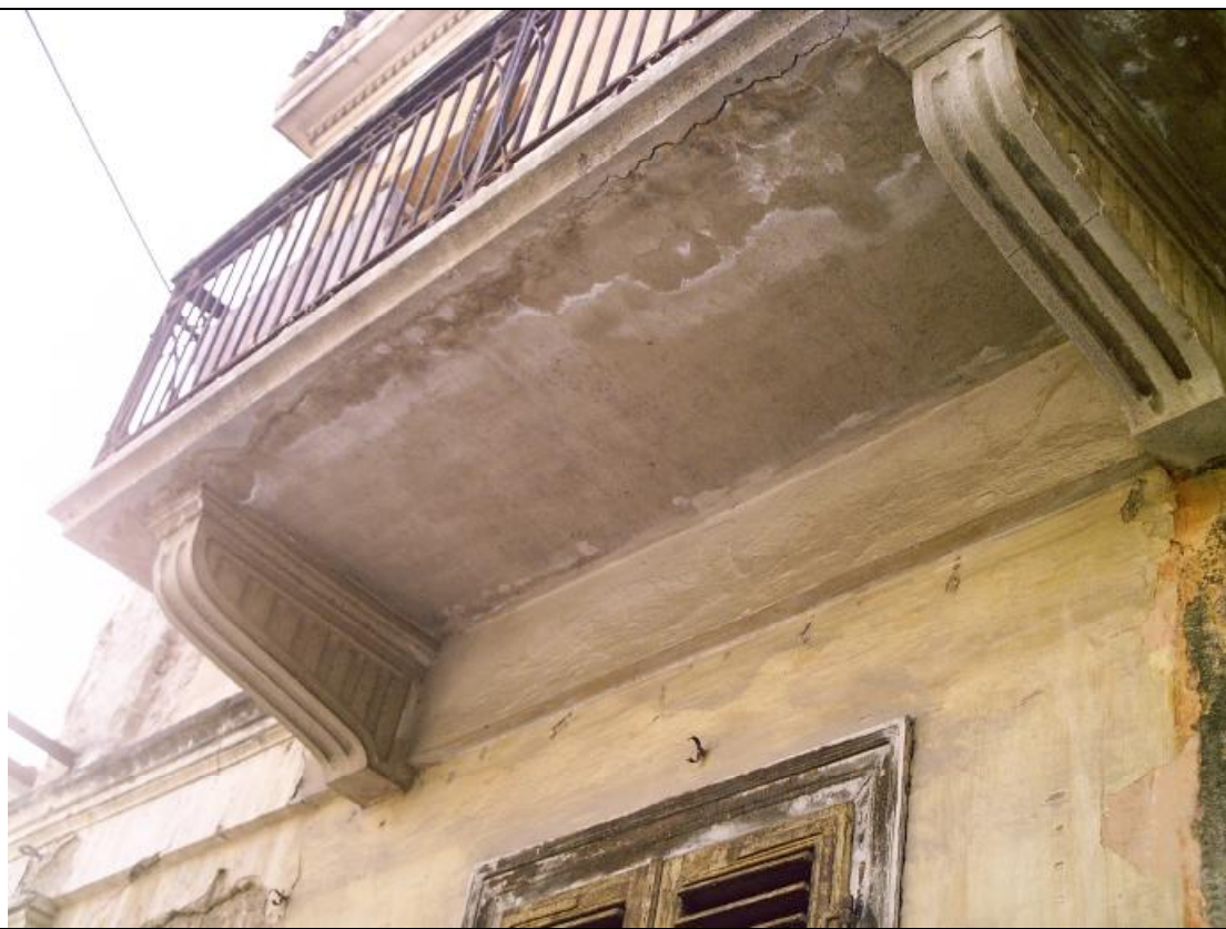
(εικ.58) Βλάβες στους εξώστες
