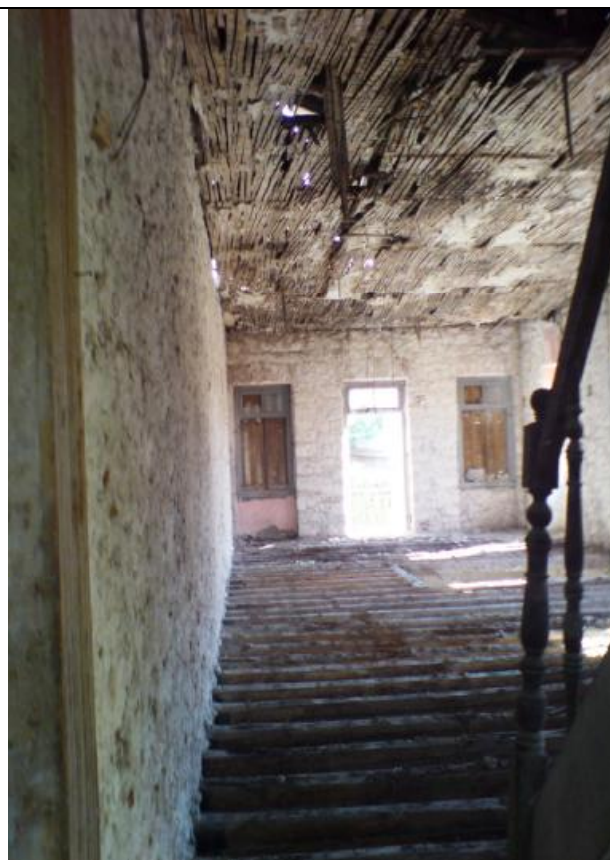
(εικ.59) Δάπεδο ισογείου και ορόφου
