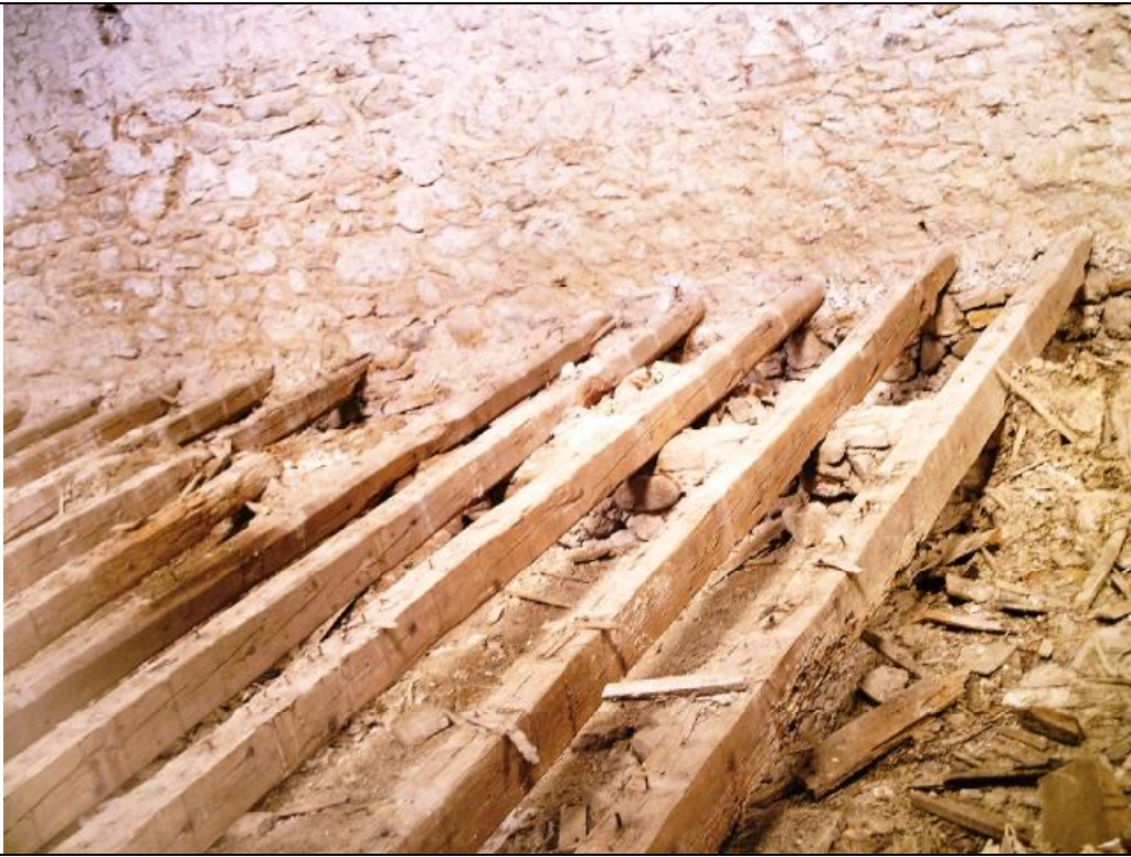
(εικ.21) Περιμετρικό πέτρινο θεμέλιο όπου εδράζονται οι ξύλινοι δοκοί
