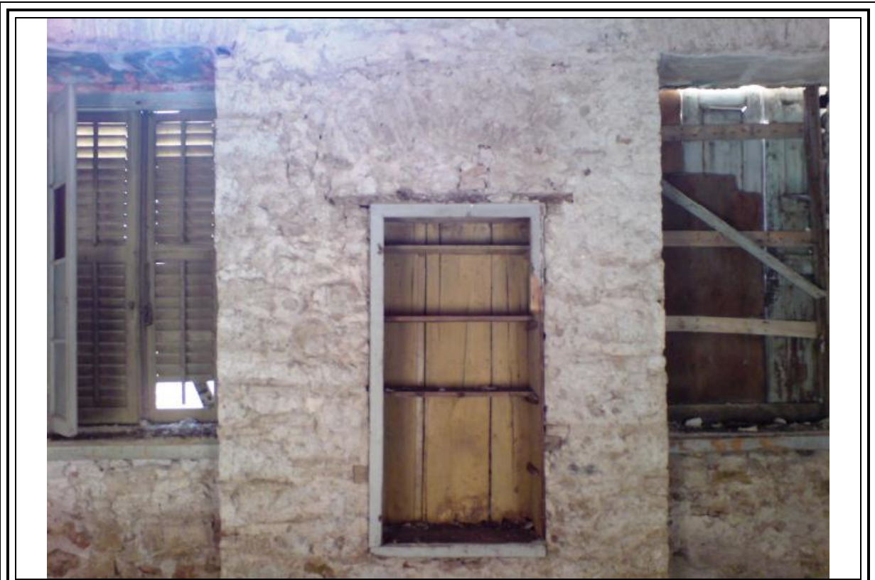
(εικ.14) Εσοχή στο ισόγειο του τοίχου 3 (T3)
