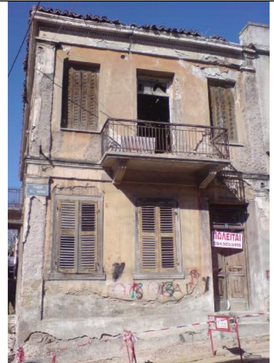
(εικ.9) Παράθυρα Γαλλικού τύπου στον όροφο με μαρμάρινη ποδιά, ανατολική όψη
