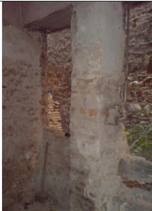
(εικ.24) Οριζόντιος και κατακόρυφος φέρον οργανισμός στο τμήμα της προσθήκης τοίχος 8 (T8)
