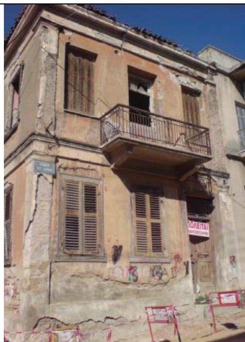
(εικ.2) Είσοδος του κτιρίου στην ανατολική όψη
