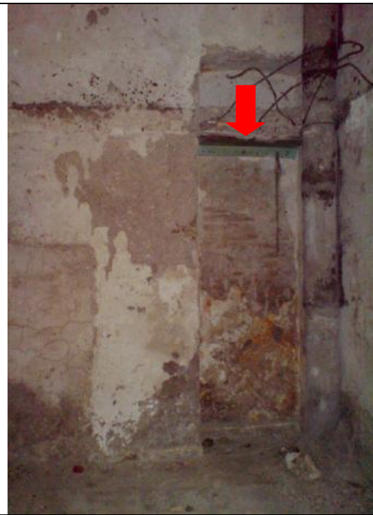
(εικ.20) Εσοχή στον τοίχο 5 (T5) στο ισόγειο
