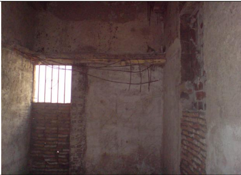
(εικ.51) Εσωτερικές όψεις στο τμήμα της προσθήκης στον όροφο
