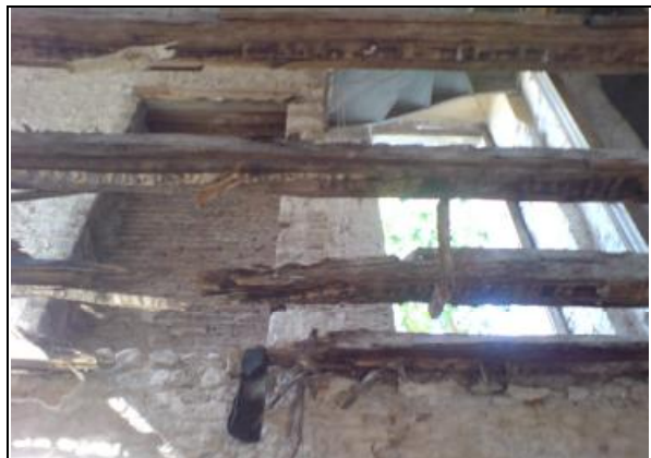
(εικ.16) Εσοχές σε ισόγειο και όροφο του τοίχου 4 (T4)
