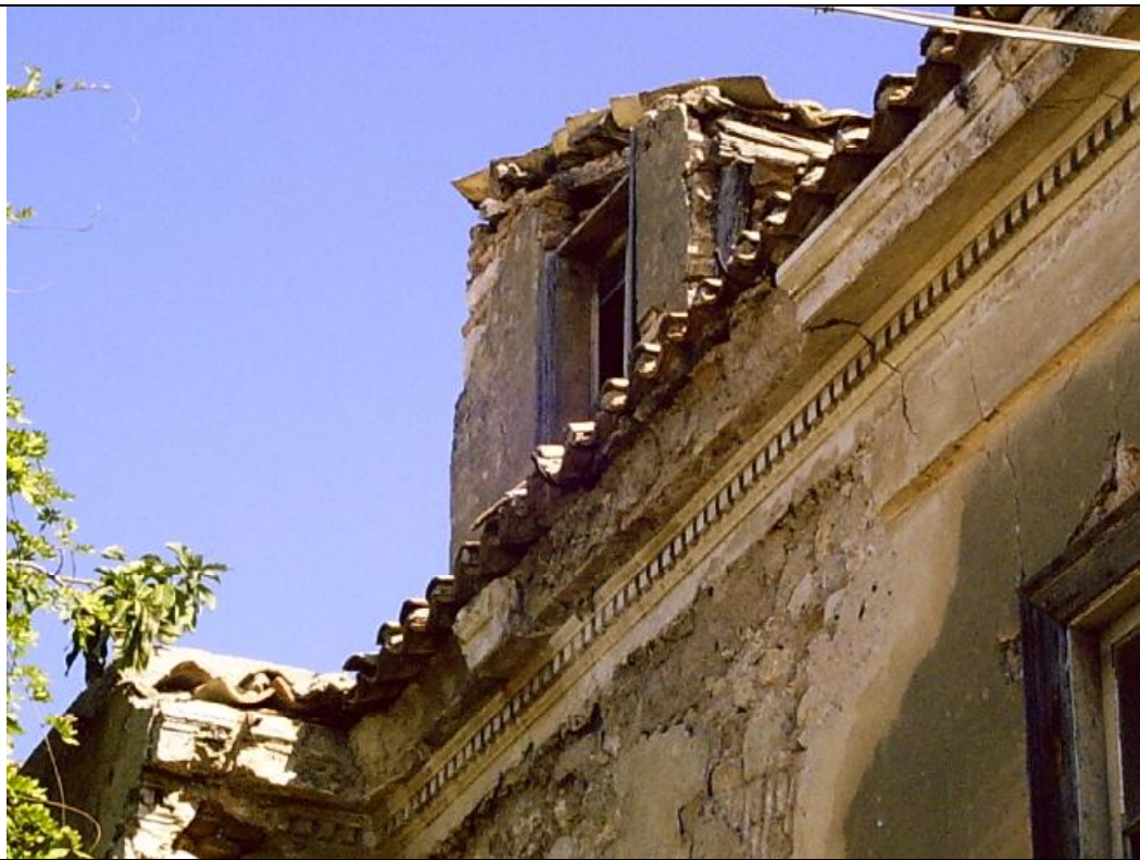
(εικ.12) Η μετώπη και το γείσο με τα διακοσμητικά δάκρυα συνεχίζει και στην δυτική όψη
