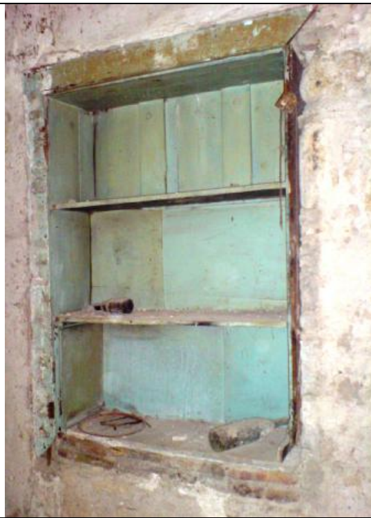
(εικ.19) Εσοχή στον τοίχο 6 (T6) στο ισόγειο
