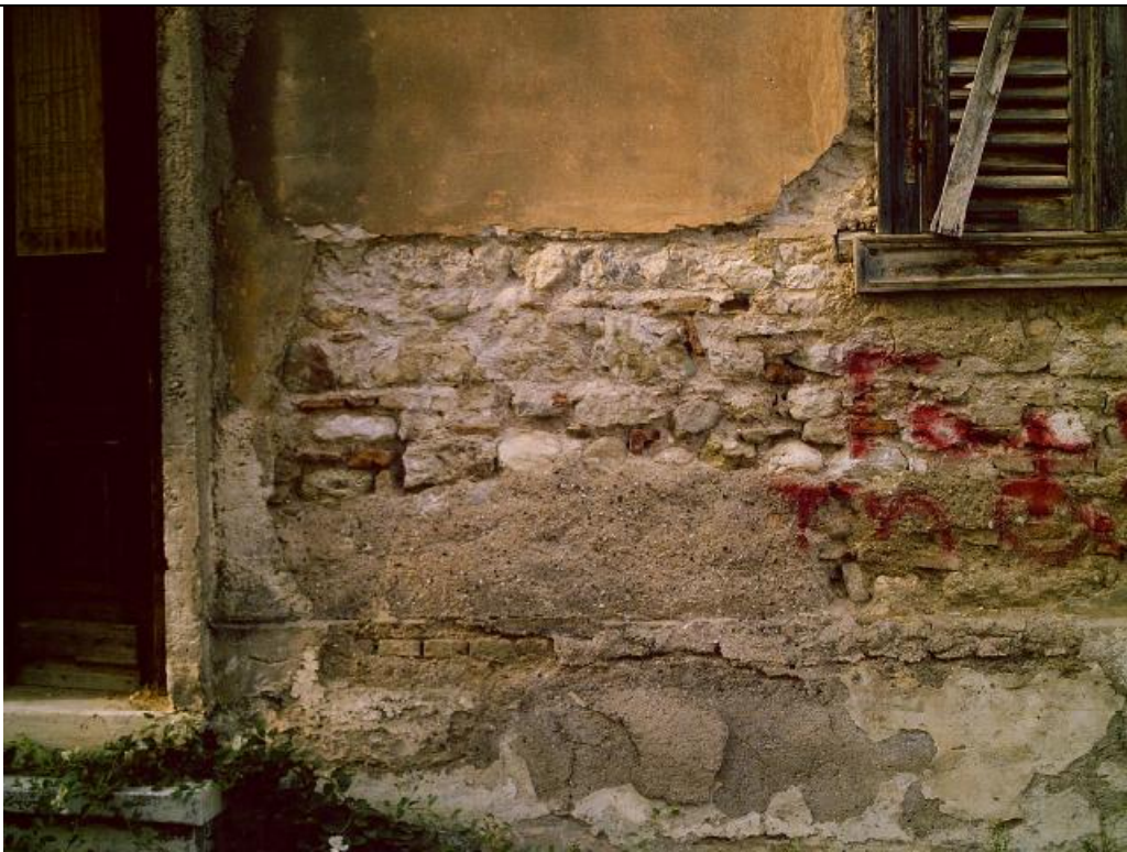
(εικ.22) Τοιχοποιία από ημιλαξευτούς λίθους, εφελκύστηκες ζώνες και συνδετικό κονίαμα
