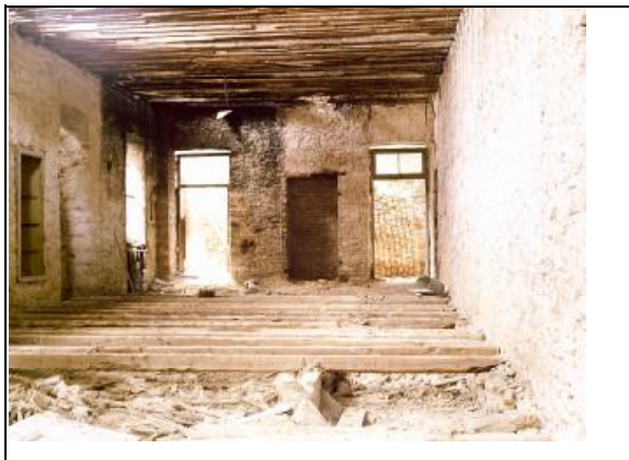
(εικ.16) Εσοχές σε ισόγειο και όροφο του τοίχου 4 (T4)
