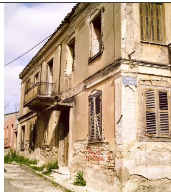
(εικ.3) Είσοδος του κτιρίου στη νότια όψη
