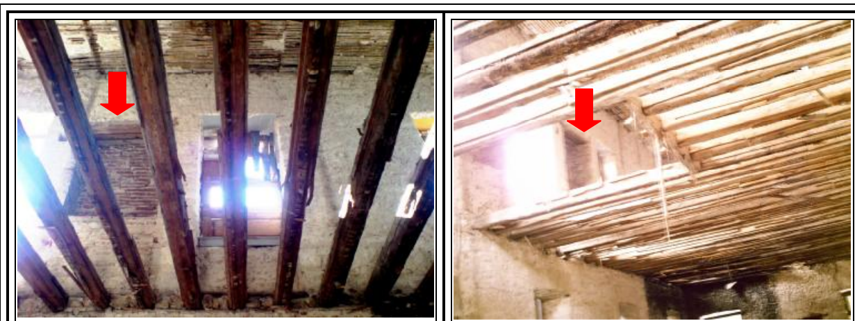
(εικ.15) Εσοχές σε ισόγειο και όροφο του τοίχου 3 (T3), εγκοπές στήριξης του πατώματος στην τοιχοποιία
