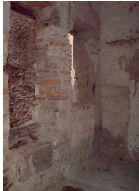
(εικ.24) Οριζόντιος και κατακόρυφος φέρον οργανισμός στο τμήμα της προσθήκης τοίχος 8 (T8)
