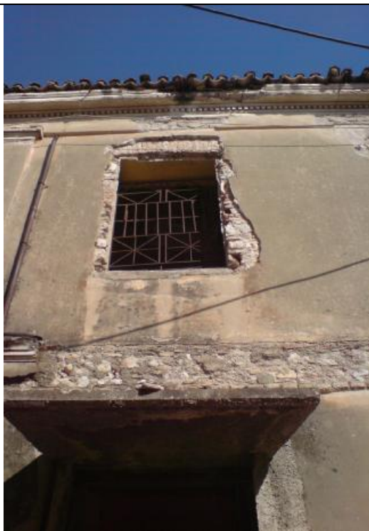
(εικ.31) Μεταλλικά κιγκλιδώματα σε ανοίγματα παραθύρων της νότιας όψης
