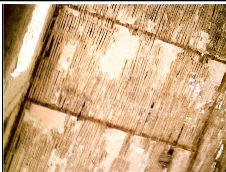
(εικ.57) Οροφή ορόφου
