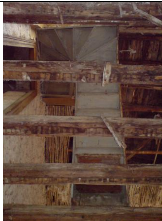
(εικ.13) Εσωτερική κλίμακα με πλατύσκαλο, που συνδέει τον όροφο με τη σοφίτα
