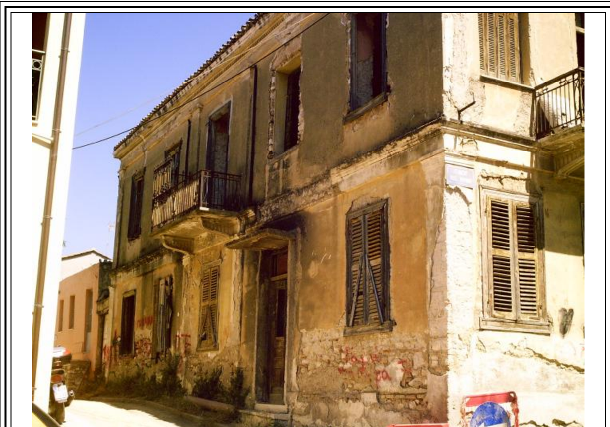
(εικ.10) Ψευδοκολώνες στις γωνίες του κτιρίου, διαχωρισμός ορόφων με μετόπη και γείσο νότια όψη
