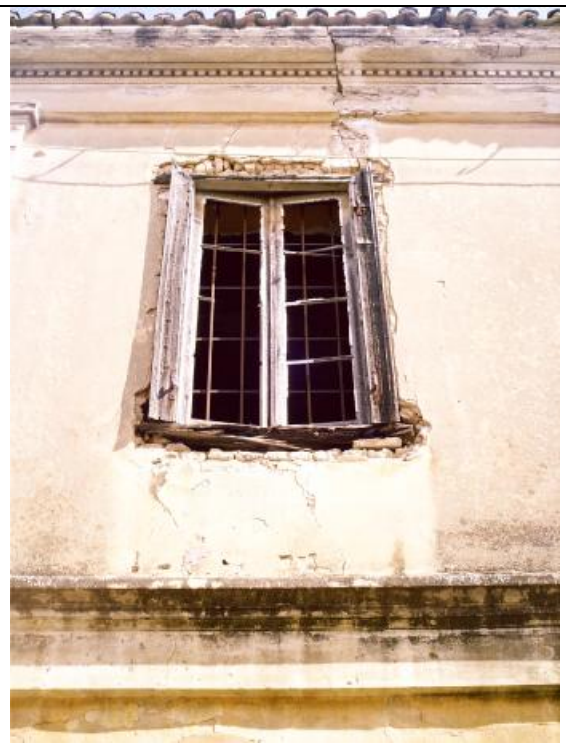
(εικ.31) Μεταλλικά κιγκλιδώματα σε ανοίγματα παραθύρων της νότιας όψης
