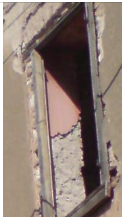
(εικ.48) Χρωματισμοί σε πρέκια παραθύρων στον όροφο στον τοίχο 2 και στον τοίχο 3
