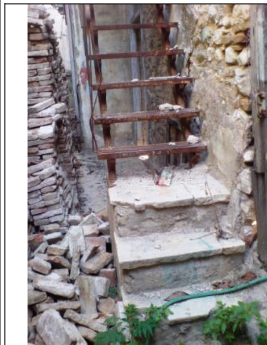
(εικ.1) Πέτρινες βαθμίδες βάση μεταλλικής κλίμακας στον στενό προαύλιο χώρο της δυτικής όψης
