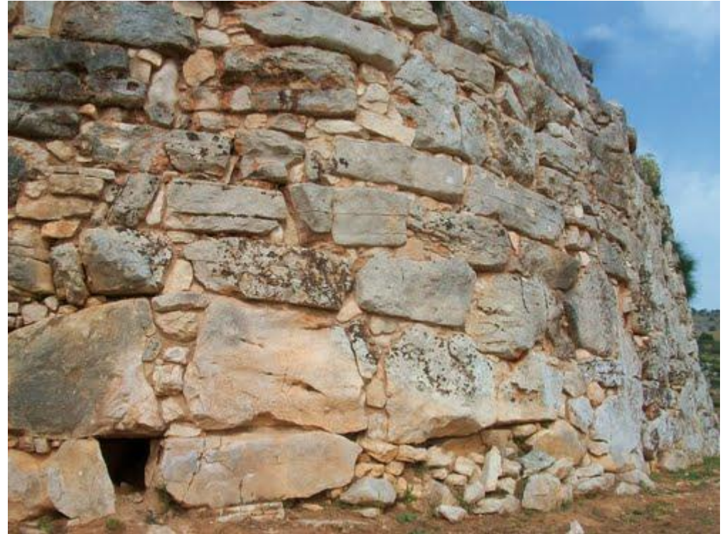
Εικόνα 18 η εν ξηρώ τεχνοτροπία
