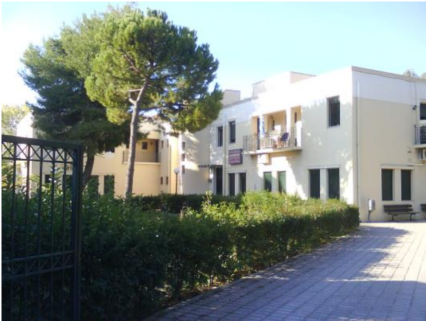
Εικόνα 71 το κτίριο Μέρμινα
