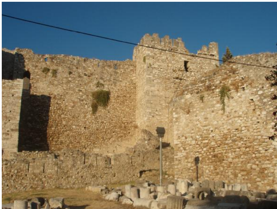
Εικόνα 3 πύργος με οδοντωτές επάλξεις
