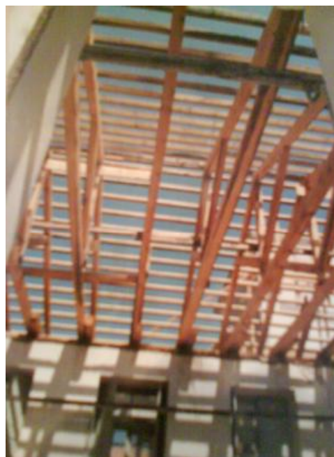
Εικόνα 76 η ξύλινη στέγη
