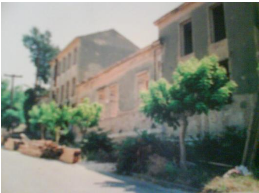
Εικόνα 75 η δυτική όψη
