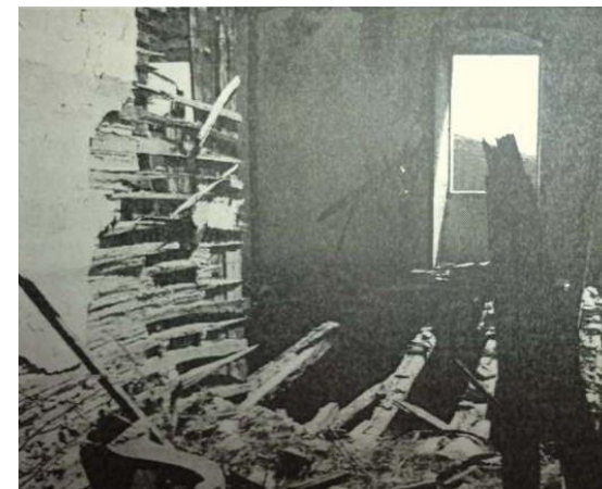
Εικόνα 53: Εσωτερικοί διαχωριστικοί τοίχοι
