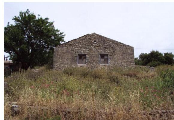
Εικόνα 35: κτίσμα με αμυντικά χαρακτηριστικά
