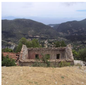
Εικόνα 17: Τοποθέτηση κτιρίου παράλληλα με τις υψομετρικές καμπύλες
