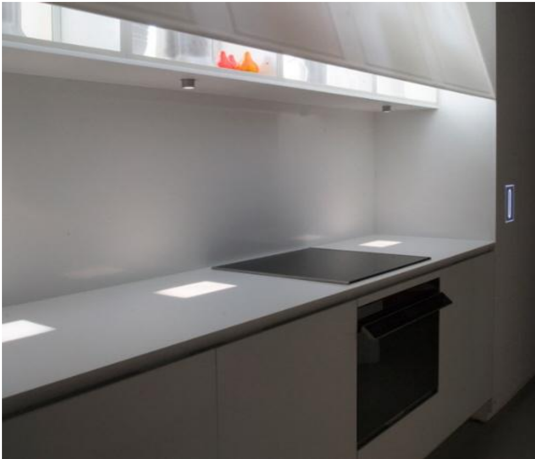
Εικόνα 61 : Κατασκευή ερμαρίων κουζίνας από CORIAN.
