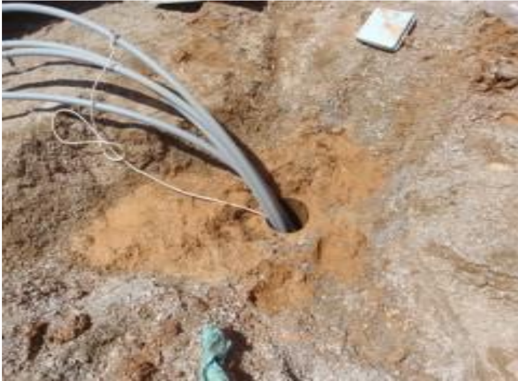
Εικόνα 88: Γεώτρηση για την τοποθέτηση σωληνώσεων
