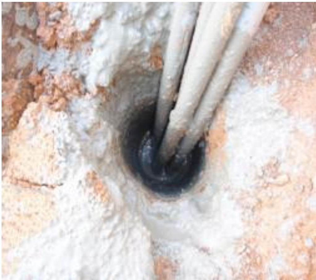
Εικόνα 89: Γεώτρηση για την τοποθέτηση σωληνώσεων
