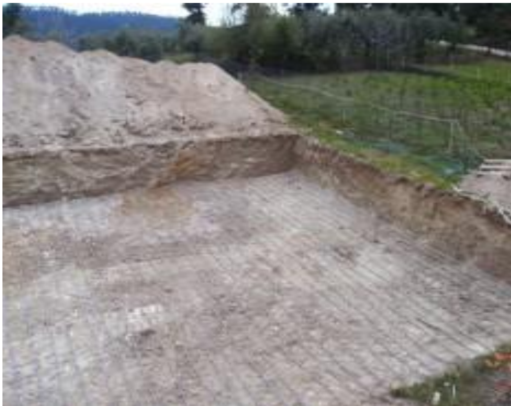
Εικόνα 87: Εκσκαφή για την τοποθέτηση γεωθερμίας
