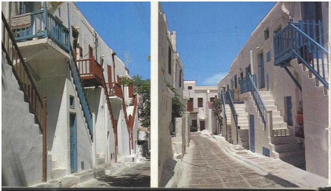
Εικόνα 145. Απόψεις μυκονιάτικων σπιτιών από το δρόμο
