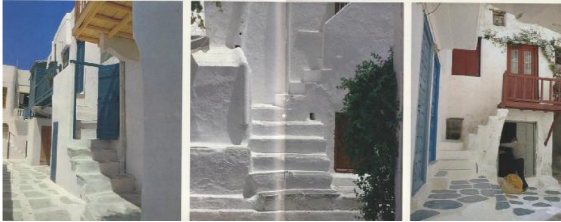
Εικόνα 144. Απόψεις μυκονιάτικων σπιτιών από το δρόμο
