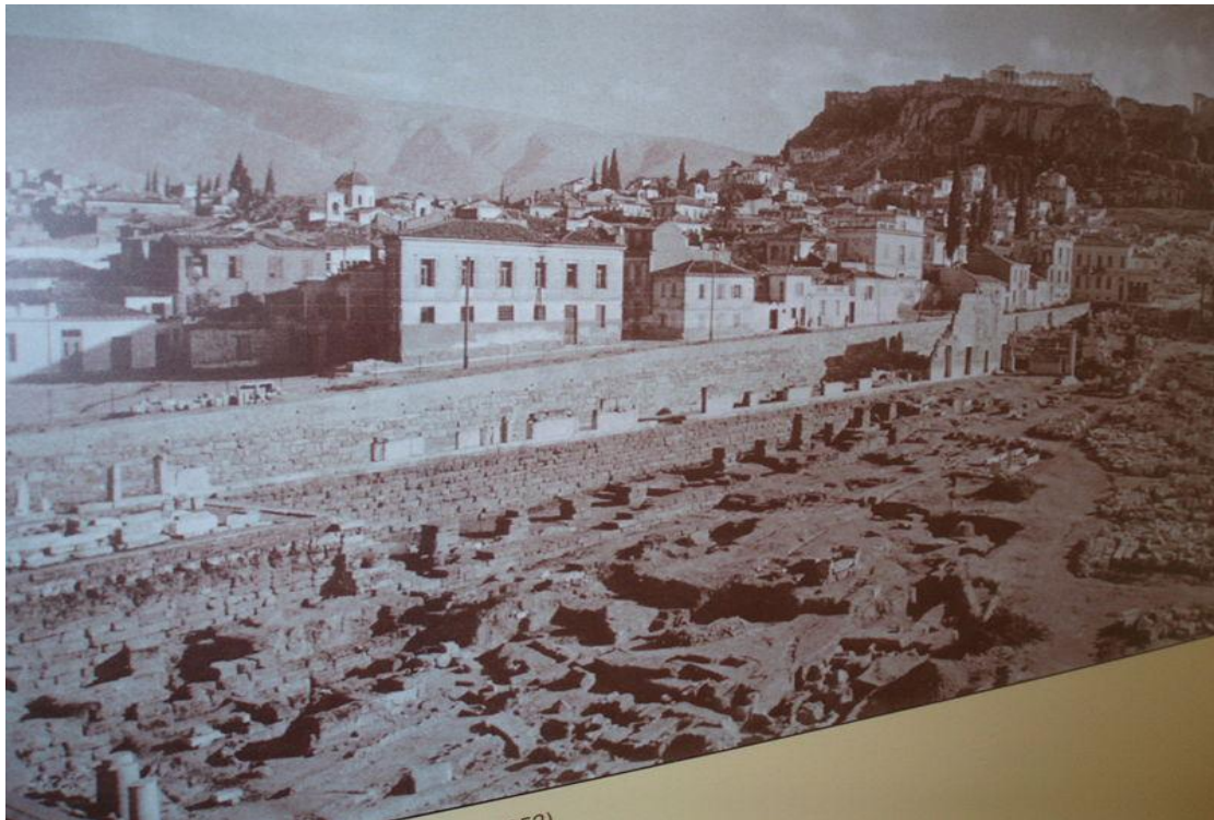
Εικόνα 85. Έναρξη εργασιών αναστήλωσης 1952. Στοά Αττάλου Β΄.
