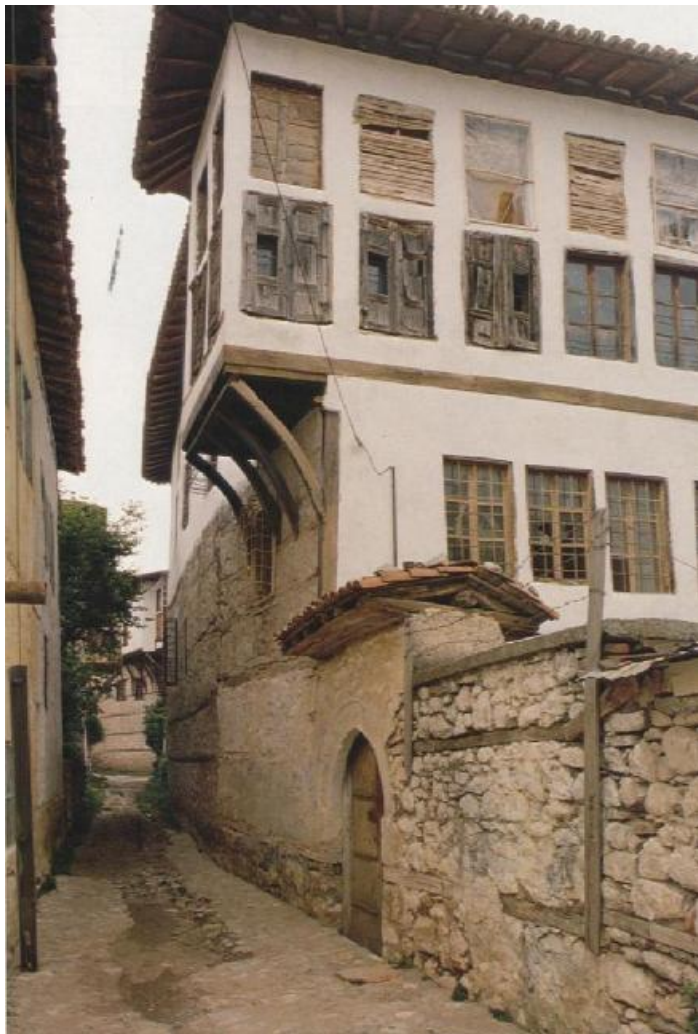
Εικόνα 123. Τυπικό καστοριανό σπίτι με σαχνισί
