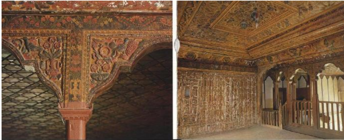
Εικόνα 130. α. Τρόπος σύνδεσης τόξων του υλικού β. Ξυλόγλυπτη διακόσμηση της μεσιάς
