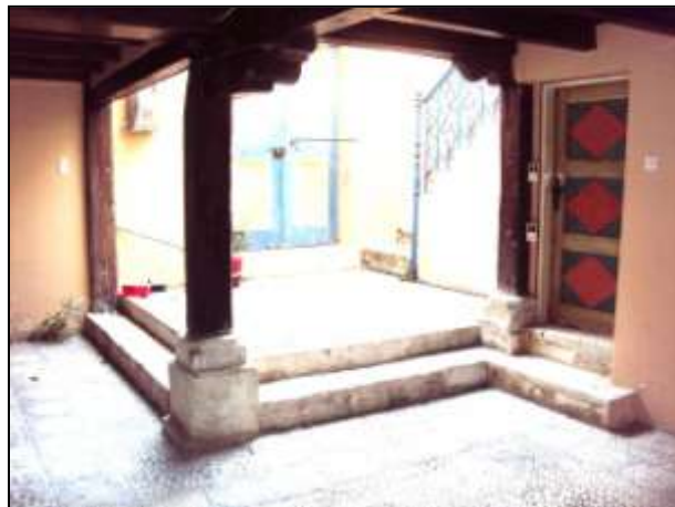
εικ.105 Ο χώρος πριν την είσοδο στο ισόγειο
