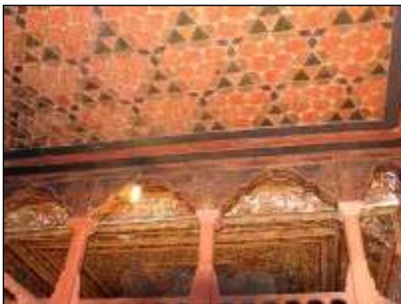
εικ.72 Τοξοστοιχίες που διαχωρίζουν το χώρο με εμφανή τη διαφοροποίηση των χώρων
