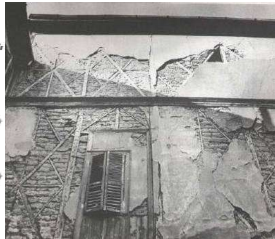
εικ.29 Τρόπος κατασκευής της λιθοδομής με εμφανή τα οριζόντια στοιχεία
