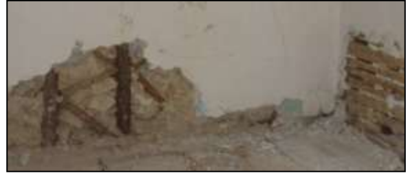
εικ.35-36 Λεπτομέρεια μαγδατότοιχου της παραπάνω οικίας πριν και μετά την αποκατάσταση
