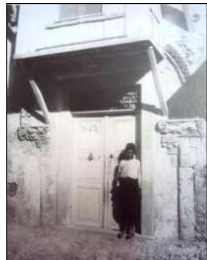
εικ.28 Αρχιτεκτονική παρέμβαση οθωμανικής κατασκευής σε ενετικό κτίσμα. Στην εικόνα διακρίνεται ο πρόβολος του ορόφου που κατασκευάστηκε πάνω σε λιθόκτιστο ενετικό κτίριο
