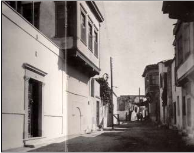
εικ.24 Άποψη δρόμου του Ηρακλείου στα τέλη του 19 ου αι. όπου διακρίνονται οι πρόβολοι των κατοικιών
