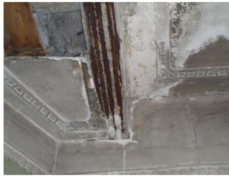
Εικόνα 52: Οξείδωση οπλισμού
