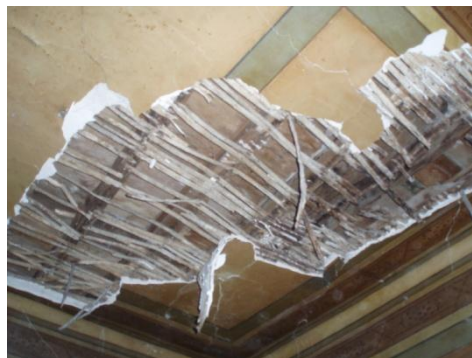
Εικόνα 39: Αποδιοργάνωση-διάβρωση οροφής
