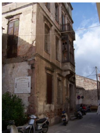
Εικόνα 73:Κατάρρευση επιχρίσματος
