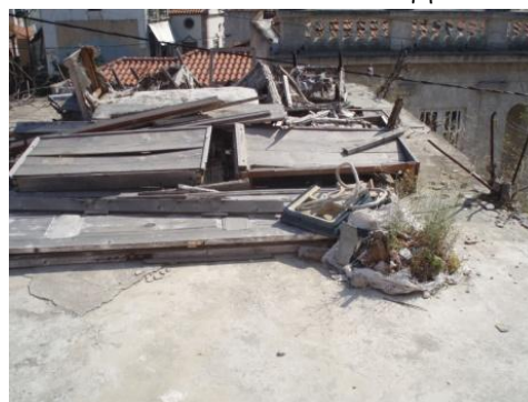
Εικόνα 34:Μικρορωγμές-ανάπτυξη μικροοργανισμών
