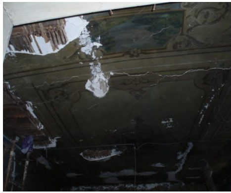
Εικόνα 76: Κατάρρευση επιχρίσματος
