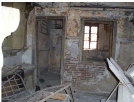
Εικόνα 82:Κατάρρευση επιχρίσματος
