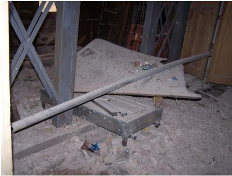
Εικόνα 35: Απομάκρυνση ξύλινου δαπέδου και σοβάτεπι
