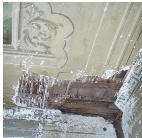
Εικόνα 45: Διάβρωση-αποδιοργάνωση οροφής
