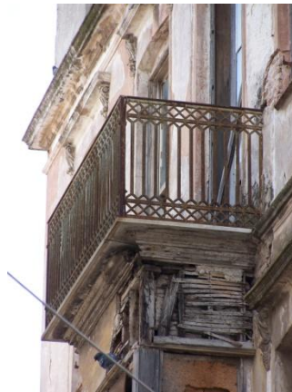
Εικόνα 91: Οξείδωση κιγκλιδώματος
