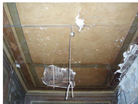
Εικόνα 38: Κατάρρευση επιχρίσματος
