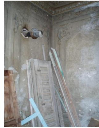
Εικόνα 78: Αλλοίωση χρωματισμού
