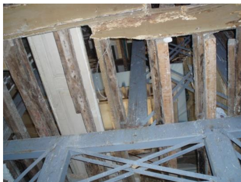
Εικόνα 37: Κατάρρευση οροφής
