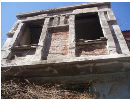
Εικόνα 24: Ανιούσα υγρασία
