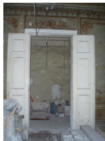
Εικόνα 65: Δίφυλλη πόρτα στο ισόγειο
