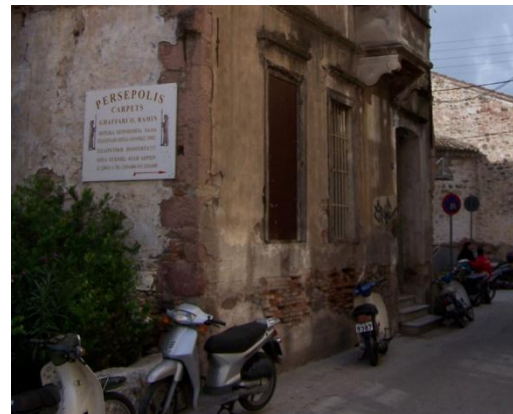
Εικόνα 58: Οξείδωση προστατευτικής σιδεριάς
