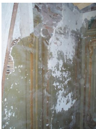
Εικόνα 8: Κατάρρευση επιχρίσματος
