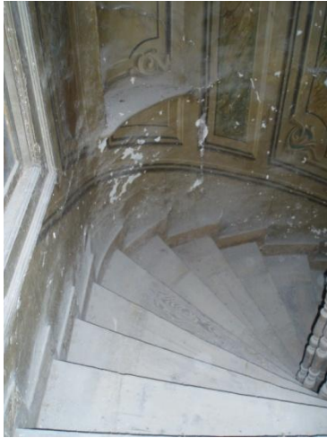
Εικόνα 85: Αλλοίωση χρώματος
