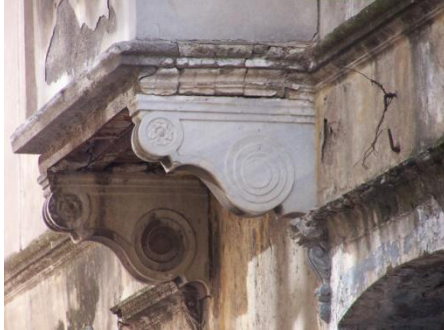
Εικόνα 89: Κατάρρευση γύψινης ταινίας
