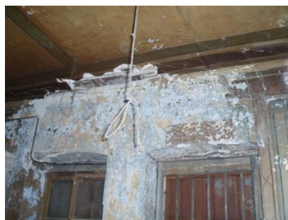
Εικόνα 6:Αλλοίωση επιχρίσματος
