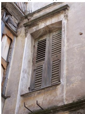
Εικόνα 59: Αποδιοργάνωση εξωφύλλου
