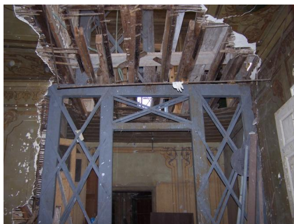
Εικόνα 21: Σιδεροκατασκευή στήριξης
