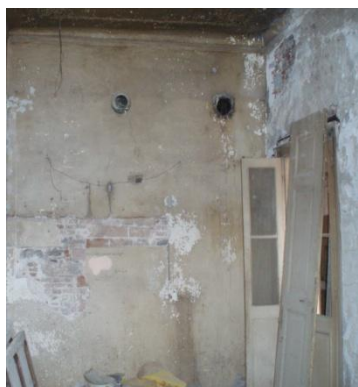
Εικόνα 10: Αποκόλληση επιχρίσματος
