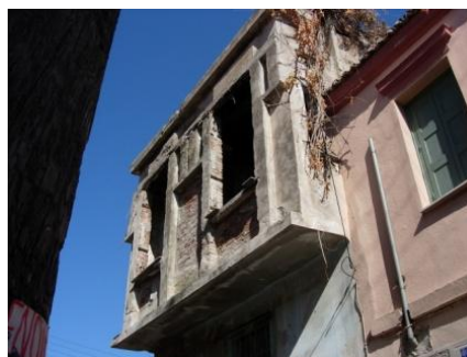
Εικόνα 22: Αλλοίωση-κατάρρευση Επιχρίσματος
