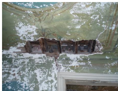
Εικόνα 16: Αλλοίωση επιχρίσματος
