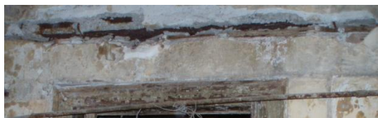
Εικόνα 28: Οξείδωση οπλισμού
