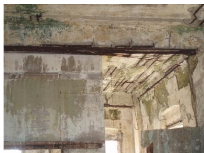
Εικόνα 29: Οξείδωση οπλισμού
