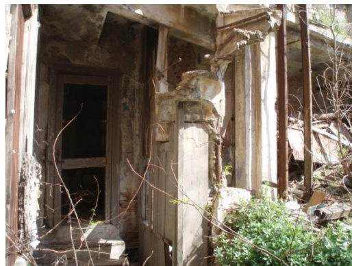
Εικόνα 68: Αποδιοργάνωση κεντρικής εισόδου
