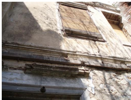
Εικόνα 2: Αλλοίωση επιχρίσματος
