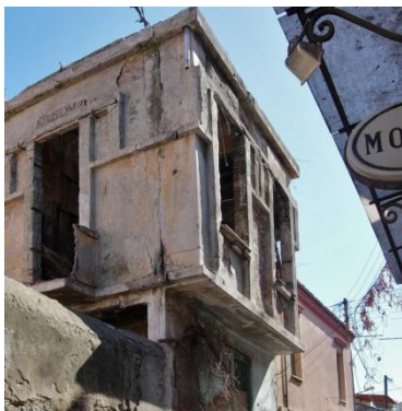
Εικόνα 80: Αλλοίωση χρωματισμού
