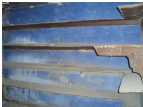
Εικόνα 19: Αλλοίωση επιχρίσματος
