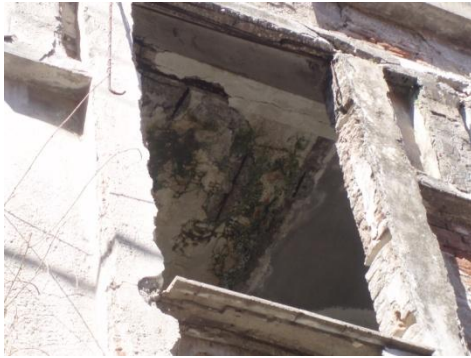
Εικόνα 57: Οξείδωση οπλισμού
