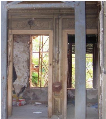
Εικόνα 53: Κατάρρευση-αλλοίωση επιχρίσματος
