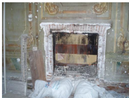
Εικόνα 83:Κατάρρευση εξωτερικού τμήματος
