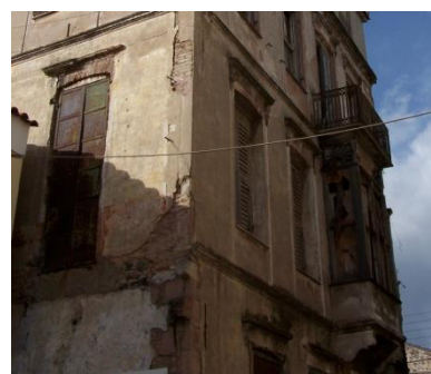
Εικόνα 61: Οξείδωση μπαλκονόπορτας
