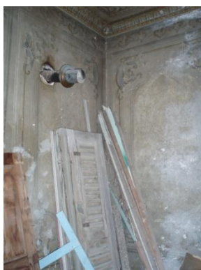
Εικόνα 11: Αλλοίωση επιχρίσματος
