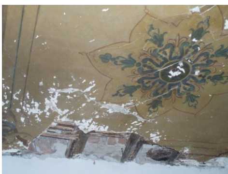
Εικόνα 43: Κατάρρευση οροφής
