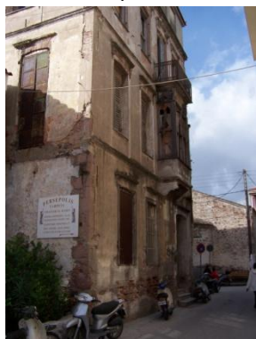
Εικόνα 1: Κατάρρευση επιχρίσματος
