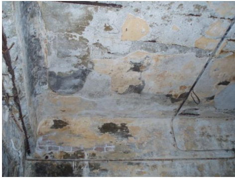
Εικόνα 51: Κατάρρευση-αλλοίωση επιχρίσματος
