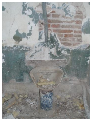
Εικόνα 14: Αποκόλληση επιχρίσματος
