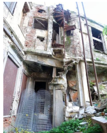
Εικόνα 88: Αποδιοργάνωση σκάλας
