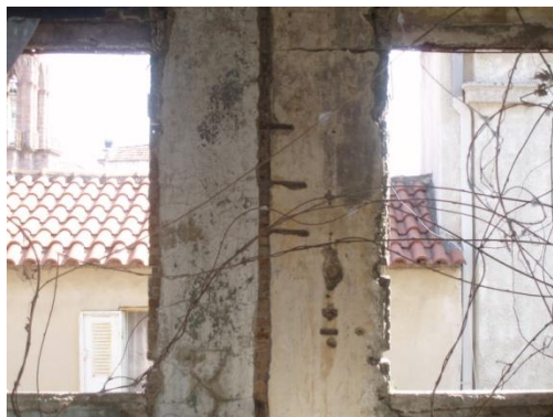
Εικόνα 32:Κατάρρευση-αλλοίωση επιχρίσματος
