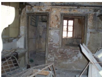
Εικόνα 25: Κατάρρευση-αλλοίωση επιχρίσματος
