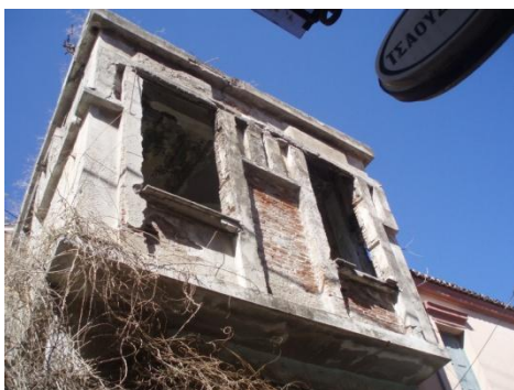
Εικόνα 55: Κατάρρευση-αλλοίωση επιχρίσματος
