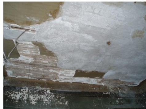
Εικόνα 44: Αλλοίωση επιχρίσματος
