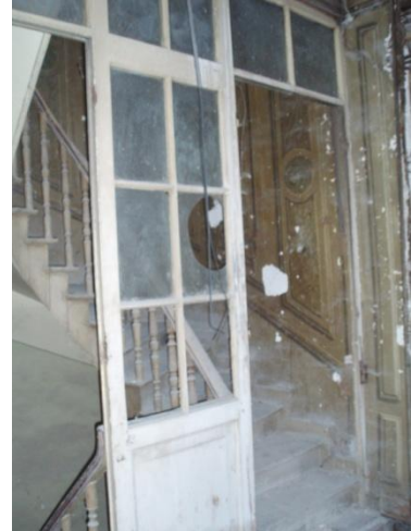
Εικόνα 87: Αποδιοργάνωση κουφωμάτων
