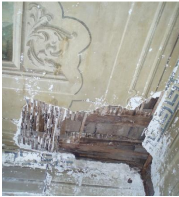
Εικόνα 76: Κατάρρευση επιχρίσματος
