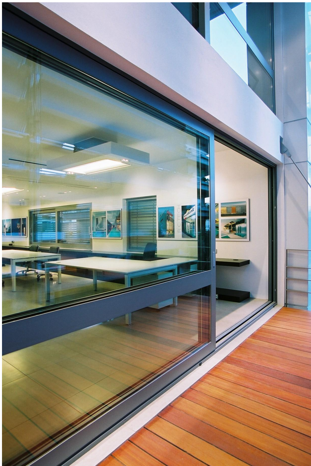
Ανοίγματα στην Νότια Όψη
