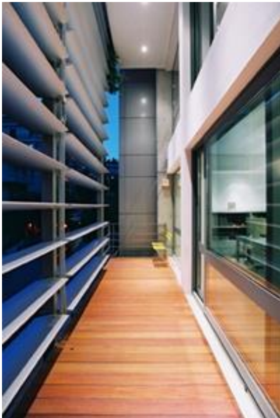
Το σύστημα περιστρεφόμενων περσίδων στην Δυτική Όψη
