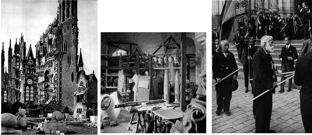
Εικ.89: Φωτογραφία του εργοταξίου
