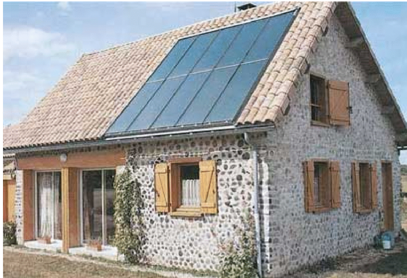
Εικ. 32 : Βιοκλιματική κατοικία στο Γύθειο
