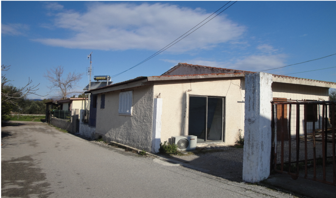
Εικ. 2 : Πρόχειρη κατασκευή
