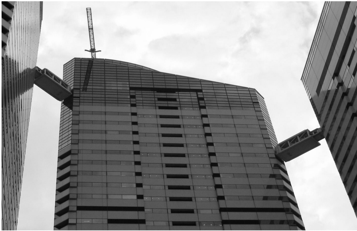
Σχήμα 5.20 Εξωτερική άποψη του τριπλού πύργου που συνδέεται με ενεργές γέφυρες.
