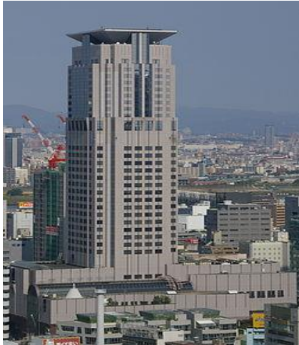
Σχήμα 5.43: Το κτήριο Hanku Chayamachi και το ελικοδρόμιο που χρησιμοποιείτε ως η μάζα του αποσβεστήρα AMD.
