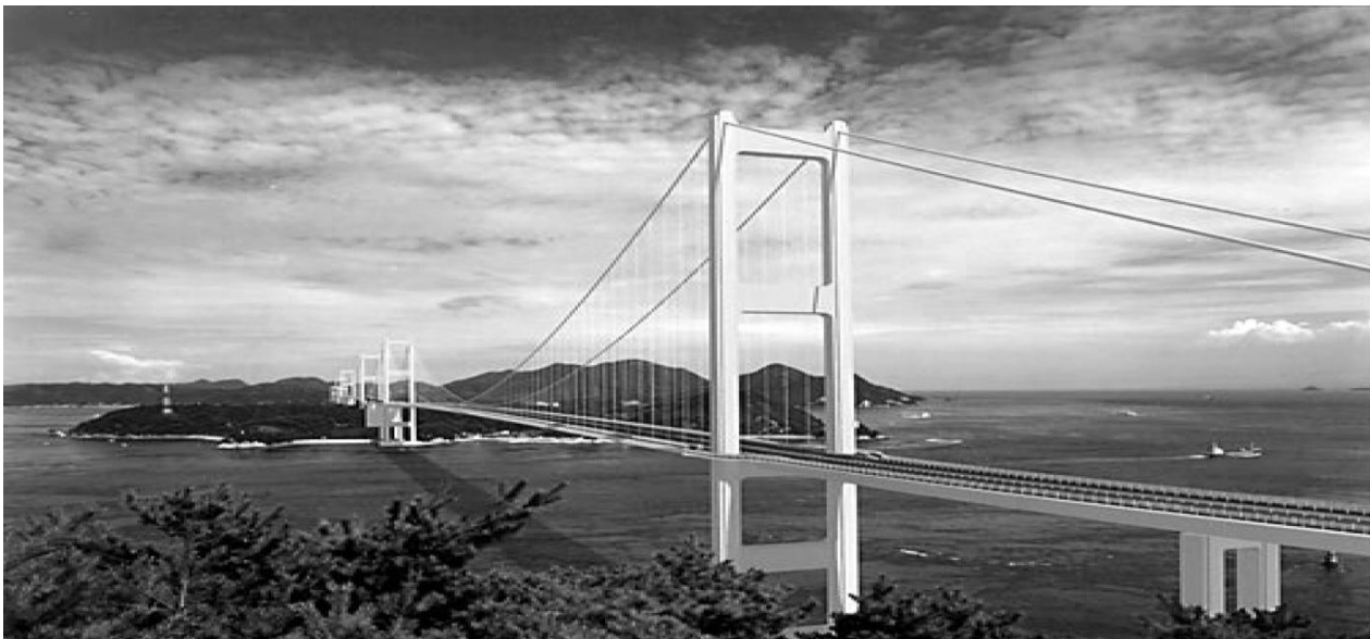
Σχήμα 5.36 Η γέφυρα Kurushima Kaikyo ολοκληρωμένη.
