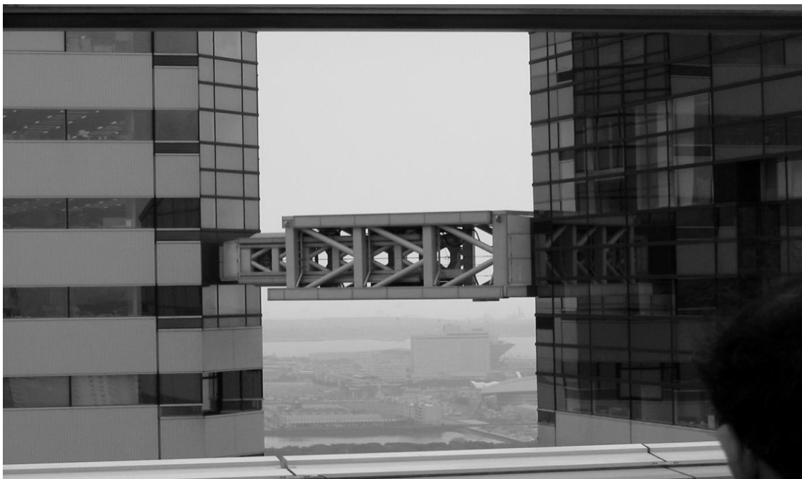
Σχήμα 5.19 Εξωτερική άποψη των ενεργά ελεγχόμενων γεφυρών που συνδέουν τους πύργους X και Y.
