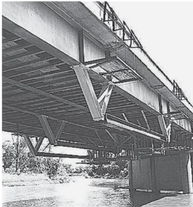
Σχήμα 3.13 Αυτοκινητόδρομος I – 35 με ημιενεργούς αποσβεστήρες.
