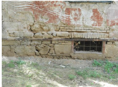
Εικ.20 Περίδεση κτιρίου.
