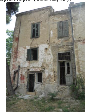
Εικ.42 Εξωτερικά επιχρίσματα
