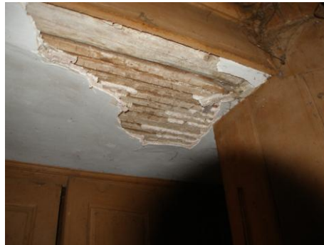
Εικ.32 Οροφή ισογείου από μπαγδατί.
