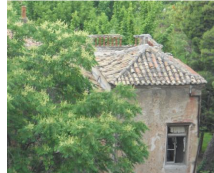
Εικ.21 Δώμα και στέγη βίλλας.
