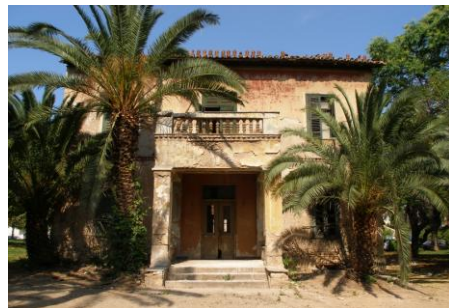
Εικ.1 Πρόσωση κτιρίου – Κύρια είσοδος από την οδό Πατησίων
