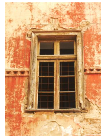
Εικ.52 Παράθυρο κλιμακοστασίου.
