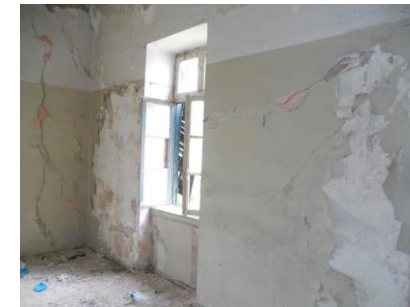
Εικ.69 Αποκόλληση επιχρίσματος.
