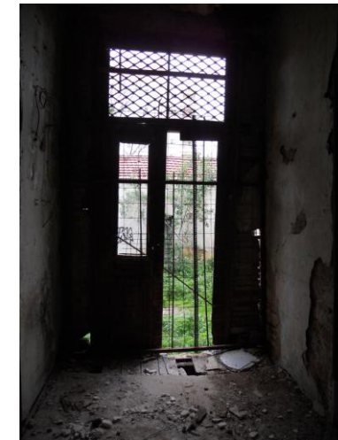
Εικ.18 Επέκταση ισόγειου (I5).
