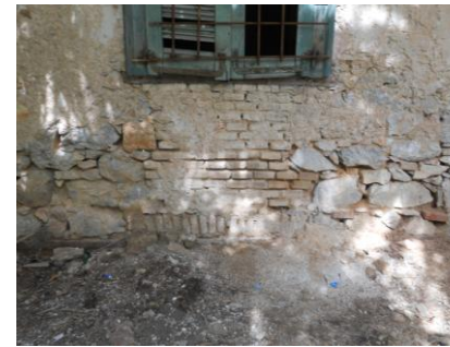
Εικ.28 Εξωτερική λιθοδομή.
