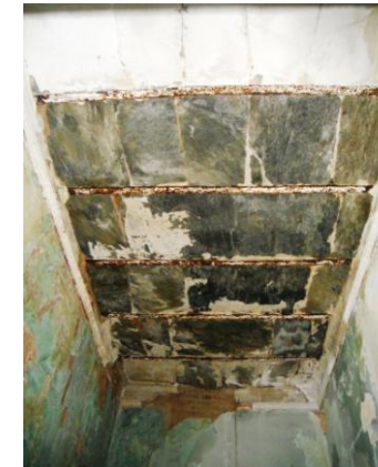
Εικ.40 Πάτωμα επέκτασης ορόφου A5.
