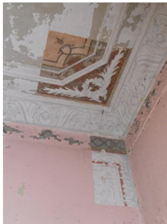
Εικ.34 Οροφή ισογείου με οροφωγραφία.
