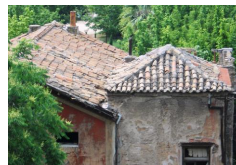
Εικ.30 Στέγη κτιρίου και τετράριχτη στέγη β' επέκτασης.
