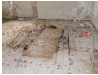
Εικ.90 Τοπική αποδιοργάνωση ξύλινων δοκών.
