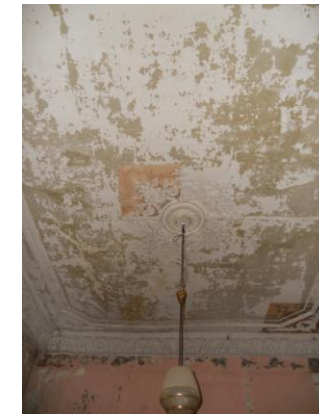
Εικ.87 Αποκόλληση επιχρίσματος.
