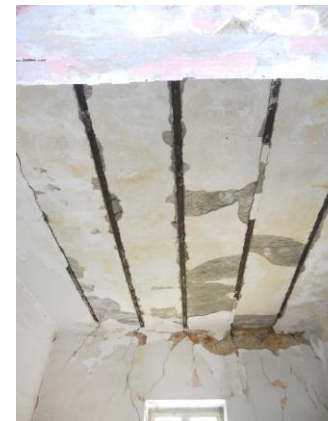
Εικ.39 Πάτωμα δώματος α' επέκτασης.
