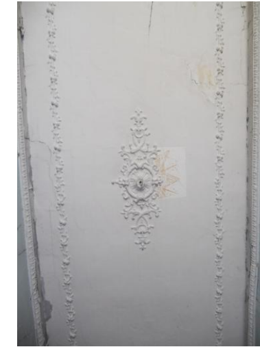
Εικ.61 Οροφή διαδρόμου ορόφου, με επικάλυψη οροφωγραφίας από γύψινο πλαστικό διάκοσμο.
