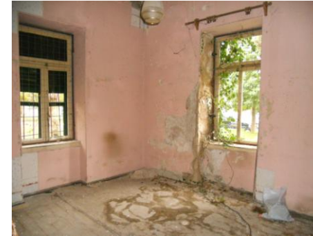
Εικ.16 Επέκταση ισόγειου (I4).
