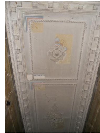
Εικ.60 Οροφή διαδρόμου ισόγειου.
