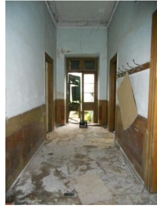
Εικ.13 Διάδρομος ορόφου (A1).
