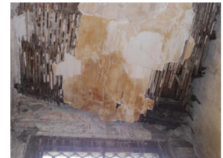
Εικ.88 Μερική αποκόλληση οροφής.
