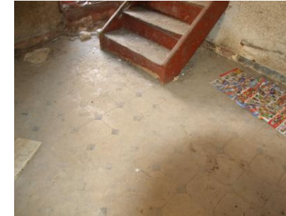
Εικ.37 Δάπεδο κουζίνας από χειροποίητες τσιμεντένιες πλάκες.
