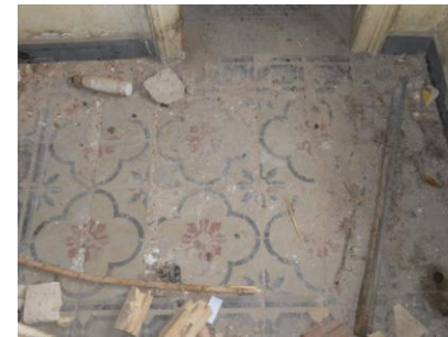
Εικ.36 Δάπεδο χώρων υγιεινής ημιορόφου.
