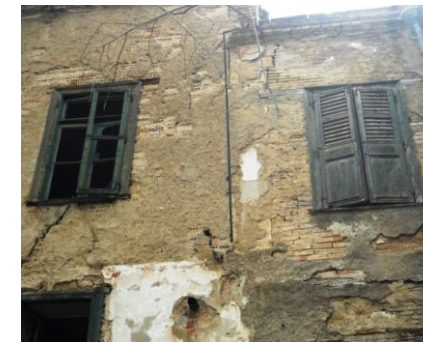
Εικ.29 Οπτοπλινθοδομές με πλήρεις οπτόπλινθους δεξιά και με διάτρητους αριστερά.
