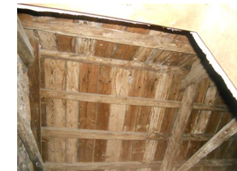
Εικ.31 Εσωτερική άποψη στέγης.
