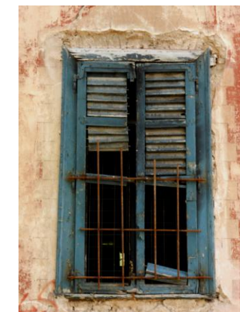
Εικ.53 Παράθυρο με γερμανικού τύπου εξώφυλλο.
