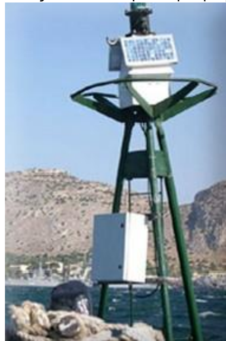
Εικόνα 6 Πιλοτική Εγκατάσταση Προγράμματος Διογένης
