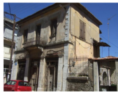
Οικία επί της οδού Ερυθρού Σταυρού
