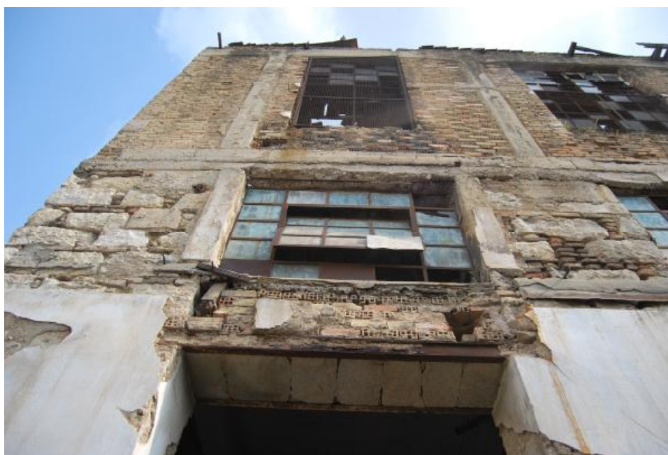
Εικ. 19: Ανοίγματα στη νότια πλευρά.
