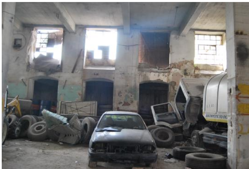
Εικ. 14: Βιοτεχνικός χώρος, νότια τοιχοποιία.
