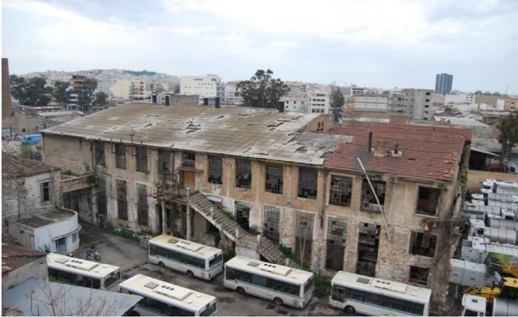
Εικ. 8: Η κάλυψη της βιοτεχνίας γίνεται με δυο ειδών στέγης. Με οπλισμένο σκυρόδεμα μπροστά και 5 ξύλινες στέγες με κεραμίδια γαλλικού τύπου αριστερά
