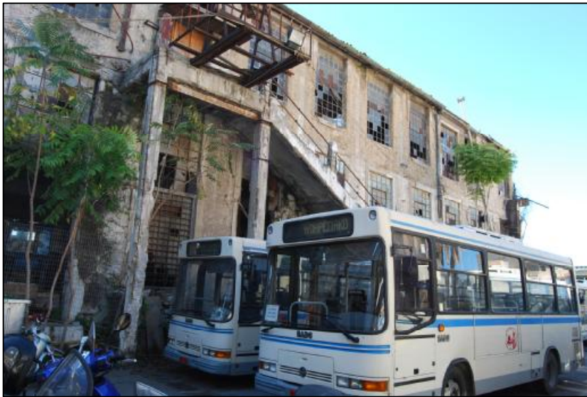
Εικ. 6: Η κατακόρυφη επικοινωνία επιτυγχάνεται με εξωτερική σκάλα που συνδέει τον όροφο με το ισόγειο.
