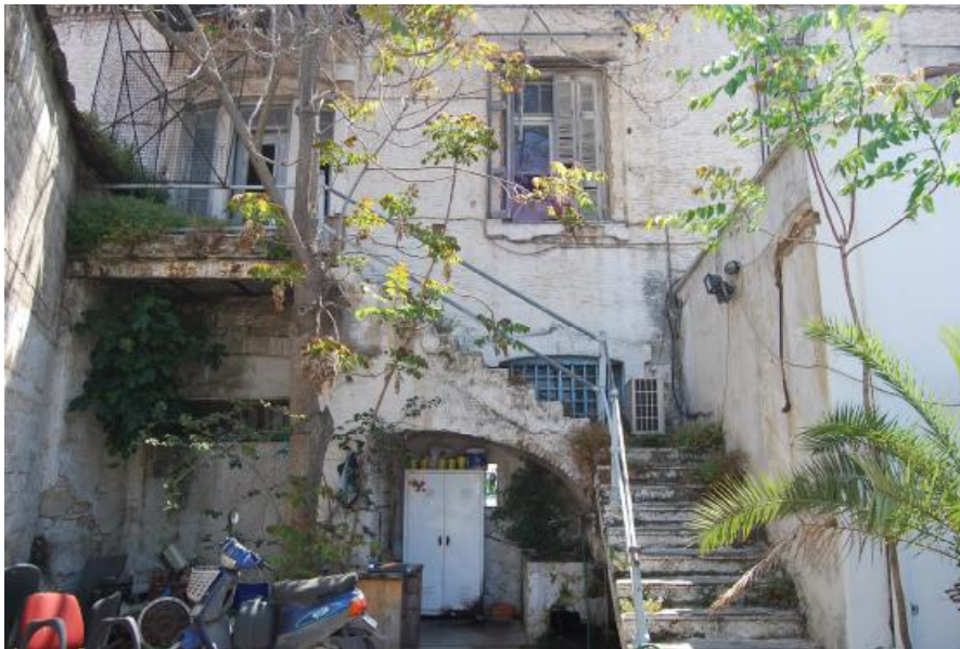
Εικ. 11: Εξωτερικό κλιμακοστάσιο στη δυτική όψη του κτιρίου των γραφείων.
