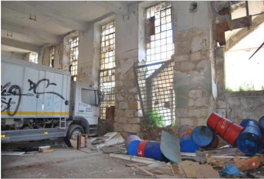
Εικ. 13: Βιοτεχνικός χώρος, βόρεια τοιχοποιία.
