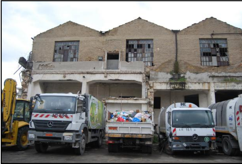
Εικ. 5: Η δυτική όψη μετά την κατεδάφιση κτισμάτων.
