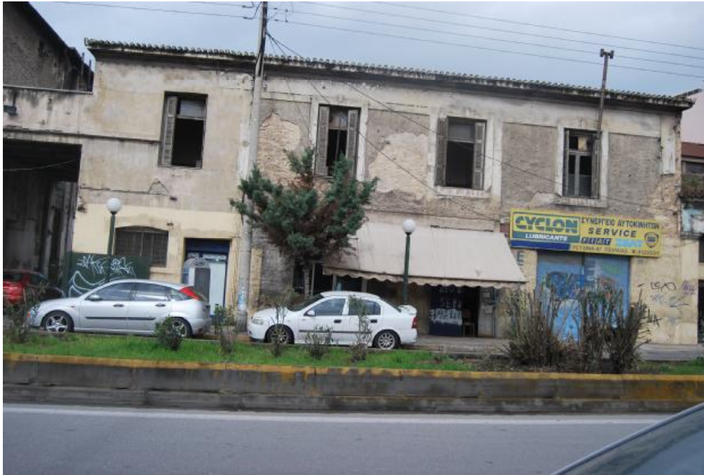
Εικ. 21: Κτίριο των γραφείων. Ανατολική όψη.
