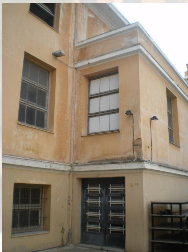
Εικόνα 72 Αποχρωματισμός.
