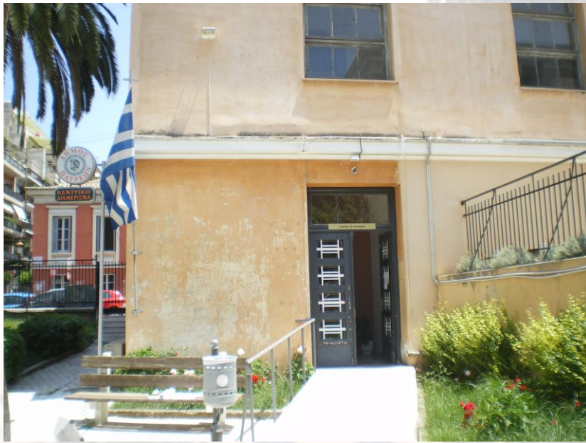
Εικόνα 14 Υπόγειο τμήμα που στεγάζει τον Δήμο Πατρέων.
