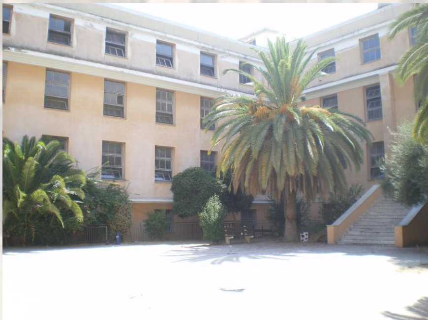
Εικόνα 25 Προαύλιο χώρος του κτιρίου .
