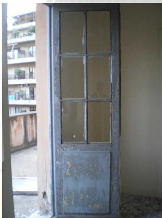
Εικόνα 67 Αποφλοίωση και αποχρωματισμός.
