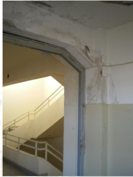
Εικόνα 63 Υγρασία στο υποστύλωμα.
