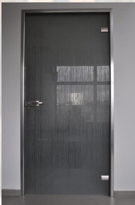
Εικόνα 82 Πόρτες με αμμοβολή και μεταλλικό πλαίσιο inox.
