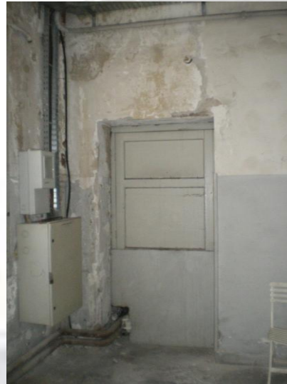
Εικόνα 59 Υγρασία σε αίθουσα υπογείου.
