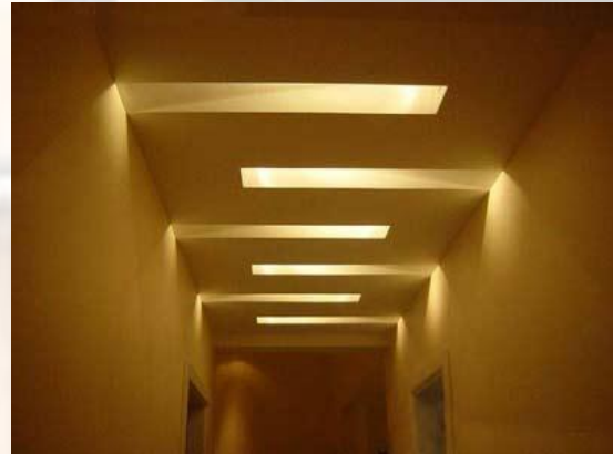
Εικόνα 86 Εσωτερικός φωτισμός οροφής με γυψοσανίδα.
