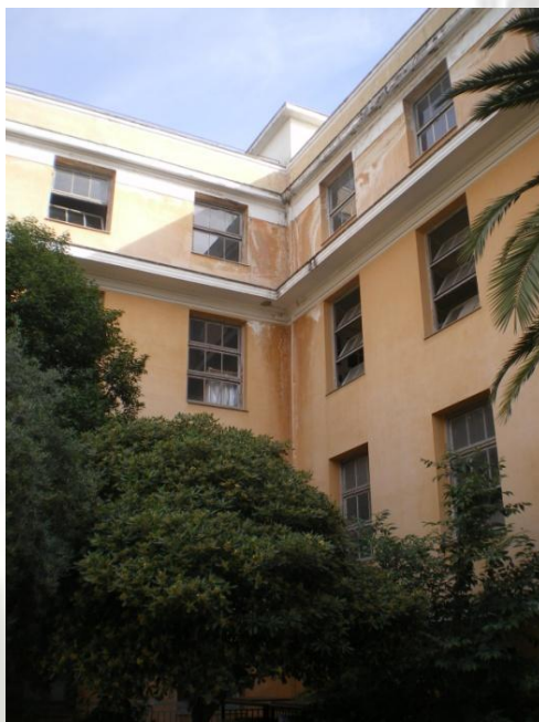
Εικόνα 36 Κουφώματα ξύλινα ορθογωνίου σχήματος .
