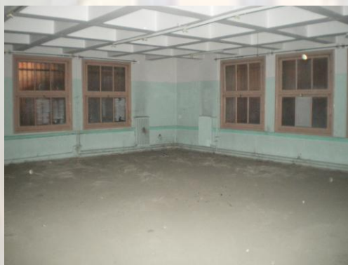
Εικόνα 27 Πλάκα τύπου Τσέλνερ (υπόγειο).
