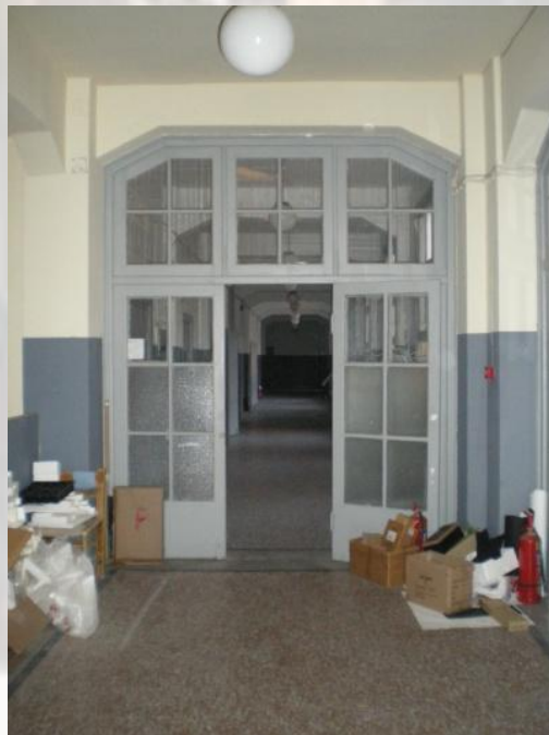
Εικόνα 40 Τρίφυλλη ανοιγόμενη πόρτα στον χώρο του διαδρόμου, ξύλινη με υαλοπίνακες .
