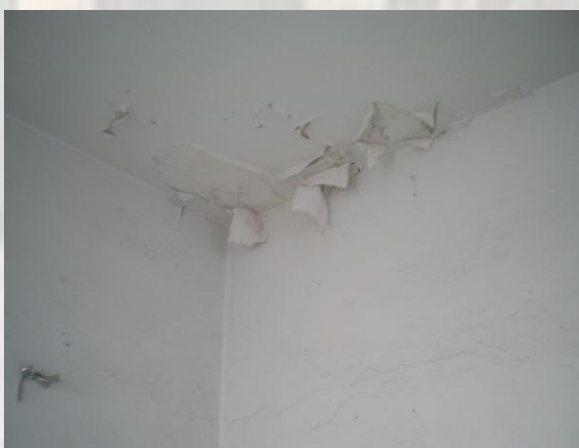
Εικόνα 57 Αποφλοιώση χρώματος
