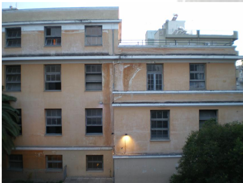
Εικόνα 75 Αποχρωματισμός.
