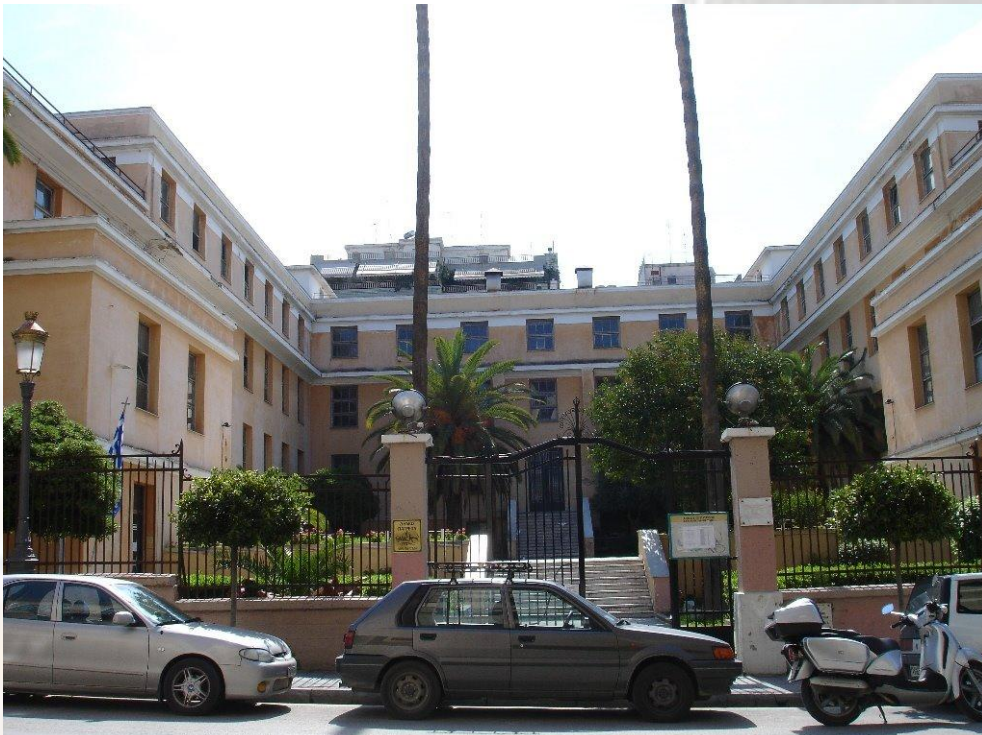
Εικόνα 76 Υπάρχων πρόσοψη κτιρίου επί την οδό Μαιζώνος.
