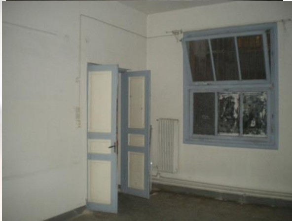
Εικόνα 38 (Αριστερά) Εσωτερική πόρτα ξύλινη ταπλαδωτή.
