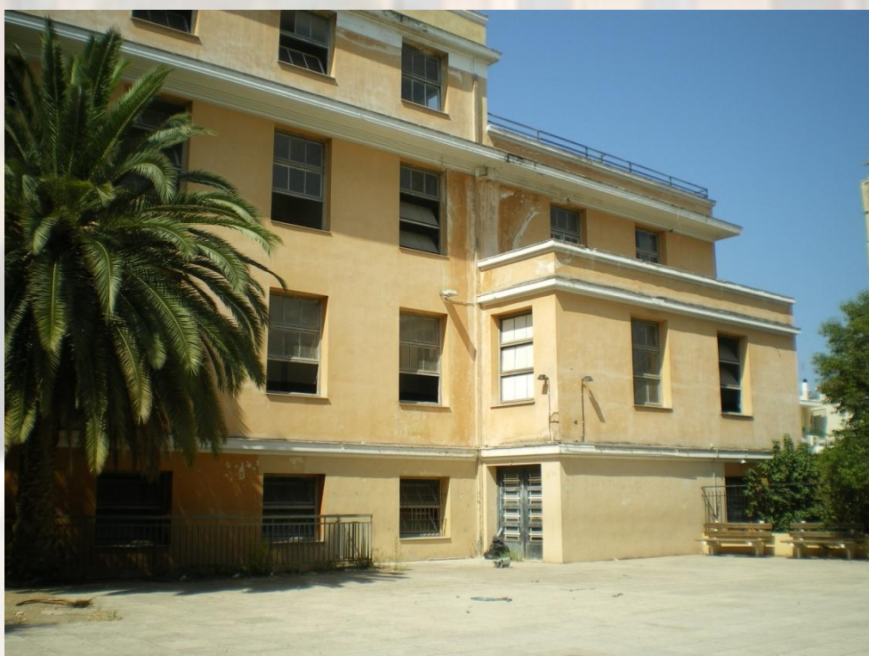
Εικόνα 70 Αποχρωματισμός.
