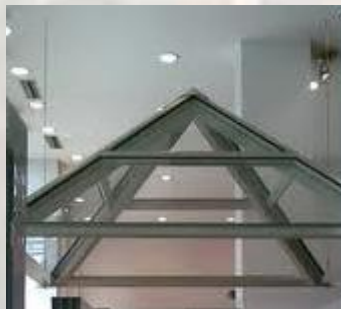
Εικόνα 104 Αίθριο σε σχήμα πυραμίδας που καταλήγει στο δώμα.
