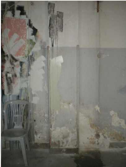
Εικόνα 58 Υγρασία σε αίθουσα υπογείου.
