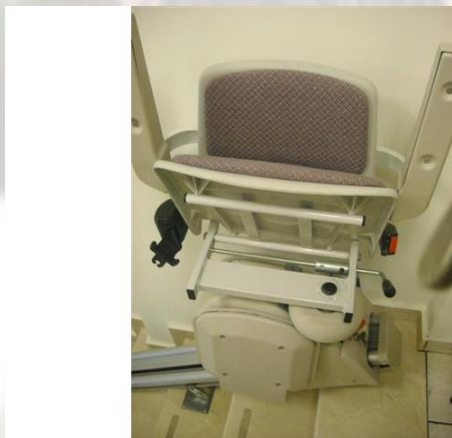
Εικόνα 84 Ειδικός ηλεκτρικός μηχανισμός καρεκλάκι για ΑΜΕΑ (ΠΑΡΑΔΕΙΓΜΑ 1).
