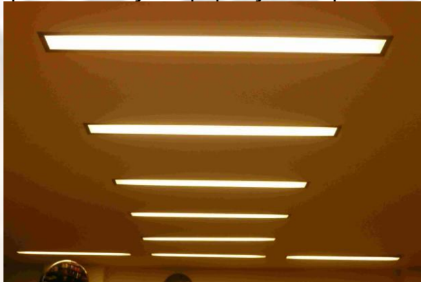
Εικόνα 86 Εσωτερικός φωτισμός οροφής με γυψοσανίδα.
