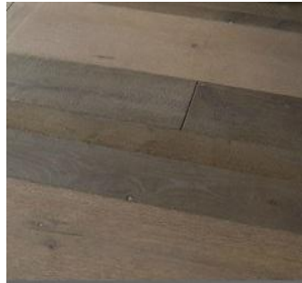
Δάπεδο α' ορόφου.
