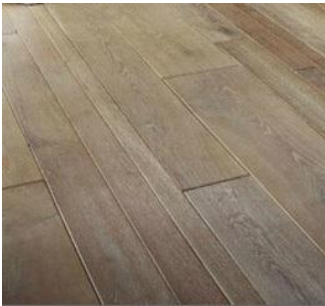
Δάπεδο ισογείου και β' ορόφου.
