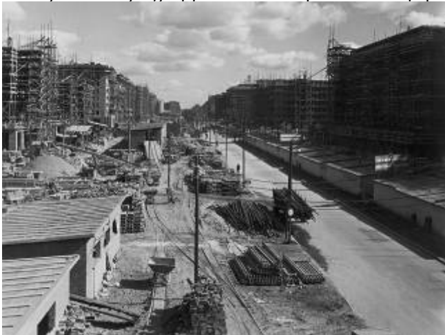
Εικόνα 84: Εργοτάξιο στη Stalinallee 1953.
