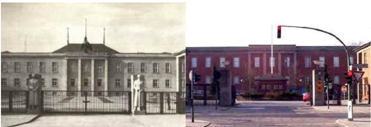
Εικόνα 68-69: Πρόσοψη Καγκελαρίας, οι φρουροί δεν έχουν αφαιρεθεί, αλλά καλύπτονται με τσιμέντο.
