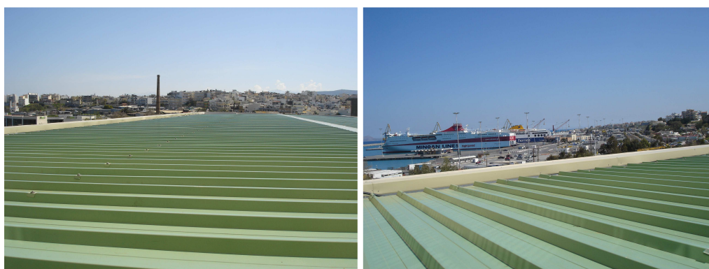
εικ.20-20α. Σύνθετα πανέλα αλουμινίου με θερμομόνωση στο ανατολικό δώμα.
