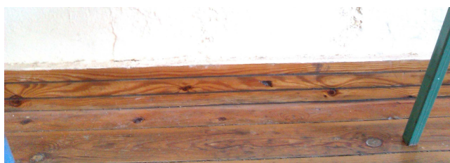
εικ.19. Το ξύλινο πάτωμα της κατασκευής των εδράνων του αμφιθεάτρου.
