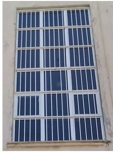
εικ.23. Προστατευτικές σιδεριές του παραθύρου του κλιμακοστασίου του Ά και Β ορόφου.
