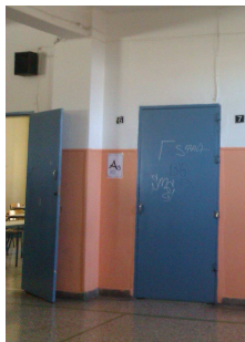
εικ.24. Εσωτερικά κουφώματα.
