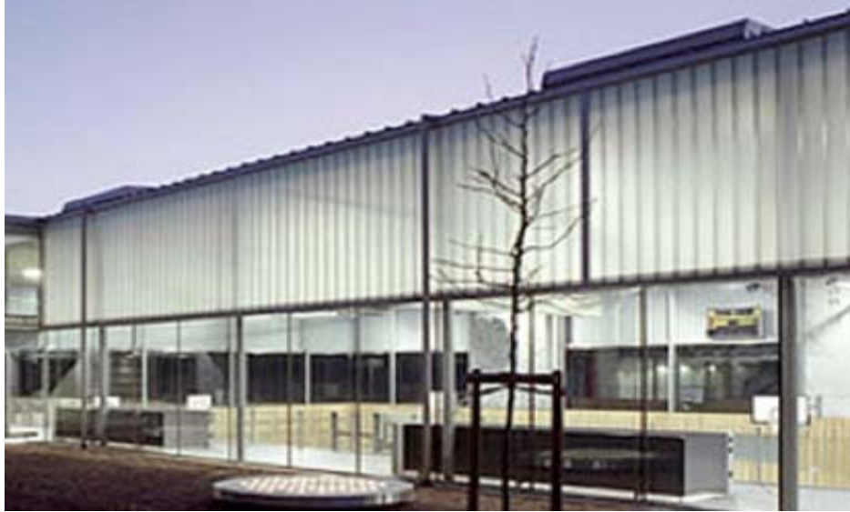
Εικόνα 3.15: Διαφανή μονωτικά υλικά ( http://www.cres.gr )
