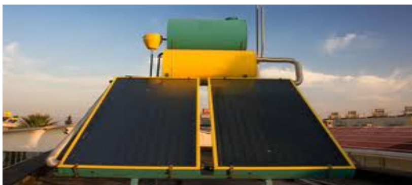
Εικόνα 3.18: Ηλιακός θερμοσίφωνας
