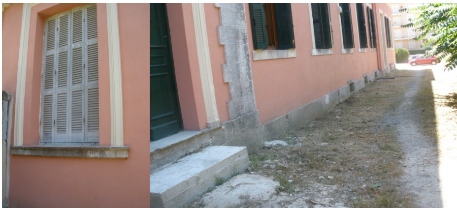
Εικόνα 2.1: Εξωτερικά πλαίσια βόρειας πλευράς κτιρίου.
