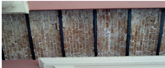
Εικόνα 1.16: Οροφή ισόγειου (υπόστεγο κύριας εισόδου)
