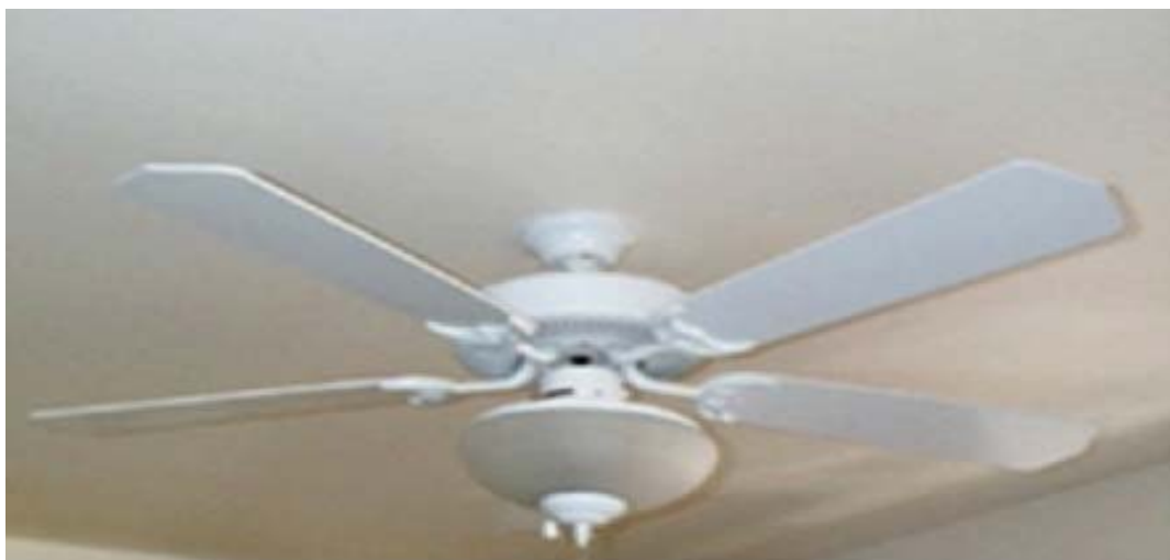
Εικόνα 3.11: Υβριδικός αερισμός με χρήση ανεμιστήρα οροφής.
