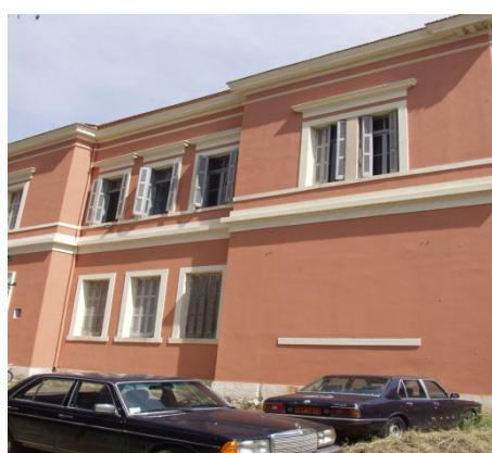
Πίσω όψη κτιρίου μετά την ανακαίνιση
