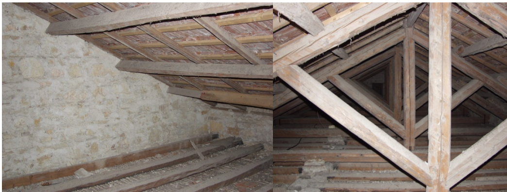
Εικόνες 1.19α,β: Κατάσταση στέγης μετά την ανακαίνιση
