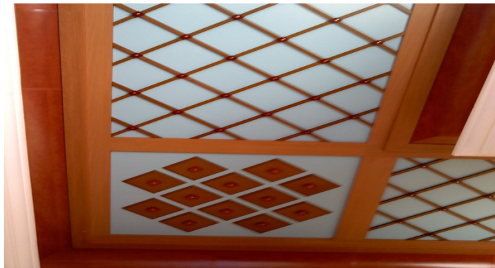
Εικόνα 1.14: Η νέα ψευδοροφή του κτιρίου
