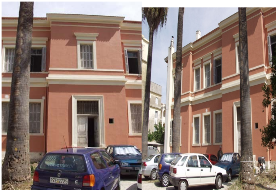
Εικόνα 1.8 (εξωτερική αποκατάσταση επιχρισμένων όψεων)
