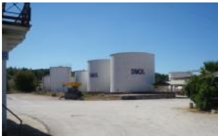
Εικόνα 8 Οι δεξαμενές πετρελαίου. Οι συγκριμένες δεξαμενές βρίσκονται εκτός λειτουργίας και θα πρέπει να αξιοποιηθούν κατά την πρόταση της μελέτης.
