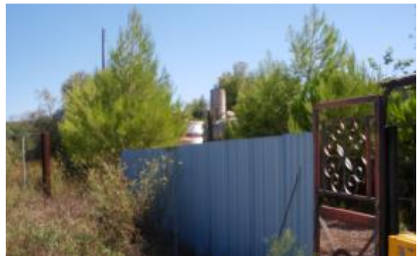
Εικόνα 11 Περιμετρικά του οικοπέδου η περίφραξη δεν καλύπτει τις προδιαγραφές που θέτονται, είτε λόγω πλήρους ανυπαρξίας φράχτη είτε λόγω ελλιπούς περίφραξης
