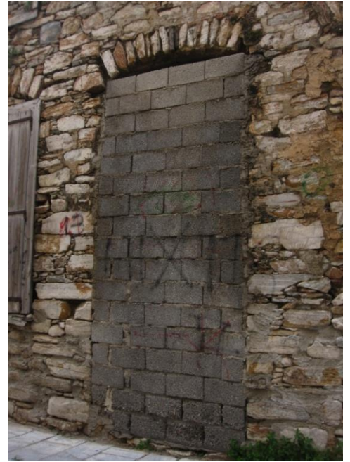
Εικόνα 114: Φράξιμο θύρας της βόρειας όψης από τσιμεντόλιθους
