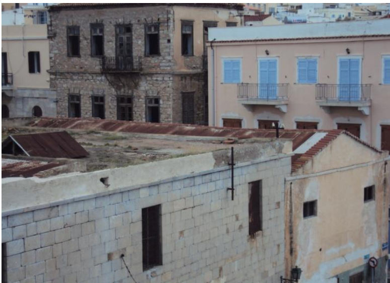
Εικόνα 63: Δώμα οροφής χώρου 1
