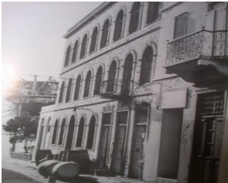
Εικόνα 162: Τύπος θυρών και παραθύρων κτιρίου της εποχής από βιβλίο "Βιομηχανικά κτίρια στην Ερμούπολη"
