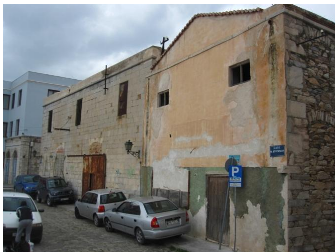
Εικόνα 99: Εξωτερική επέμβαση προκειμένου να σφραγιστεί με ξύλινη σχέδια τρύπα στην τοιχοποιία της ανατολικής όψης
