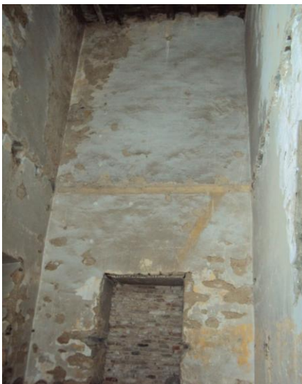
Εικόνα 51: Ύπαρξη προγενέστερου μεσοπατώματος στον χώρο 9
