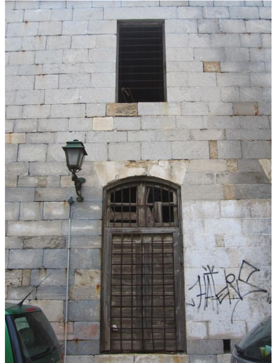
Εικόνα 38: Εξωτερικά ανοίγματα νότιας όψης
