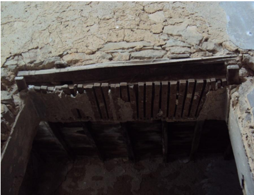
Εικόνα 35: Τρόπος κατασκευής πρεκιού στον χώρο 11
