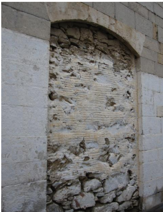
Εικόνα 111: Φράξιμο θύρας της νότιας όψης από ανεπίχριστη λιθοδομή
