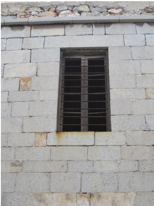
Εικόνα 39: Τύπος κουφώματος της επάνω σειράς παραθύρων της νότιας όψης
