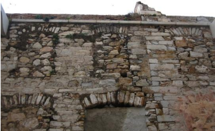
Εικόνα 13: Εξωτερική άποψη των τόξων της βόρειας πλευράς
