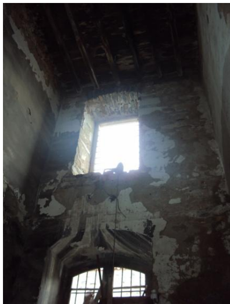
Εικόνα 65: Ξύλινη οροφή χώρου 6
