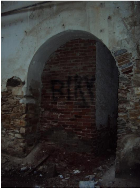
Εικόνα 5: Μεταγενέστερη προσθήκη τοίχου από συμπαγείς οπτόπλινθους
