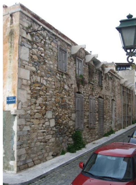
Εικόνα 26: Αναμονές μαρμάρινων φορουσιών βόρειας όψης
