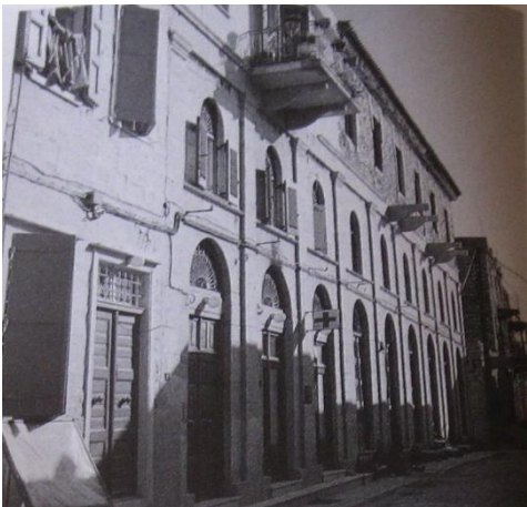
Εικόνα 177: Προσθήκη ορόφου σε κτίριο αποθηκών, από βιβλίο “Βιομηχανικά κτίρια στην Ερμούπολη”
