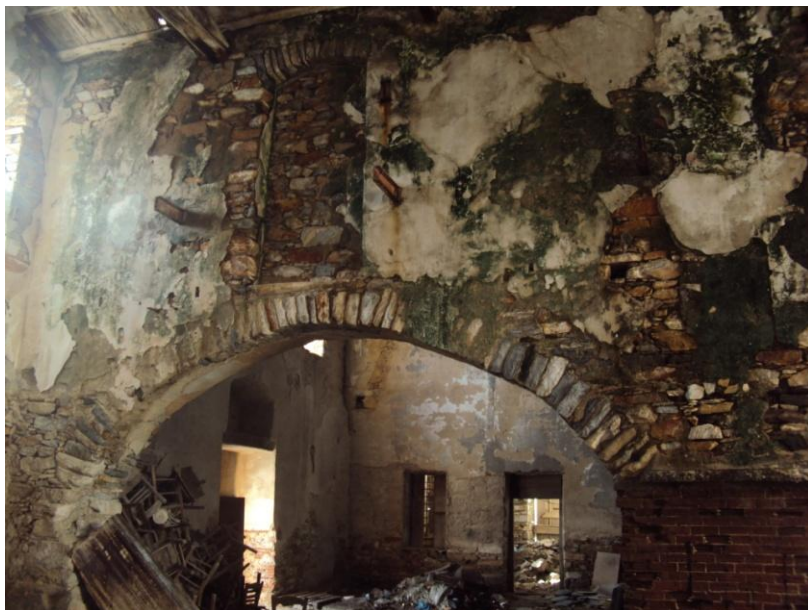
Εικόνα 105: Φράξιμο παραθύρου από λιθοδομή μεταξύ των χώρων 02A&1
