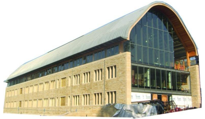
Εικόνα 182: Περιμετρικός φεγγίτης στέγης με παρεμφερή διάταξη ανοιγμάτων, της στέγασης του χώρου 04
