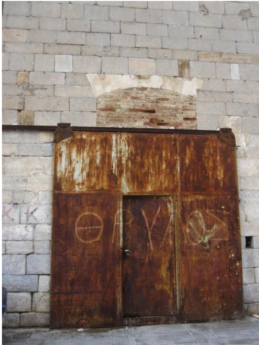
Εικόνα 109: Προσθήκη μεταγενέστερης σιδερένιας πόρτας στο τροποποιημένο άνοιγμα του χώρου 01
