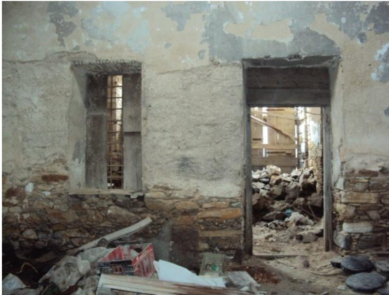
Εικόνα 33: Εσωτερικά κουφώματα του χώρου 12
