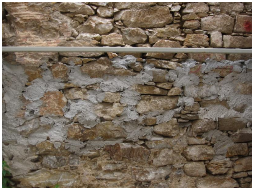
Εικόνα 128: προσθήκη αρμολογήματος με τοιμέντο σε τμήματα της τοιχοποιίας της βόρειας όψης
