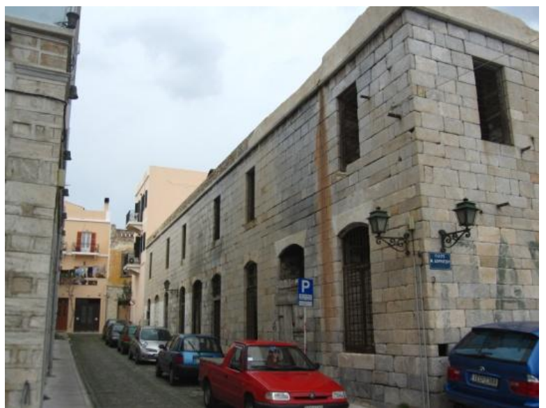
Εικόνα 8: Επένδυση τοιχοποιίας από μάρμαρο του νοτιοανατολικού όγκου
