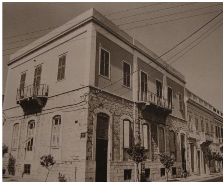
Εικόνα 164: Κτίριο της εποχής με ανεπίχριστη λιθοδομή στο ισόγειο και επιχρισμένη στον όροφο
