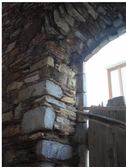
Εικόνα 1: Τρόπος χτισίματος τοιχοποιίας μαζί με την εξωτερική επένδυση
