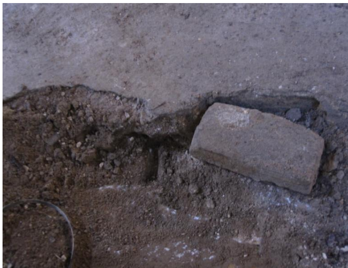
Εικόνα 59: Κατασκευαστική μορφή δαπέδου στον χώρο 01
