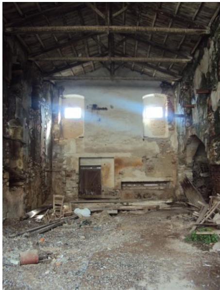
Εικόνα 15: Ξύλινη στέγη του χώρου 02Α
