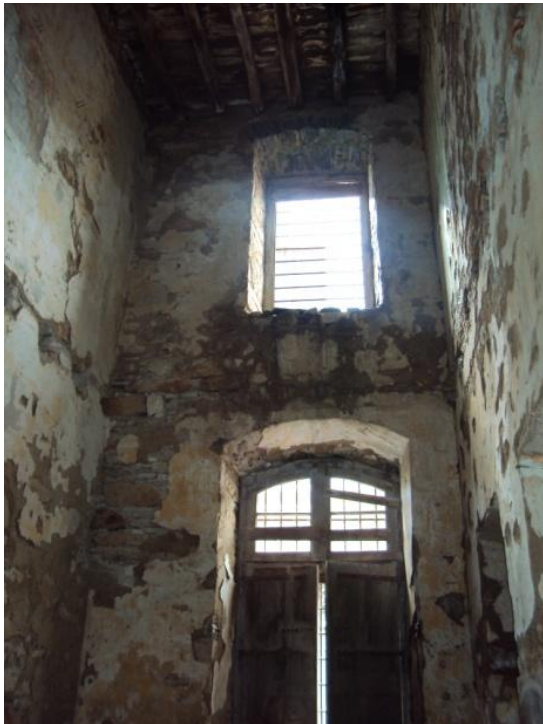
Εικόνα 9: Τρόπος κατασκευής τόξων στα εξωτερικά ανοίγματα της νότιας πλευράς
