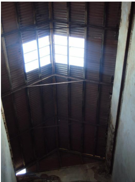
Εικόνα 19: Στέγη διαδρόμου στον χώρο 09
