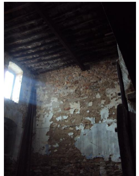
Εικόνα 64: Ξύλινη οροφή χώρου 5
