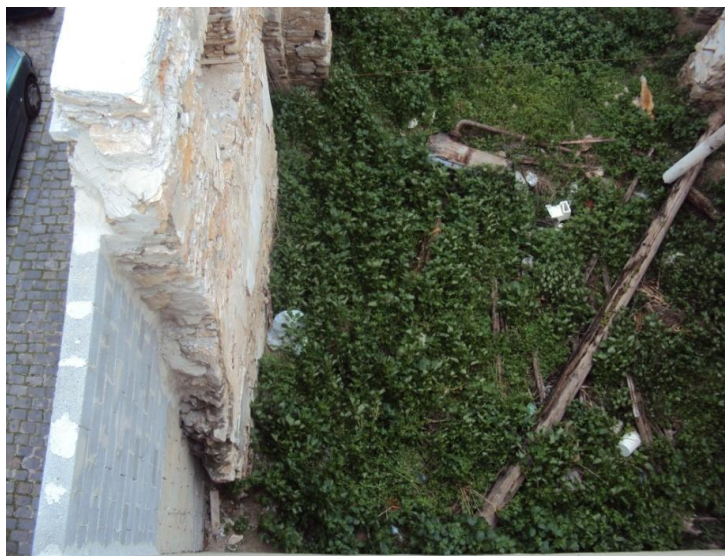
Εικόνα 4: Χτίσιμο τοιχοποιίας με γέμισμα στον πυρήνα
