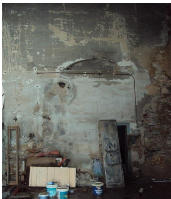
Εικόνα 107: Φράξιμο καμαρωτού ανοίγματος από επιχρισμένη λιθοδομή μεταξύ των χώρων 01&10
