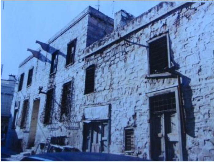
Εικόνα 173: Μορφολογικά στοιχεία όψεων βιομηχανικού κτιρίου της εποχής, από βιβλίο " Βιομηχανική περιοχή Ερμούπολης Σύρου"
