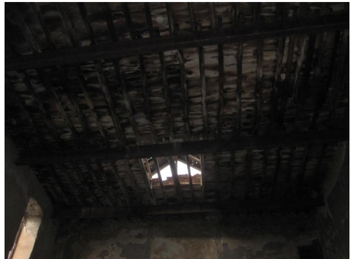
Εικόνα 140: Σάπισμα ξύλινων στοιχείων και οξειδώσεις διπλών "T" της οροφής του χώρου 01
