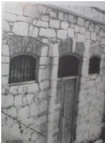
Εικόνα 161: Τύπος θύρας αποθηκών κτιρίου από βιβλίο "Βιομηχανικά κτίρια στην Ερμούπολη"
