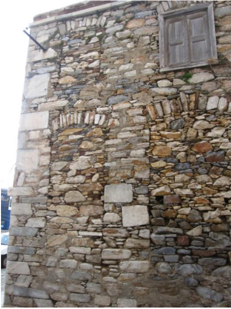
Εικόνα 113: φράξιμο ανοιγμάτων βόρειας όψης από ανεπίχριστη λιθοδομή
