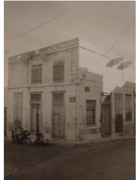
Εικόνα 166: Λιτές όψεις με περιμετρικές μαρμάρινες ταινίες, τυπική διάταξη ανοιγμάτων και αναμονές φορουσιών για τυχόν προσθήκη οροφου από βιβλίο "Βιομηχανικά κτίρια στην Ερμούπολη"
