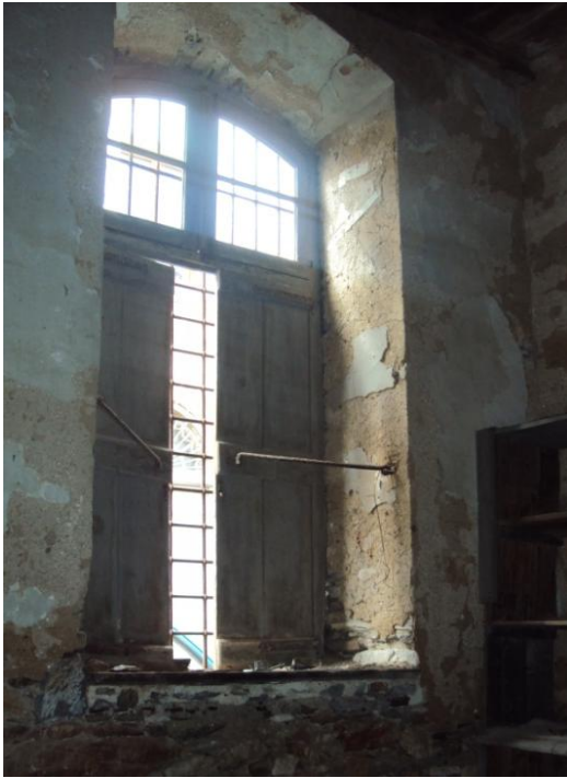
Εικόνα 37: Εσωτερική πλευρά εξωτερικού παραθύρου στον χώρο 11
