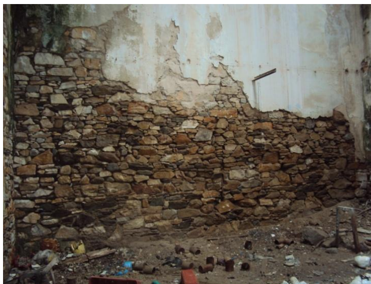
Εικόνα 3: Εσωτερική όψη τοίχου στον χώρο 03
