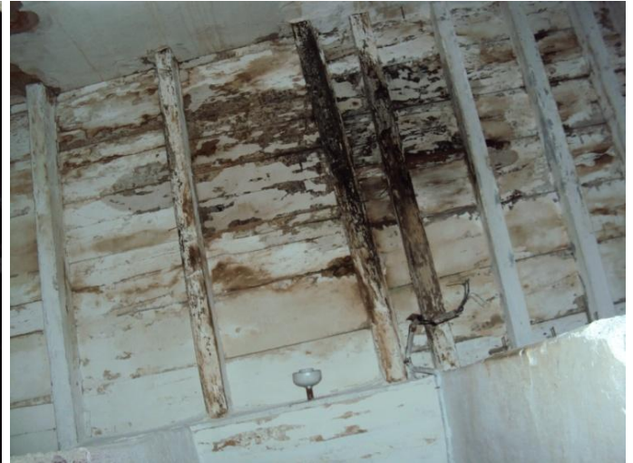
Εικόνα 50: Μεσοπάτωμα στον χώρο 7
