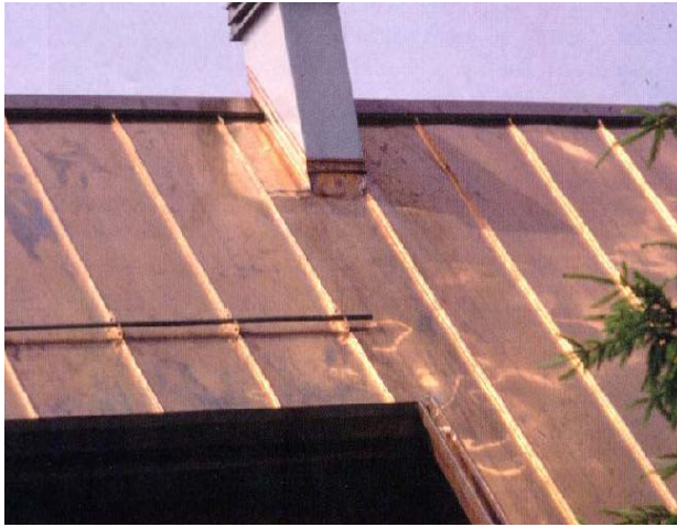
Εικόνα 181: Στέγη κάθετης ραφής από φύλλα χαλκού, για την στέγαση του χώρου 04
