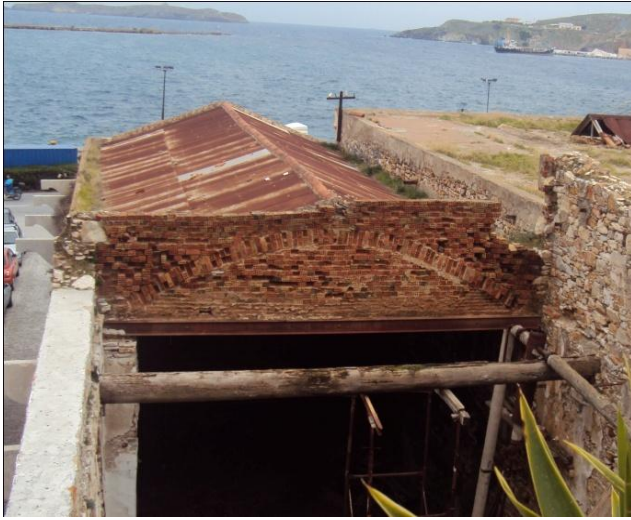
Εικόνα 17: Επικάλυψη στέγης του χώρου 02Α από φύλλα λαμαρίνας
