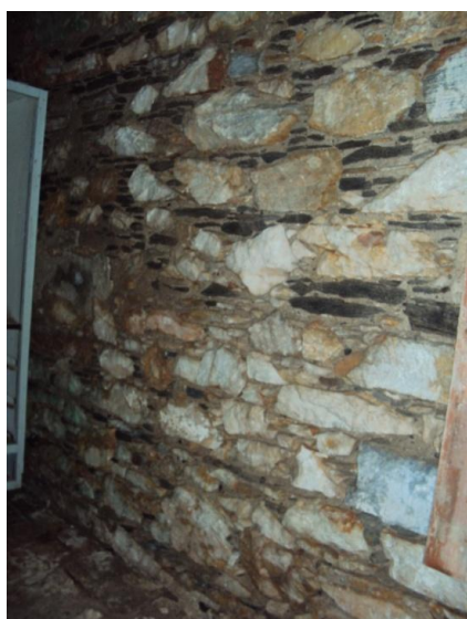
Εικόνα 2: Εσωτερική όψη τοίχου στον χώρο 06
