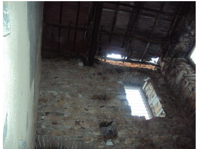
Εικόνα 24: Τρόπος στήριξης στέγης χώρου 12
