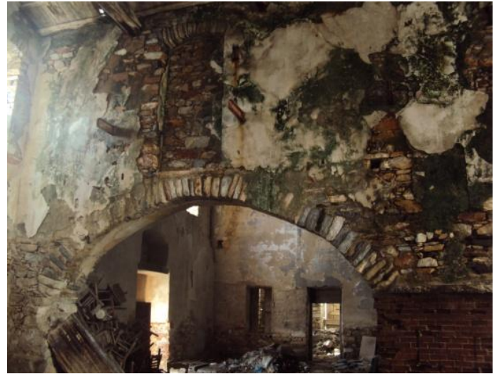
Εικόνα 14: Τόξο καμάρας του χώρου 02Α
