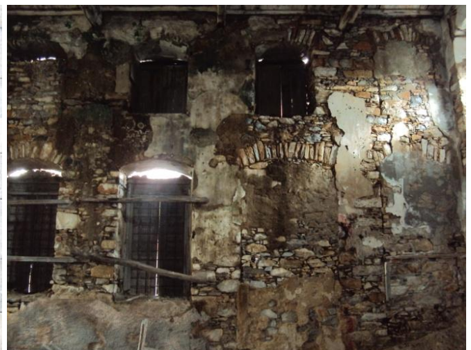
Εικόνα 12: Τόξα ανοιγμάτων της βόρειας πλευράς
