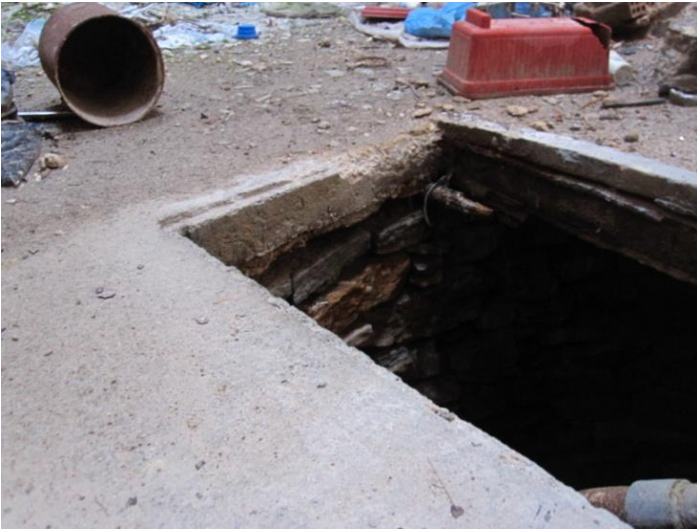
Εικόνα 57: Εμφανής τομή δαπέδου στον χώρο 03 για τη δημιουργία πηγαδιού
