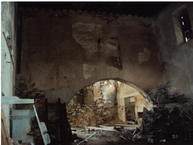
Εικόνα 27: Μεταγενέστερη διάνοιξη τοίχου για άμεση επικοινωνία των χώρων 01&02
