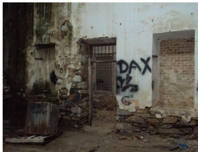
Εικόνα 104: Αριστερά φράξιμο παραθύρου με εκτοξευμένο επίχρισμα, δεξιά φράξιμο με συμπαγείς οπτόπλινθους στον χώρο 03
