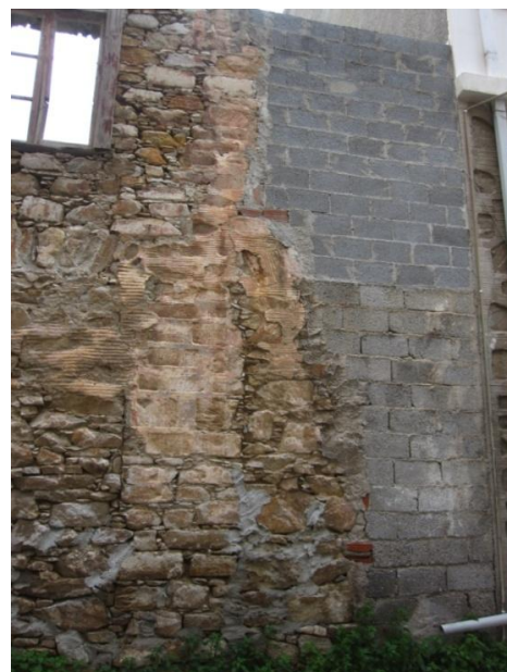
Εικόνα 82: Πρόχειρη ανακατασκευή τοίχου μετσιμεντόλιθους(02B)
