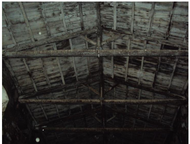
Εικόνα 16: Ζευκτά ξύλινης στέγης του χώρου 02Α
