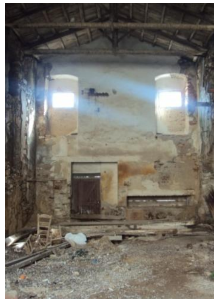
Εικόνα 106: Φράξιμο ανοιγμάτων από λιθοδομή και αλλαγή στις διαστάσεις αυτών στον χώρο 02A
