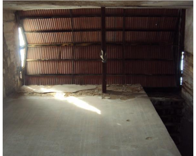
Εικόνα 18: Στέγη διαδρόμου στον χώρο 08
