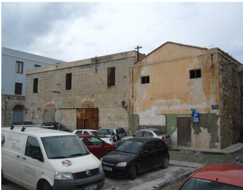
Εικόνα 25: Περιμετρική μαρμάρινη ταινία στη στέψη του κτιρίου
