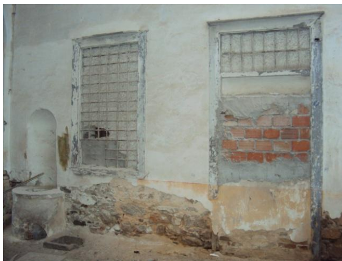
Εικόνα 103: Φράξιμο παραθύρου με εκτοξευμένο σκυρόδεμα και πόρτας με οπτοπλινθοδομή από διάτρητους οπτόπλινθους στον χώρο 04
