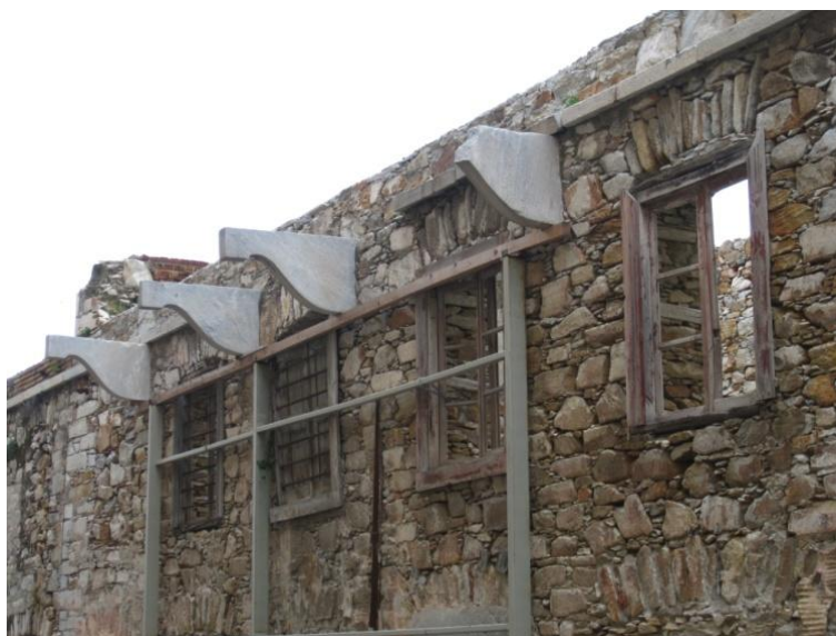
Εικόνα 97: Γκρέμισμα φορουσιού και στήριξης αυτών με σκαλωσιά(μεταγενέστερης επέμβασης)στην βόρεια όψη
