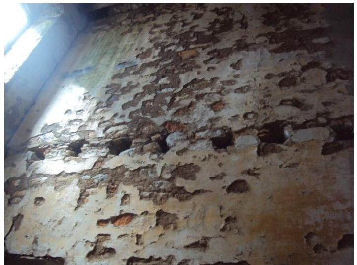
Εικόνα 52: Ύπαρξη προγενέστερου μεσοπατώματος στον χώρο 9
