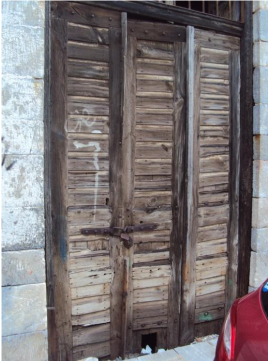
Εικόνα 41: Πόρτα νότιας όψης
