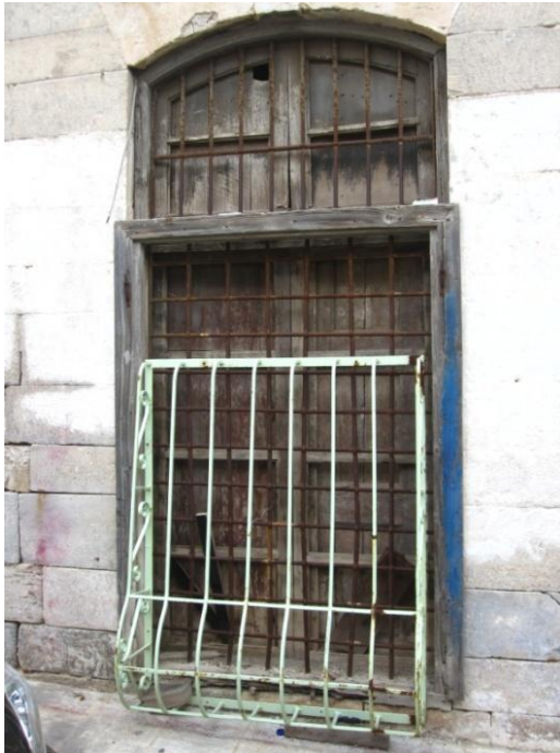
Εικόνα 121: Προσθήκη κιγκλιδώματος σε παράθυρο της νότιας όψης
