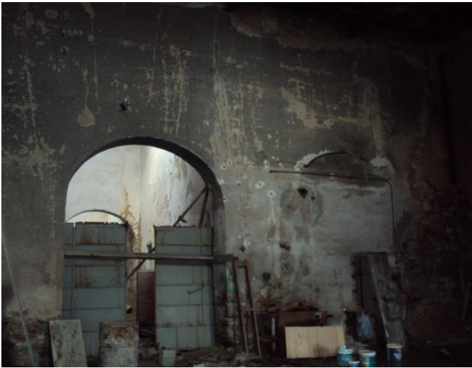
Εικόνα 73: Απόχρωση του μπλε στους νοτιοδυτικούς τοίχους του χώρου 1
