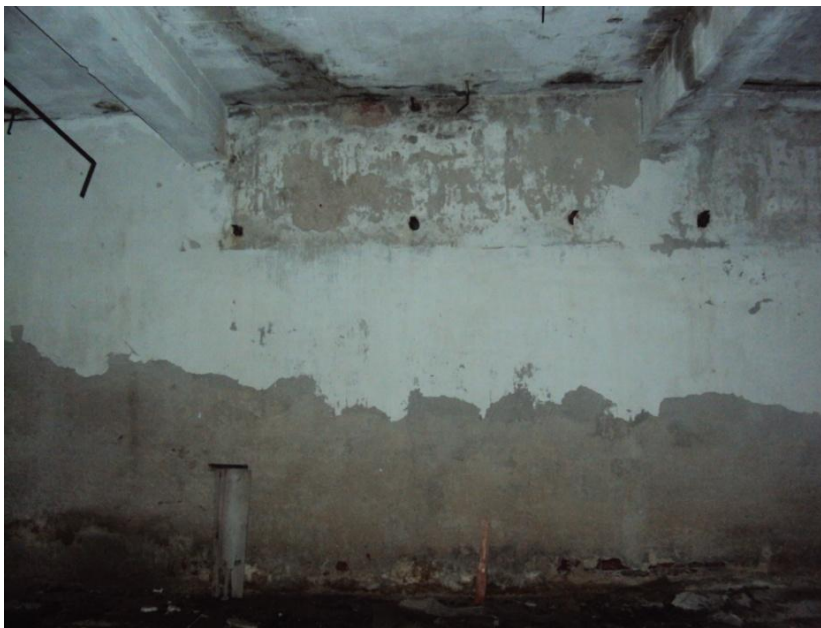
Εικόνα 46: Μεταγενέστερο επίχρισμα χώρου 10
