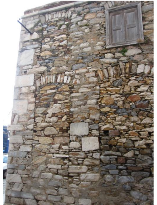
Εικόνα 6: Τρόπος χτισίματος βόρειας όψης
