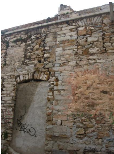
Εικόνα 7: Λαμπάς που χώριζε του δυο όγκους της βόρειας πλευράς
