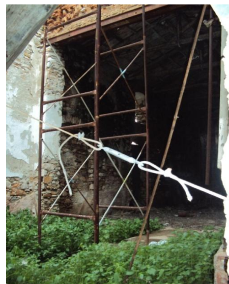
Εικόνα 84: Γκρέμισμα τοίχου για ενοποίηση των χώρων 02A&02B
