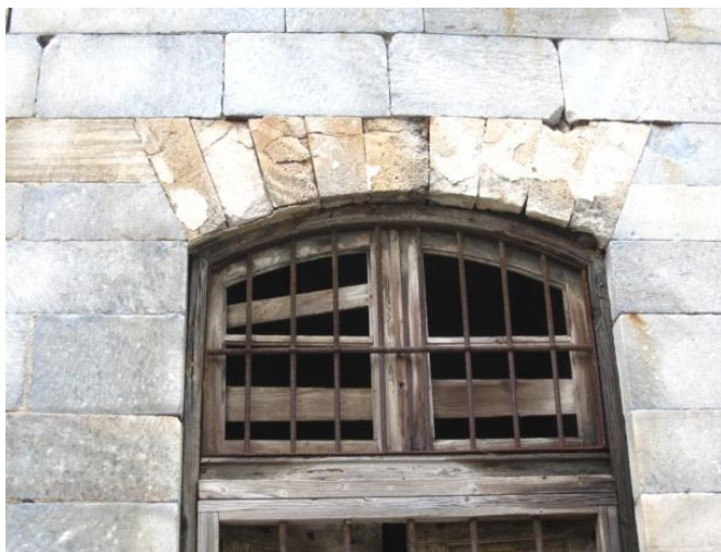
Εικόνα 11: Εξωτερική μαρμάρινη επένδυση τόξου νότιας πλευράς
