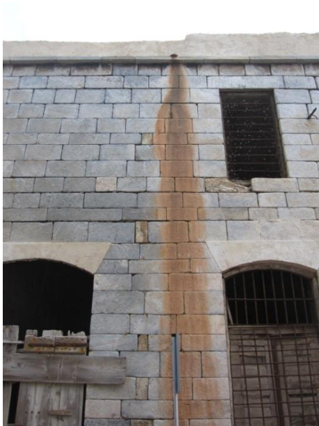
Εικόνα 101: Σημάδια οξείδωσης που εμφανίζονται στο μάρμαρο μεταφερόμενα μέσω της καθοδικής υγρασίας
