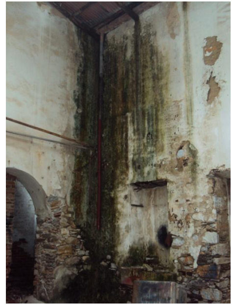
Εικόνα 22: Υδρορροή στέγης χώρου 03
