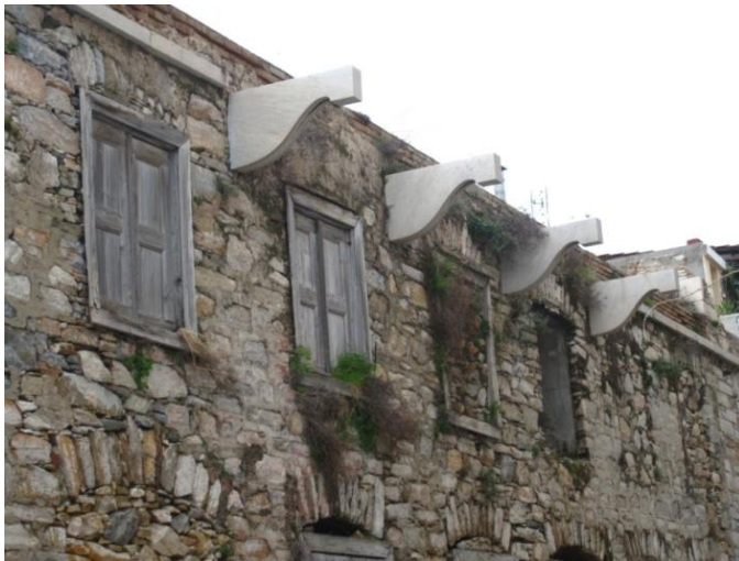
Εικόνα 43: Εξωτερικά παράθυρα βόρειας όψης
