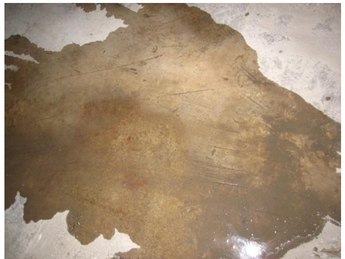
Εικόνα 60: Δάπεδο του χώρου 10 με επίστρωση από λειασμένη τσιμεντοκονία
