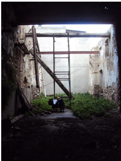
Εικόνα 31: Προγενέστερη καμάρα στα μέσα του χώρου 02B
