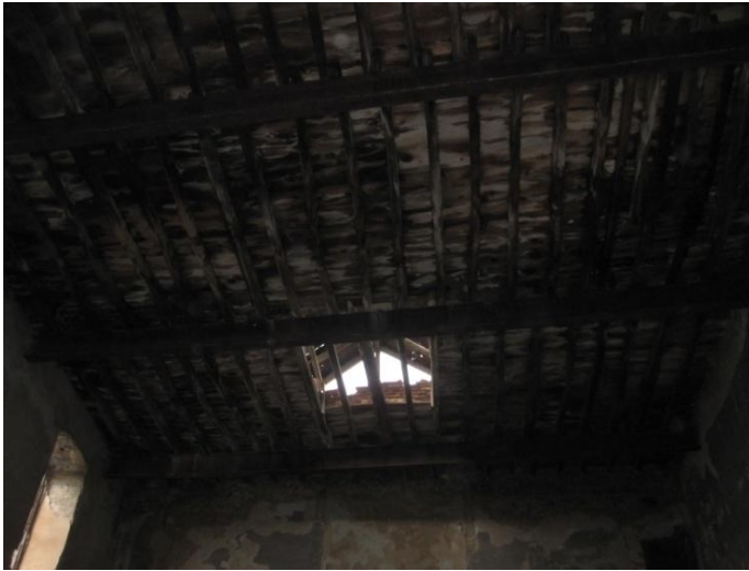
Εικόνα 61: Ξύλινη οροφή χώρου 1
