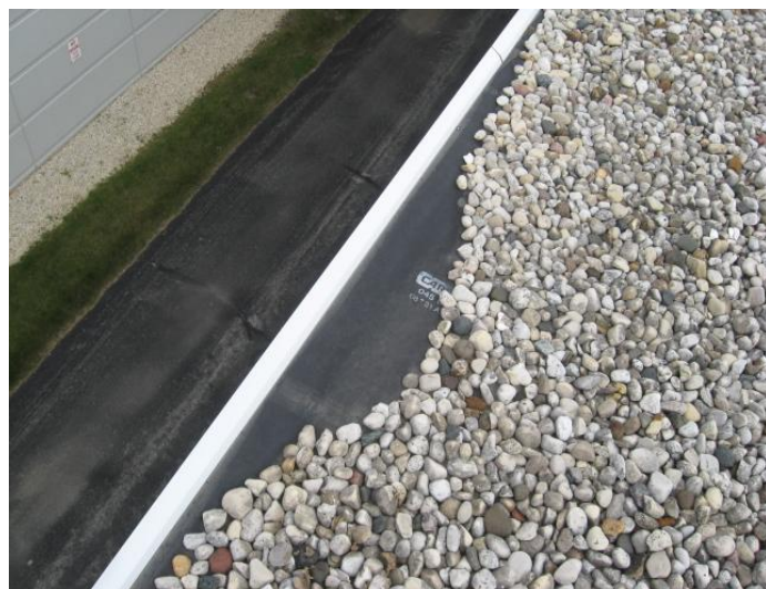
Εικόνα 186 : Τύπος βότσαλου που θα χρησιμοποιηθεί για την κάλυψη της μόνωσης του δώματος
