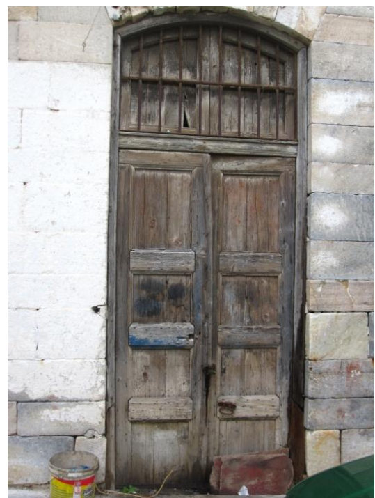
Εικόνα 40: Πόρτα νότιας όψης
