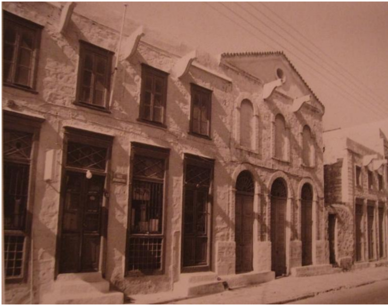
Εικόνα 165: Διάτρητη όψη με τυπική διάταξη ανοιγμάτων και αναμονές φορουσιών για τυχόν προσθήκη ορόφου από βιβλίο "Βιομηχανικά κτίρια στην Ερμούπολη"
