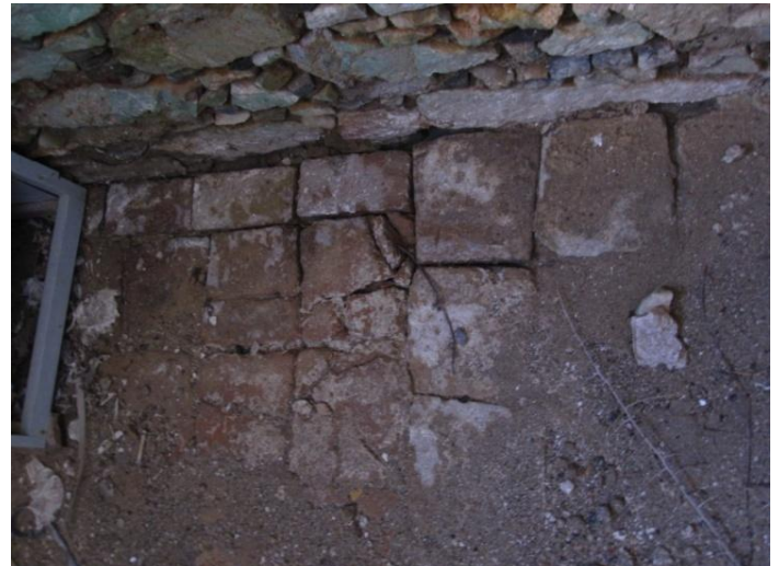
Εικόνα 56: Δάπεδο από κυβόλιθους στον χώρο 06
