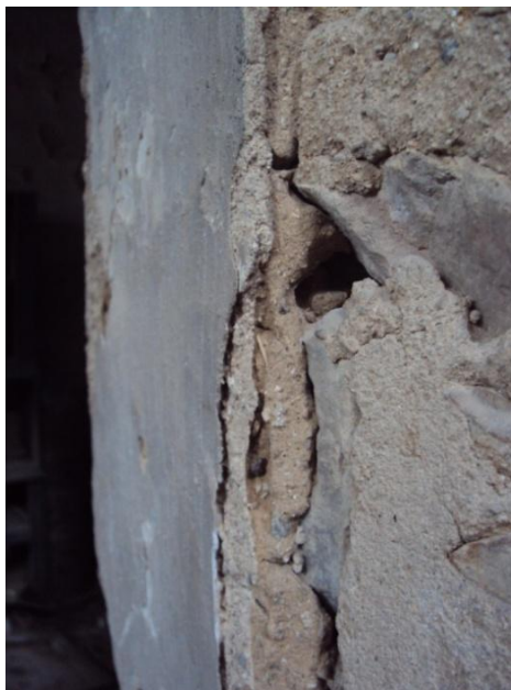
Εικόνα 45: Εσωτερικά επίχρισματα τοίχων τριών στρώσεων
