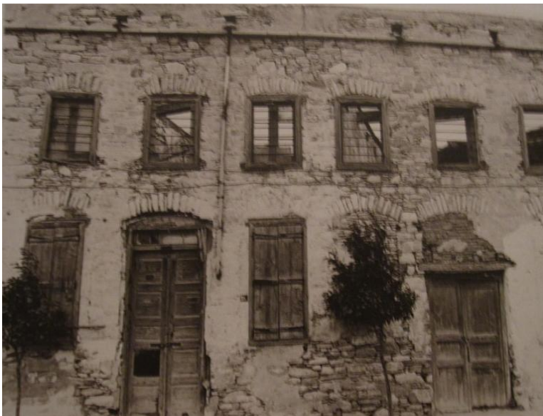
Εικόνα 167: Μορφολογικά στοιχεία ανοιγμάτων σε ανεπίχριστη όψη τυπικού βιομηχανικού κτιρίου της εποχής από βιβλίο "Βιομηχανικά κτίρια στην Ερμούπολη"
