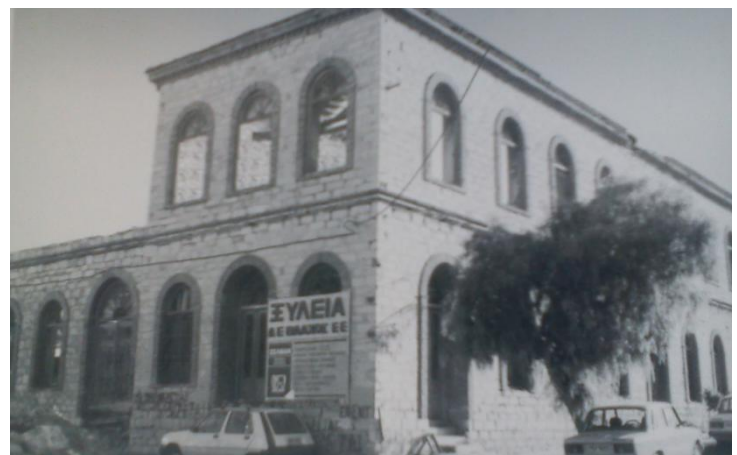
Εικόνα 180: Τυπολογία όψεων βιομηχανικού κτιρίου της εποχής, από το βιβλίο “Βιομηχανικά κτίρια στην Ελλάδα”
