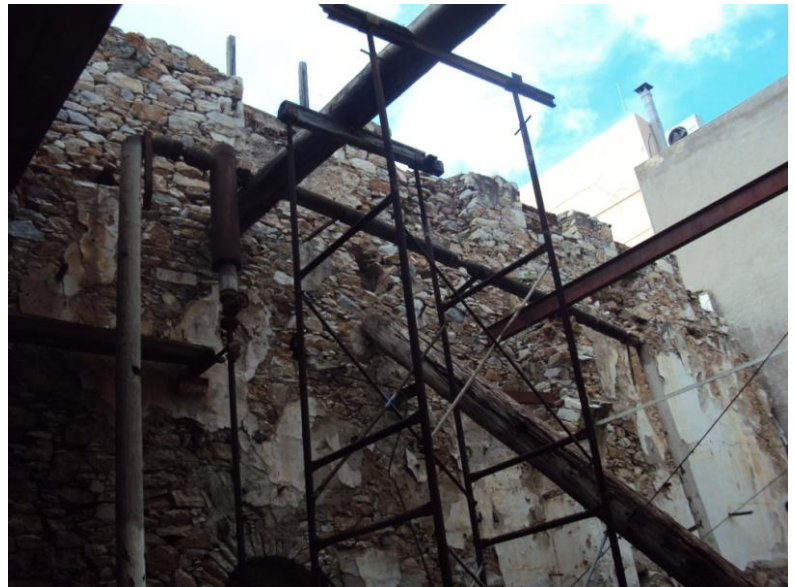
Εικόνα 144: Εναπομείναντες σωληνώσεις της τελευταίας χρήσης του κτιρίου, χώρος 02B
