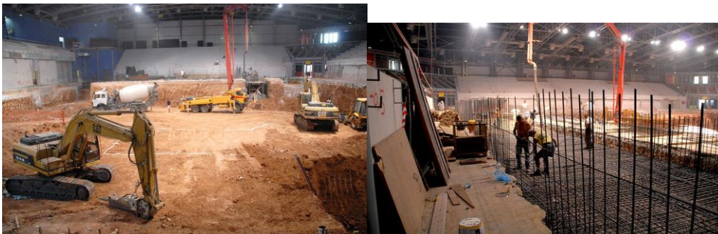
Φωτογραφίες από την περίοδο ανακατασκευής
