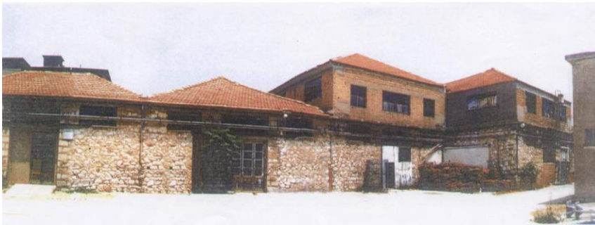
Κτίρια Β – Μηχανουργεία / Νότια όψη
