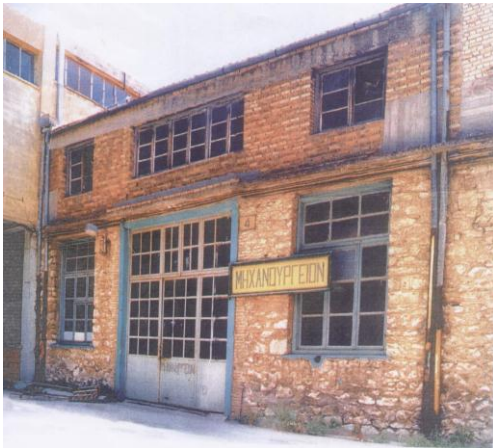
Κτίρια Β – Μηχανουργεία / Βόρεια όψη
