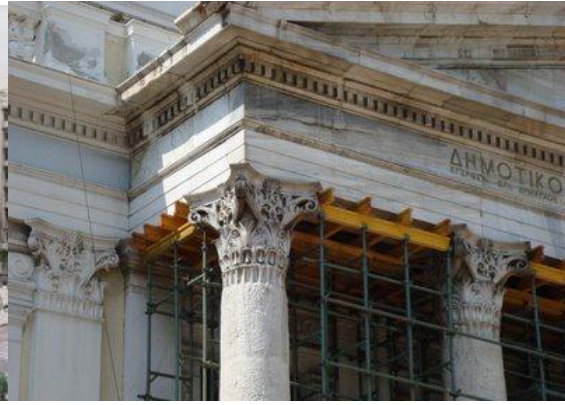
Φωτογραφία εργασιών ανακαίνισης
