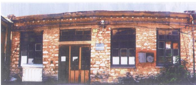
Κτίρια Β – Ξυλουργεία / Νότια όψη
