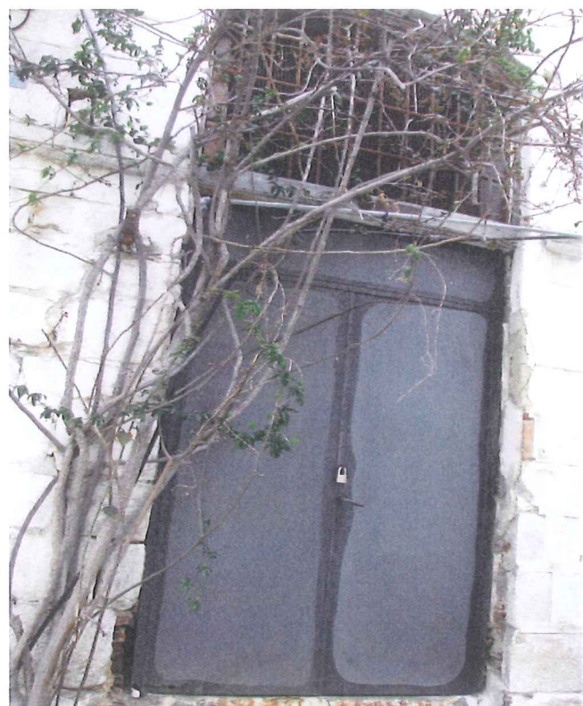
Εικ.95 Πόρτα αποθήκης βόρειας όψης
