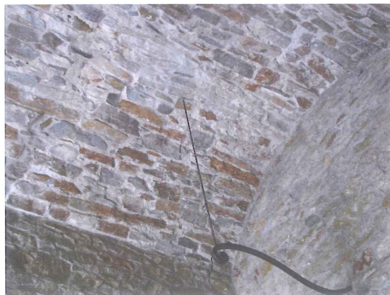
Εικ.74 Λιθόκτιστη θολωτή οροφή καφενείου
