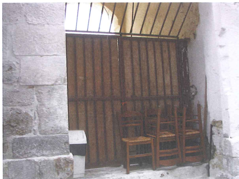
Εικ.69 Τοιχοποιία εξωτερική άποψη, γωνιόλιθοι
