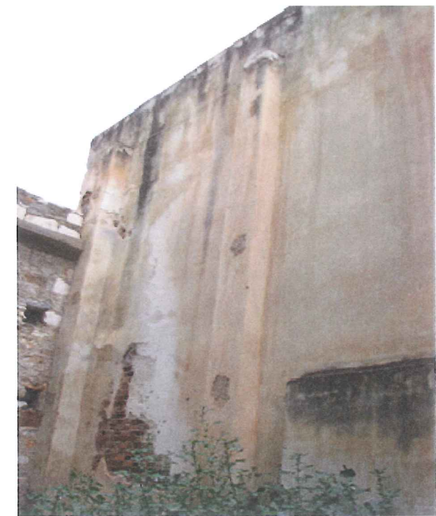
Εικ.84 Αποκόλληση σοφά
