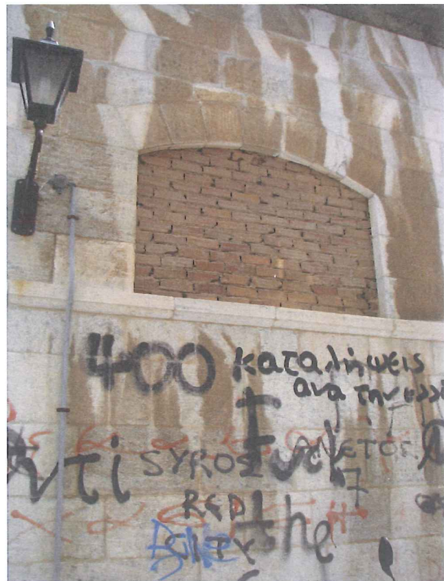
Εικ.102 Σφραγισμένο άνοιγμα δυτικής όψης
