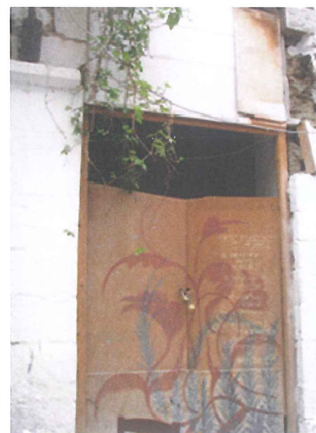
Εικ.93 Πόρτα νότιας όψης
