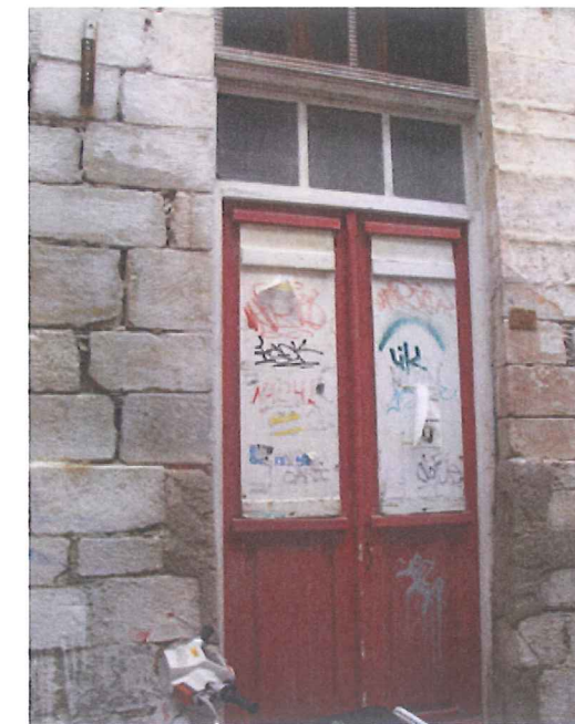
Εικ.92 Πόρτα νότιας όψης
