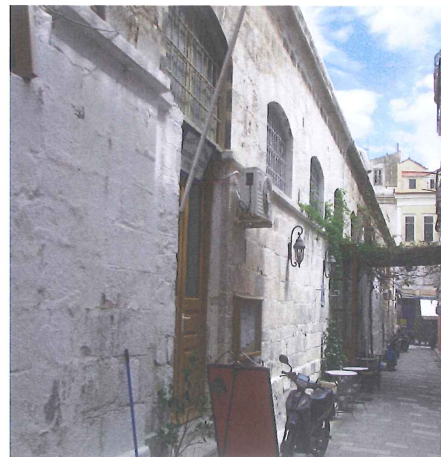
Εικ.63 Νοτιοανατολική όψη
