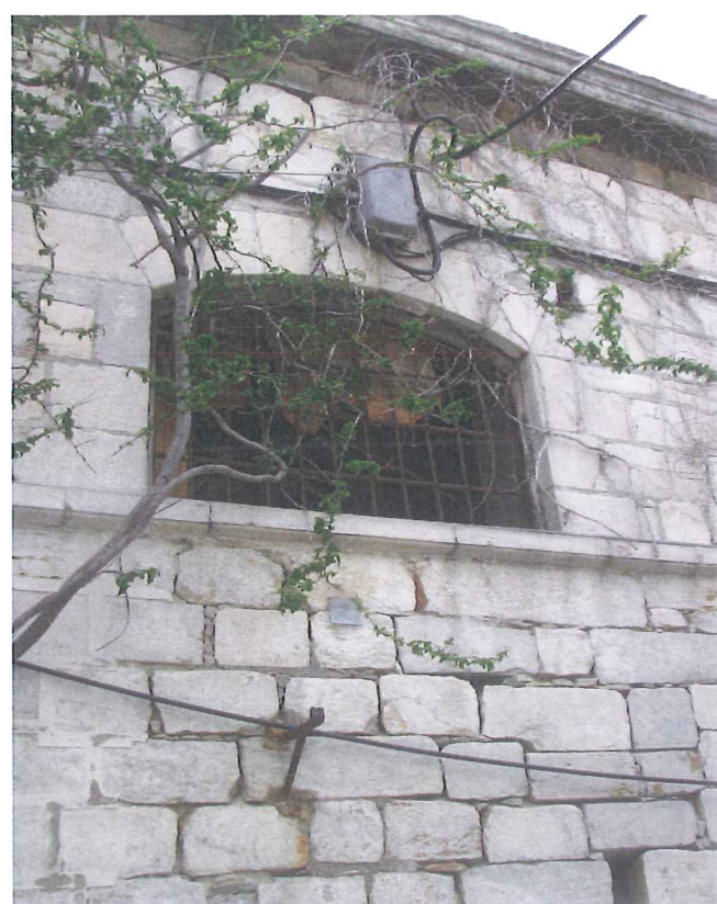
Εικ.96 Φεγγίτης βόρειας πλευράς
