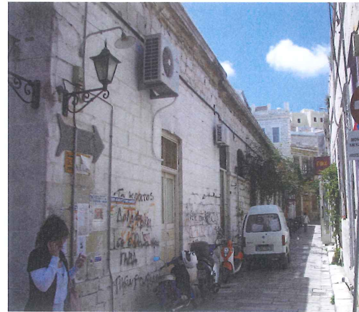
Εικ.61 Βόρεια όψη από ανατολική όψη
