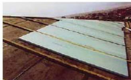
Φωτογραφική παρουσίαση εργασιών μόνωσης κεκλιμένης στέγης επάνω από πλάκα οπλισμένου σκυροδέματος
