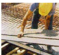
Φωτογραφική παρουσίαση εργασιών θερμομόνωσης κάτω από πλάκα οπλ. Σκυοδέματος
