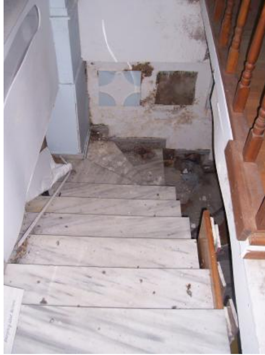
εικ.44 Αντικατάσταση ξύλινων πατωμάτων από πλάκα οπλισμένου σκυροδέματος και επικάλυψη με πλακίδια
