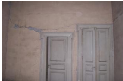
εικ.122: Εσωτερική τοιχοποιία
