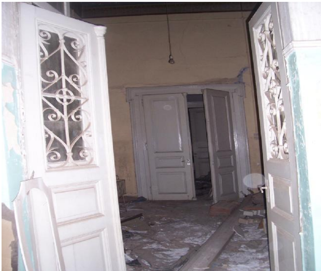
εικ 155: Καθαίρεσις κουφομάτων
