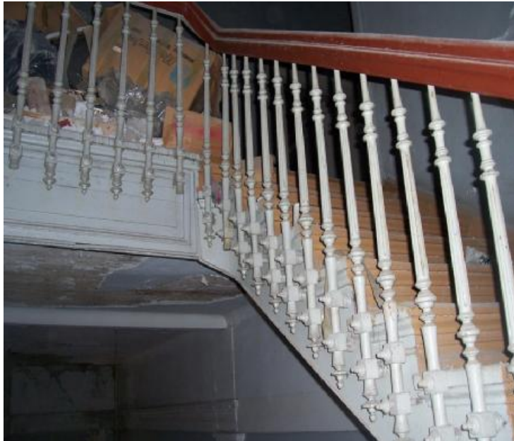
εικ 161: Εσωτερική Κλίμακα
