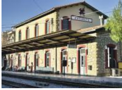
εικ.31: Ο σταθμός του ΟΣΕ
