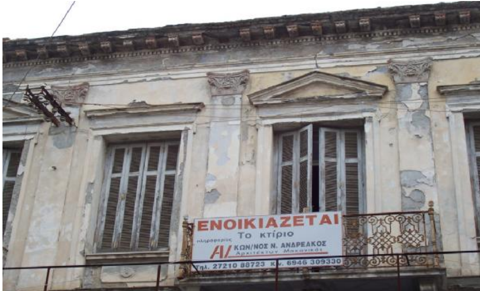
εικ 153: Καθαρέσεις Κουφωμάτων
