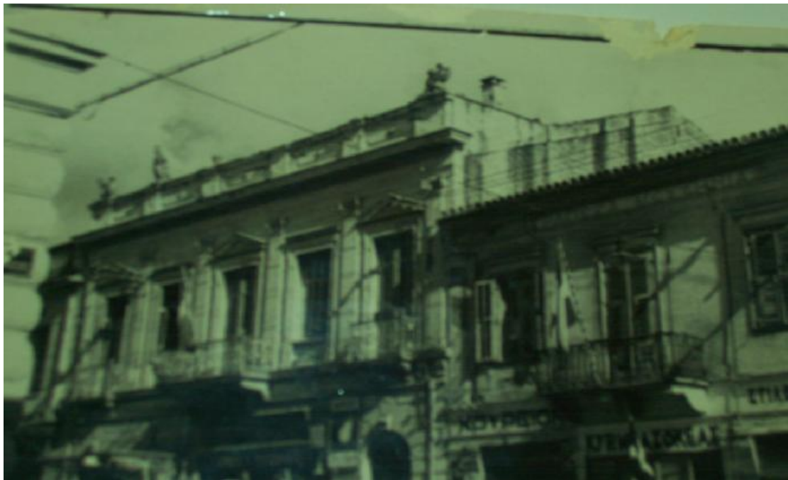
εικ.36: Πρόσοψη του Κτιρίου του 1962
