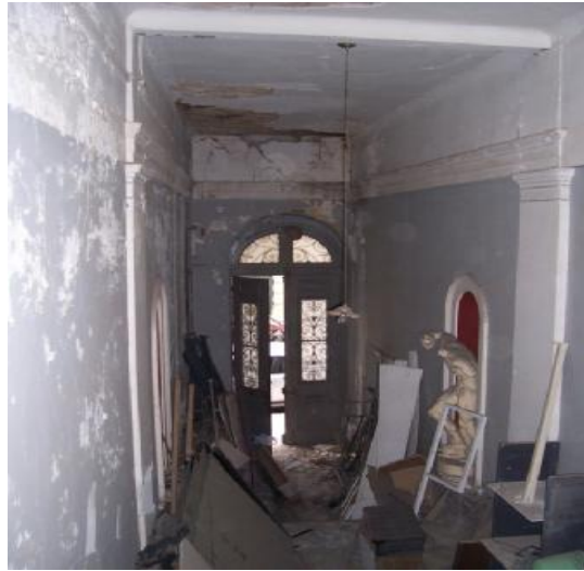
εικ.91: Οροφή χώρου 1
