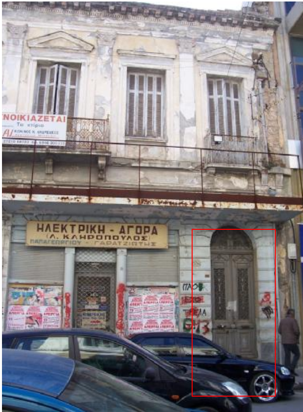
εικ.66: Κεντρική είσοδος κτιρίου
