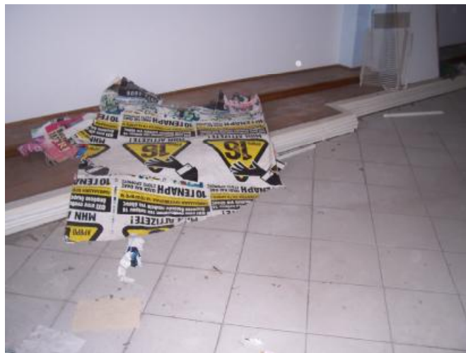
εικ.43 Αντικατάσταση ξύλινων πατωμάτων από πλάκα οπλισμένου σκυροδέματος και επικάλυψη με πλακίδια.
