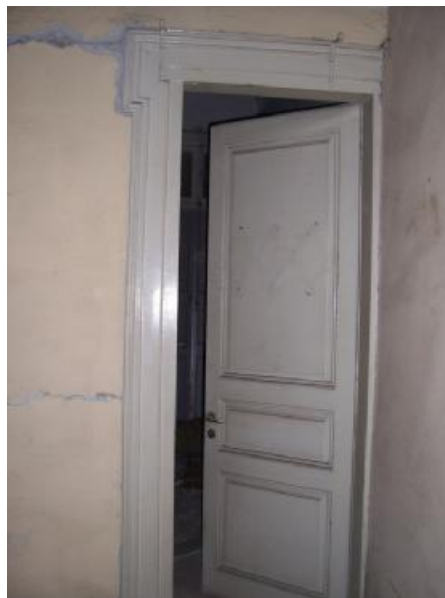
εικ.108: Εσωτερικά κουφώματα ορόφου
