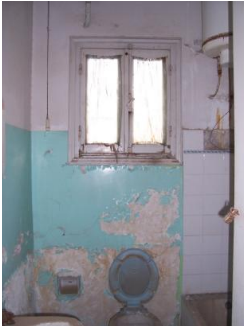
εικ.113: Λουτρό κτιρίου (προσθήκη)
