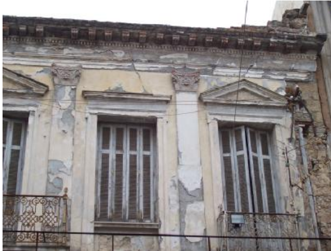
εικ.80: Εξωτερικά ανοίγματα ορόφου
