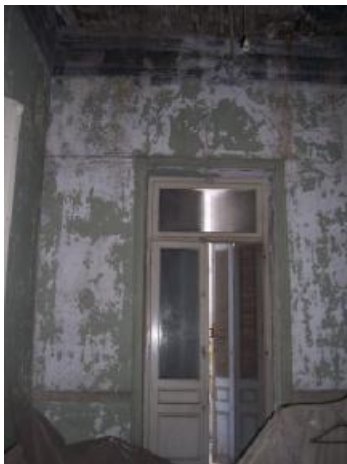
εικ.121: Εσωτερική τοιχοποιία
