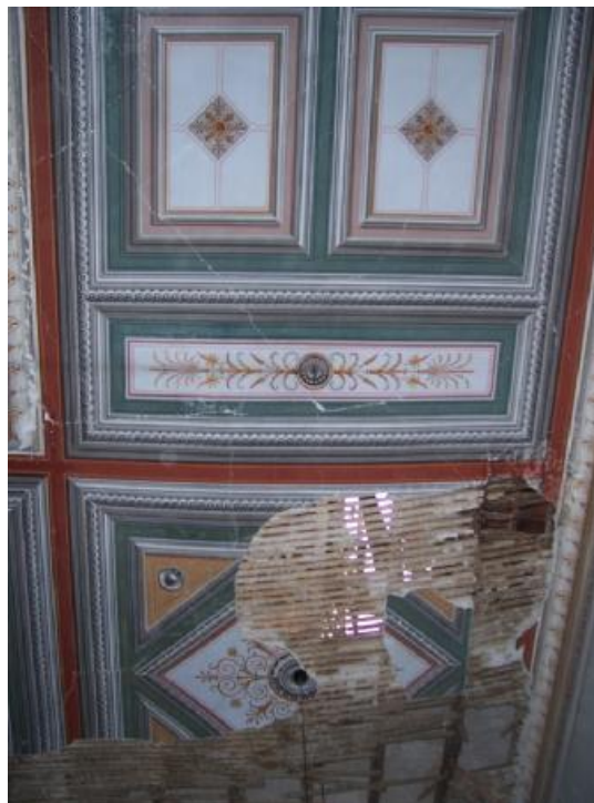
εικ.94: Οροφή διαδρόμου στον όροφο.
