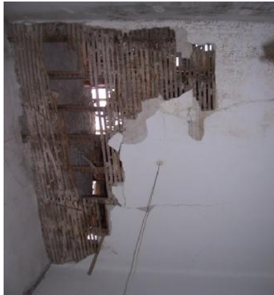
εικ.93: Οροφή δωματίου 5 στον όροφο
