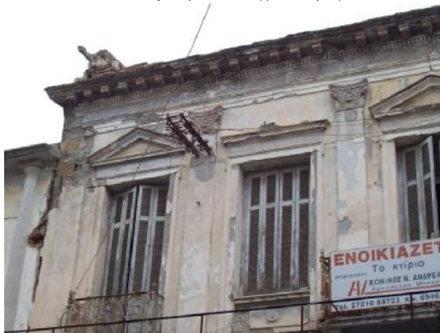
εικ.81: Εξωτερικά ανοίγματα ορόφου
