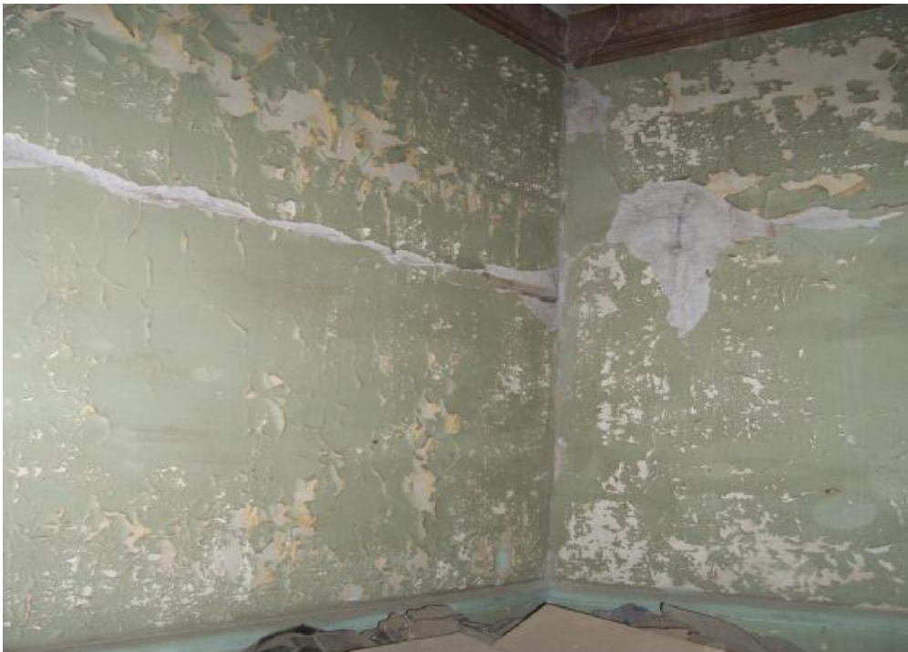
εικ 149: Καθαιρέσεις Επίχρισμάτων
