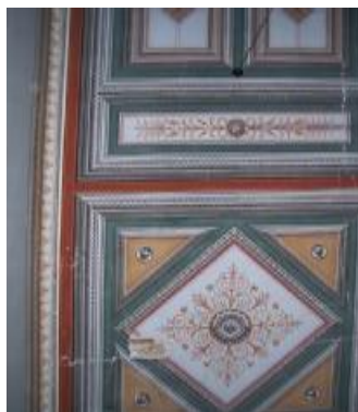
εικ 157: Καθαίρεσις γύψινων στοιχείων.
