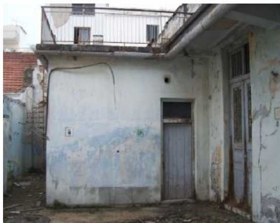
εικ.130: Προσθήκη ορόφου.
