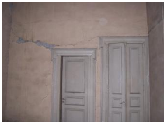
εικ.107: Εσωτερικά κουφώματα ορόφου
