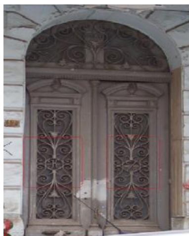
εικ.38 Κεντρική Είσοδος Κτιρίου
