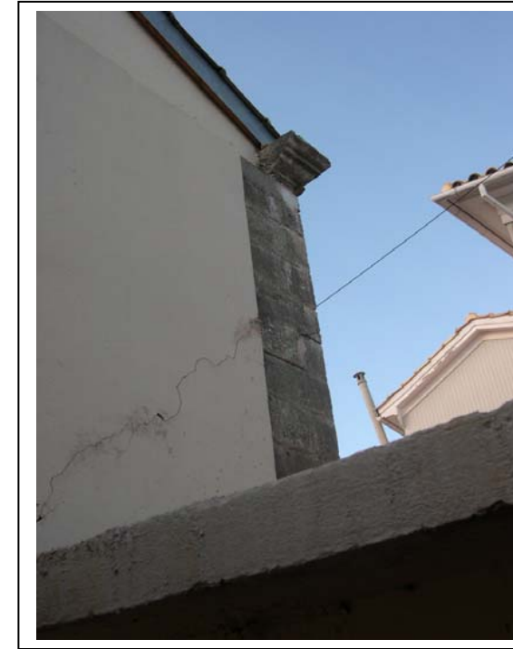
Φωτογραφία 31 : Λοξή ρηγμάτωση ανατολικά
