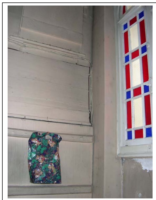
Φωτογραφία 76 : Απροστάτευτη καλωδιακή όδευση στο τέμπλο στο χώρο του Ιερού.
