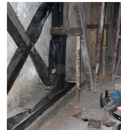
Φωτογραφία 14. Αποκατάσταση του ξύλινου εσωτερικού περιμετρικού
