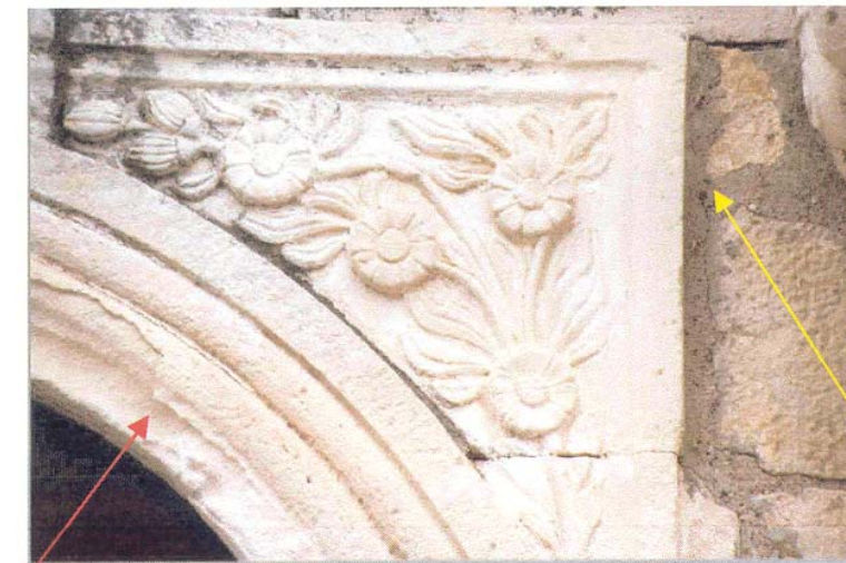
Φωτογραφία 19. Εφαρμογή κονιαμάτων τσιμέντου
