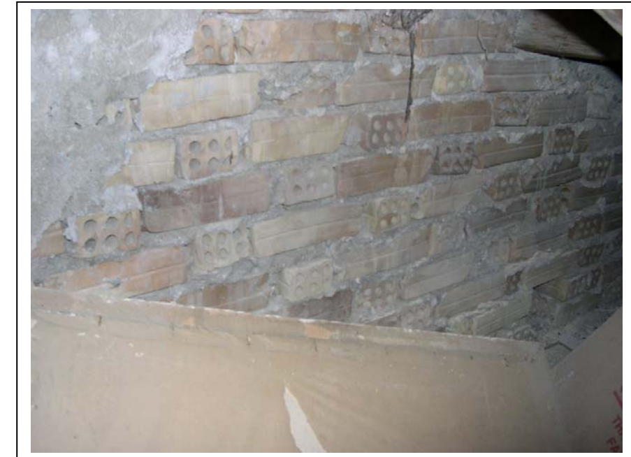
Φωτογραφία 43 : Εσωτερική άποψη μπατικής τοιχοδομής του δυτικού αετώματος
