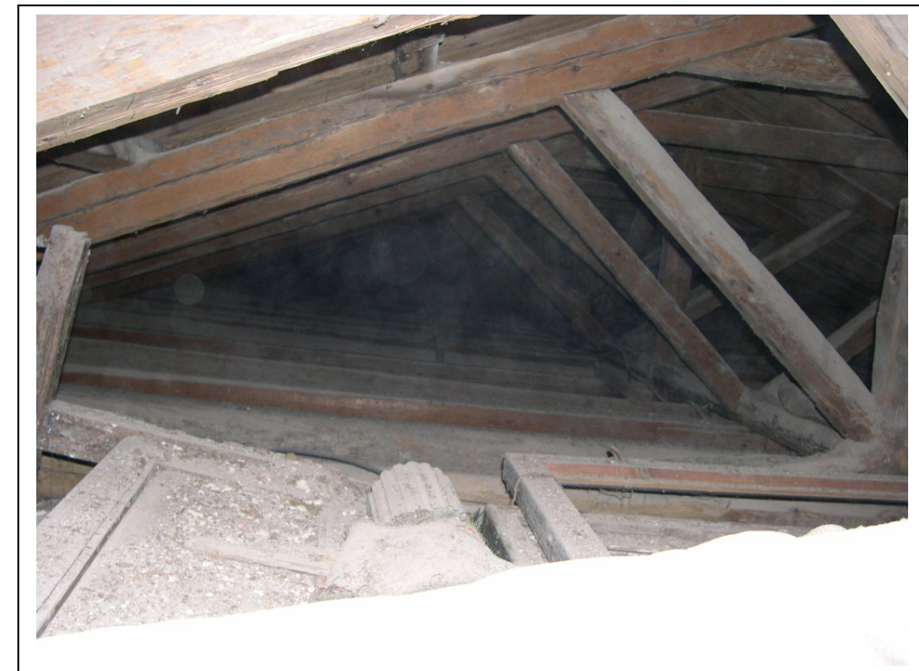
Φωτογραφία 44: Άποψη στέγης και επίπεδο ανάρτησης ουρανίας
