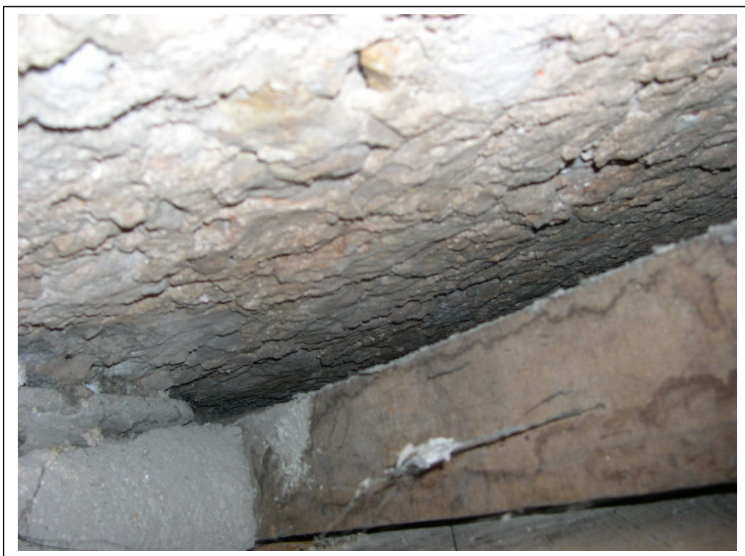
Φωτογραφία 61 : Άποψη της κατάστασης στο εσωτερικό μέρος της ξύλινης περιμετρικής επένδυσης των τοιχοδομών
