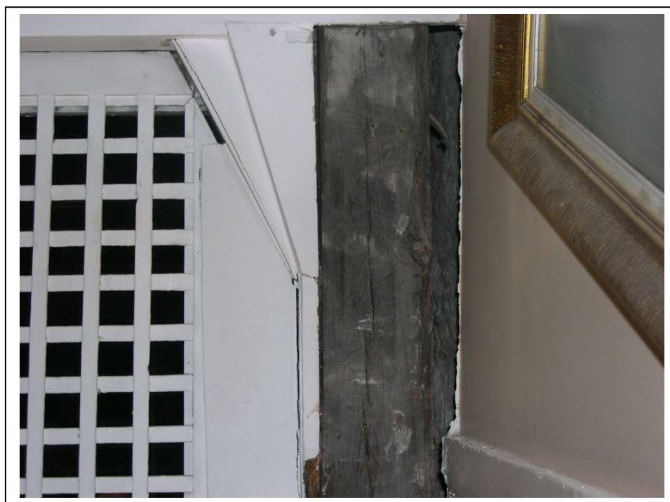
Φωτογραφία 62 : Φέρων ξύλινος στύλος της στέγης όπως φαίνεται στην στάθμη του γυναικωνίτη
