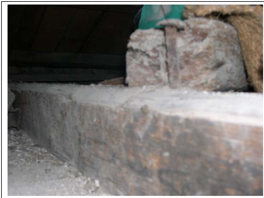
Φωτογραφία 54 : Τοπική αστοχία ξύλινου στοιχείου συνδεδεμένο με καρφί (γούφτικο)
