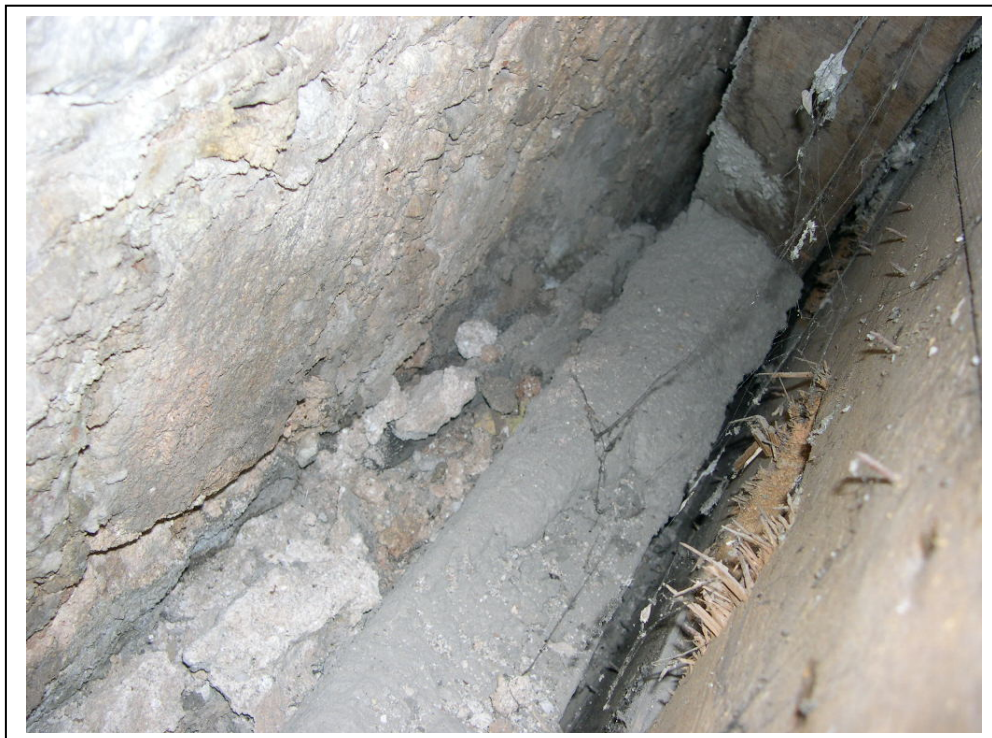
Φωτογραφία 57 : Άποψη της κατάστασης στο εσωτερικό μέρος της ξύλινης περιμετρικής επένδυσης των τοιχοδομών – έδραση κατακόρυφων στύλων σε διάζωμα από σκυρόδεμα στη βάση
