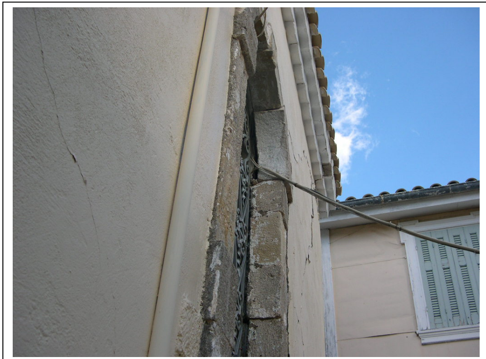
Φωτογραφία 9 Δυτική όψη, αέτωμα από τουβλοδομή με κεντρική οπή και επίχρυσμα. Εμφανές διάζωμα από σπλισμένο σκυρόδεμα στην βάση του αετώματος.
