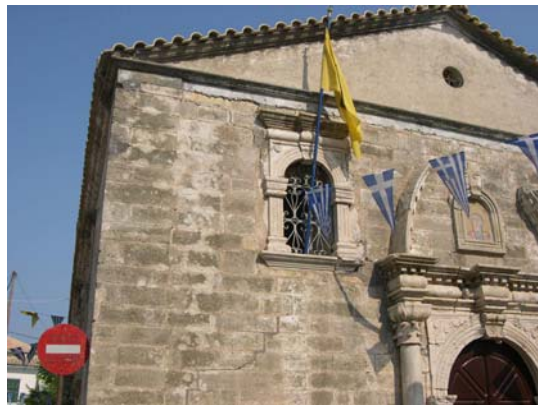
Φωτογραφία 4. Δυτική άποψη του Ναού με εμφανή την θέση του οριζόντιου διαζώματος
