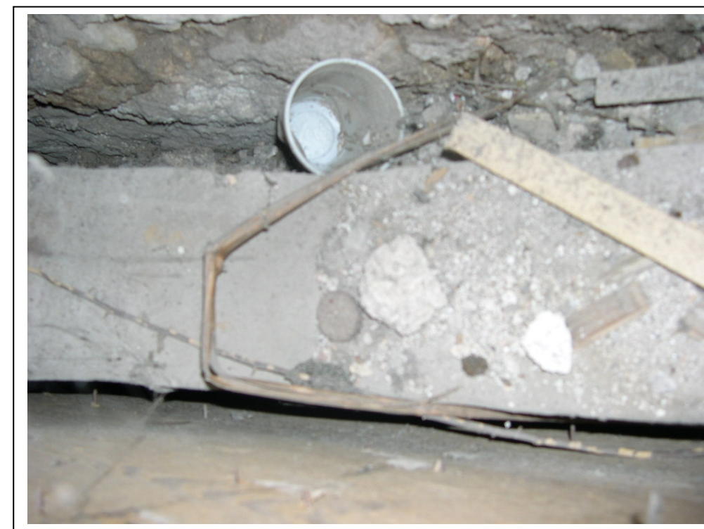
Φωτογραφία 60 : Άποψη της κατάστασης του διαζώματος βάσης στο εσωτερικό μέρος της ξύλινης περιμετρικής επένδυσης των τοιχοδομών
