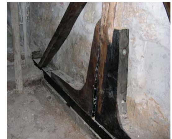
Φωτογραφία 14. Αποκατάσταση του ξύλινου εσωτερικού περιμετρικού
