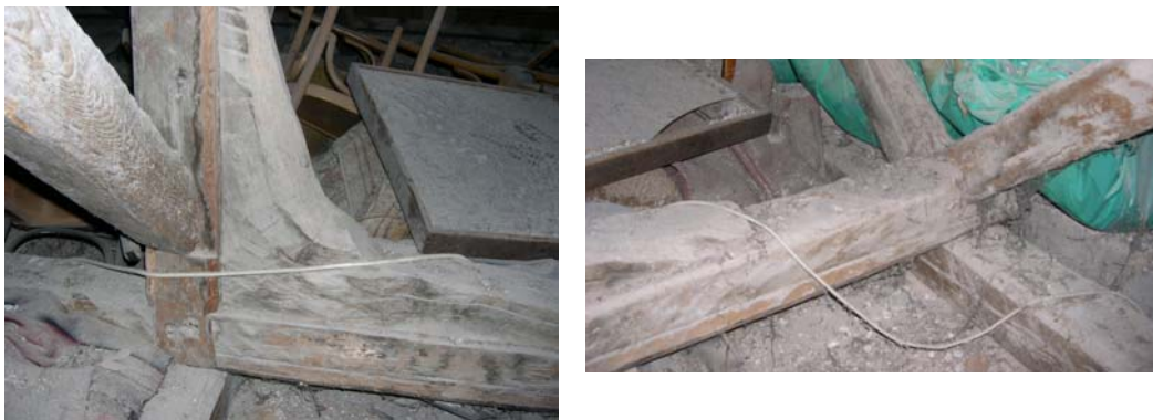
Φωτογραφία 11. Καλωδιώσεις στο εσωτερικό των ξύλινων επιφανειών
