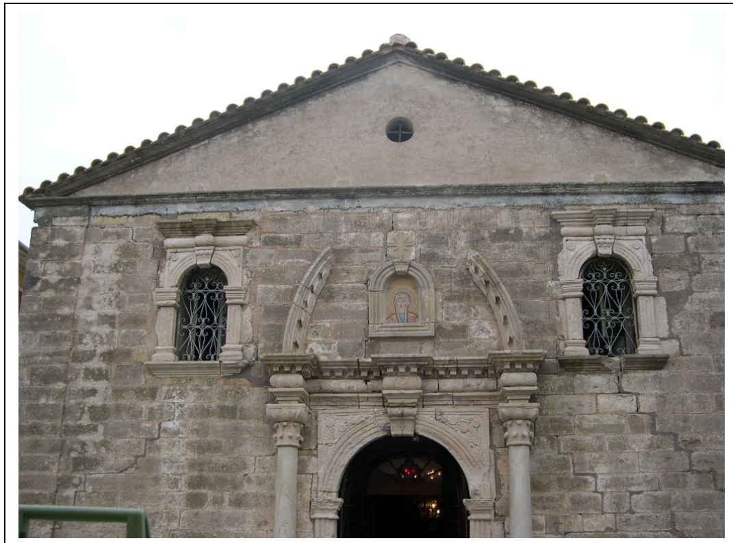
Φωτογραφία 9 Δυτική όψη, αέτωμα από τουβλοδομή με κεντρική οπή και επίχρυσμα. Εμφανές διάζωμα από σπλισμένο σκυρόδεμα στην βάση του αετώματος.
