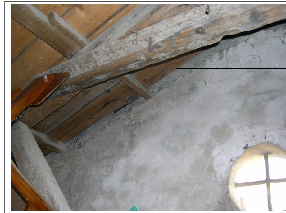
Φωτογραφία 51 : Εσωτερικό επίχρισμα αετώματος δυτικά Εμφανές επικλινές διάζωμα από οπλισμένο σκυρόδεμα
