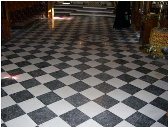
Φωτογραφία 6.. Αποψη δαπέδου
