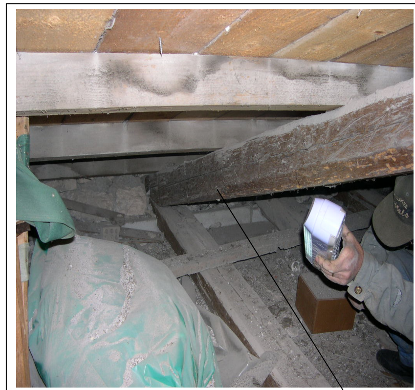
Φωτογραφία 42 : Διαζωμάτωση στέγης
