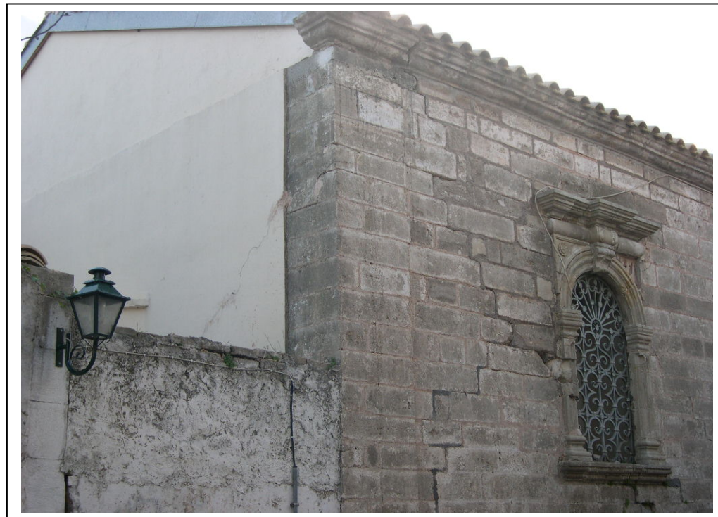
Φωτογραφία 30 : Ρηγματώσεις βορειοανατολικά του Ναού.
