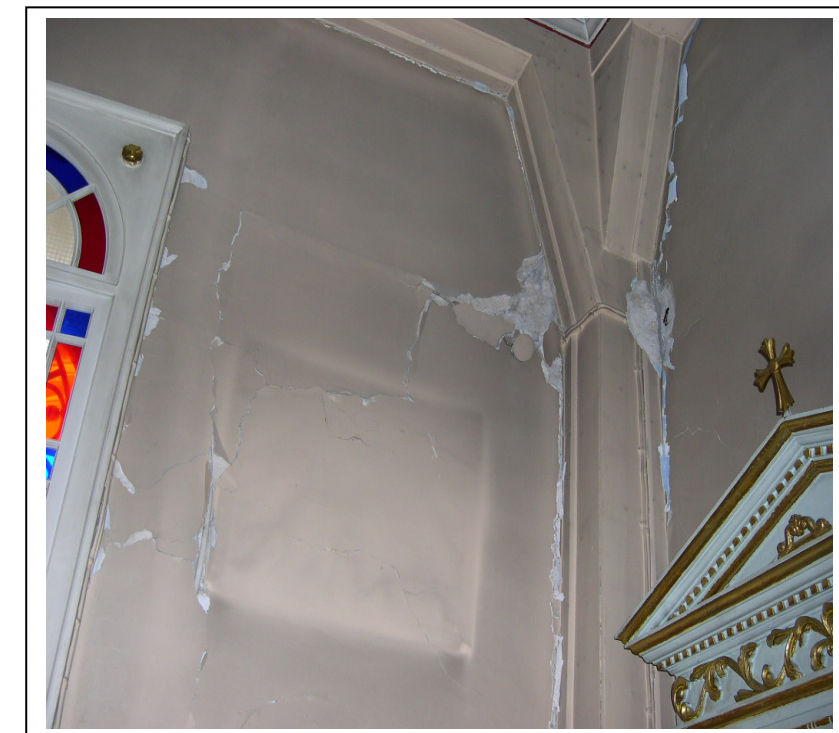
Φωτογραφία 36 : Φέρων ξύλινος στύλος στέγης με γωνιακές ξύλινες ενισχύσεις στο χώρο του Ιερού
