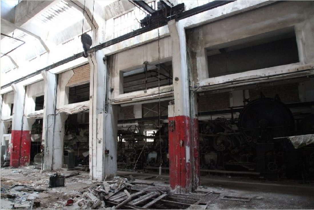
Φωτ. 17 - Υποστυλώματα στήριξης με προεξοχές, καταμήκος του τομέα Δ.
