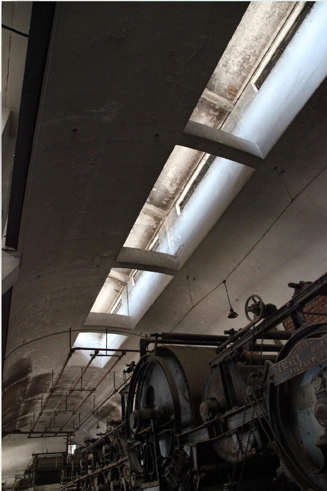
Φωτ. 9 - Στέγη τομέα Γ
