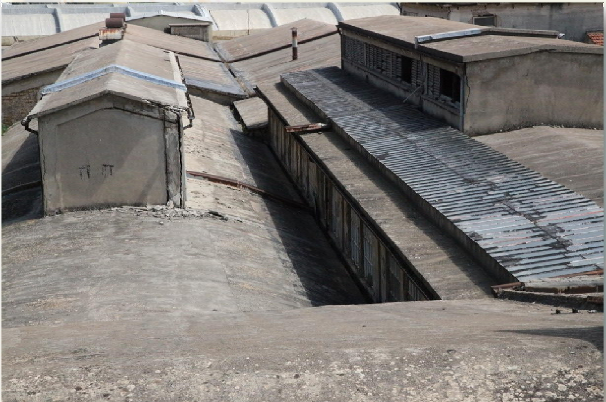
Φωτ. 6 - Υπερυψωμένα τμήματα στις στέγες των τομέων Γ και Δ.
