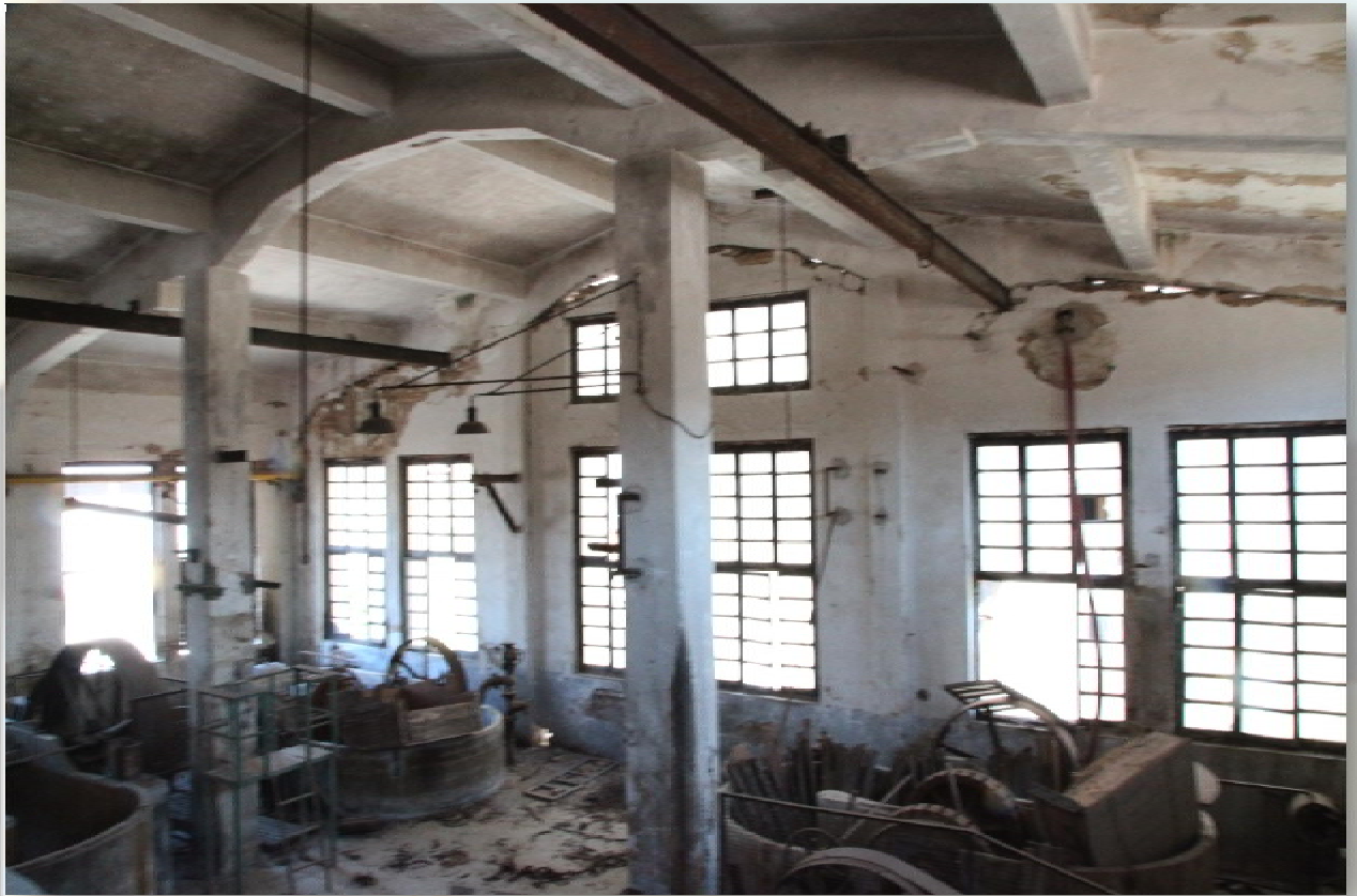
Φωτ. 5 – Εσωτερικό του ορόφου του τομέα
