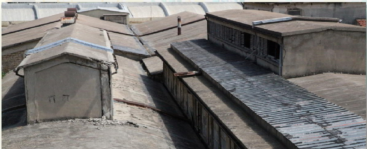
Φωτ. 18 – Στέγες των τομέων Γ – Δ και στο βάθος στέγες των Ε - Ζ
