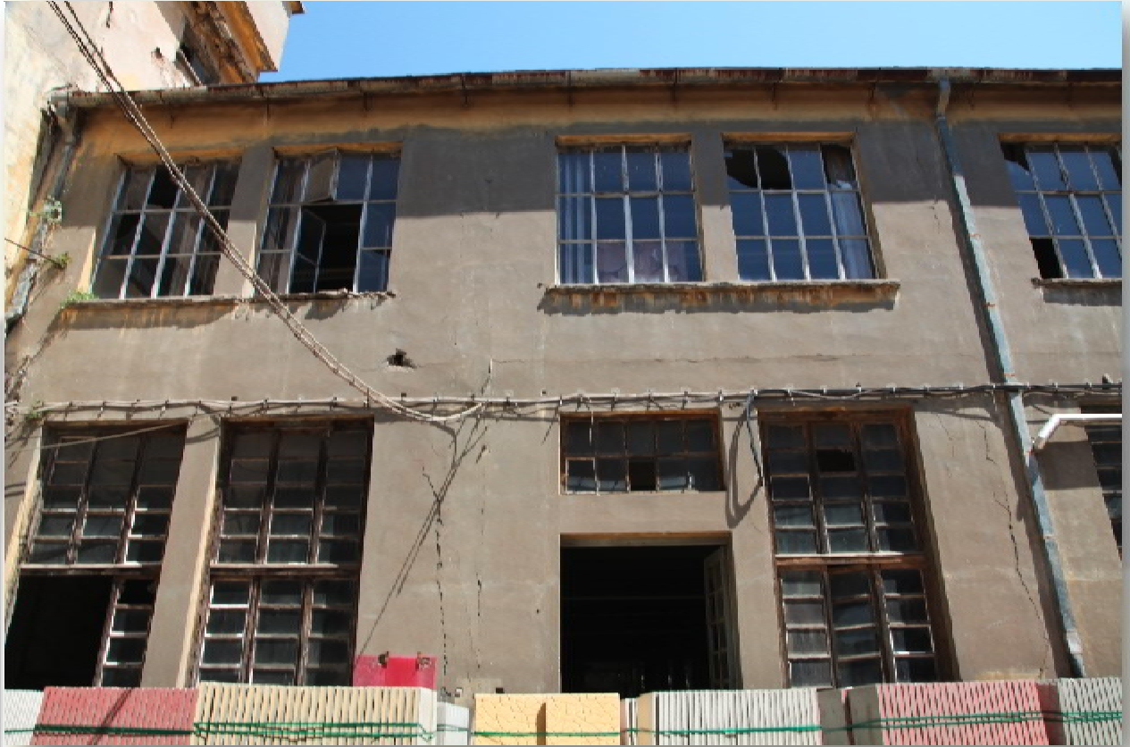
Φωτ. 21 – διάφοροι τύποι παραθύρων και κουφωμάτων στις όψεις του κτιρίου
